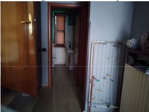
P.T. locali lato Est: disimpegno, vista verso il bagno
