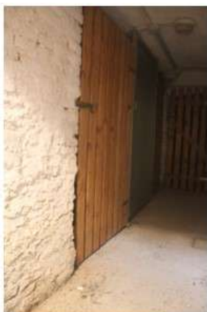
Foto 5-O: ingresso alla cantina
