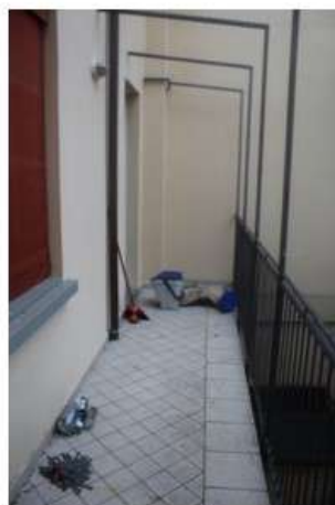
Foto 3-N: terrazzo – vista verso sud
