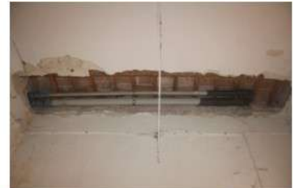
Foto 12-A 13-A e 14-A: parziali demolizioni del cannicciato di copertura della zona uffici, presumibilmente effettuate per ispezioni/riparazioni sugli impianti dell'unità posta al piano superiore – non oggetto della presente relazione
