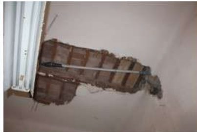
Foto 12-A 13-A e 14-A: parziali demolizioni del cannicciato di copertura della zona uffici, presumibilmente effettuate per ispezioni/riparazioni sugli impianti dell'unità posta al piano superiore – non oggetto della presente relazione
