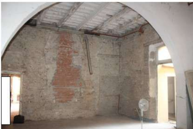
Foto 6-A: magazzino parte anteriore verso l'ufficio
