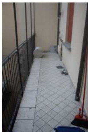
Foto 3-M: terrazzo – vista verso nord
