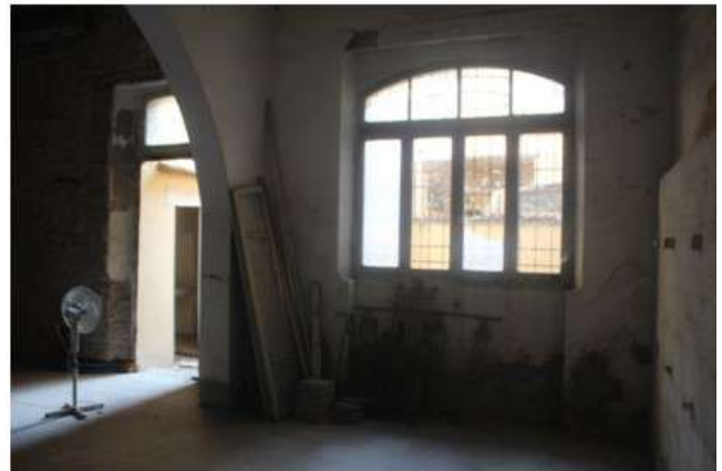
Foto 5-A: zona magazzino accesso alla corte
