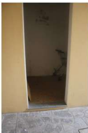
Foto 8-L: ingresso allo sgombero dal cortile comune
