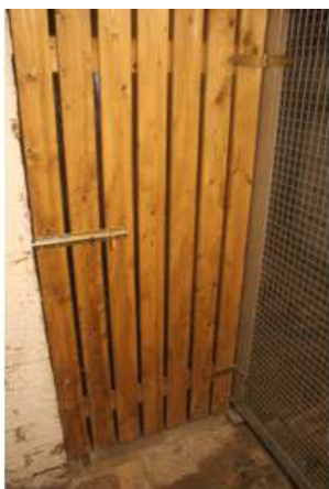
Foto 8-N: ingresso alla cantina
