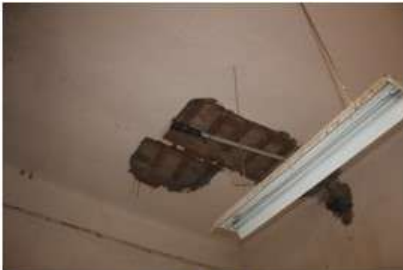
Foto 12-A 13-A e 14-A: parziali demolizioni del cannicciato di copertura della zona uffici, presumibilmente effettuate per ispezioni/riparazioni sugli impianti dell'unità posta al piano superiore – non oggetto della presente relazione
