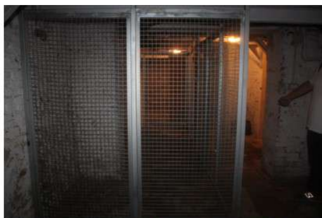
Foto 9-Q: cantina con pareti in parte in grigliato
