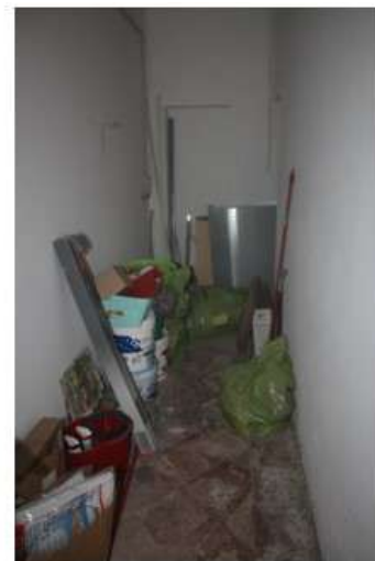
Foto 4-P: interno del vano
