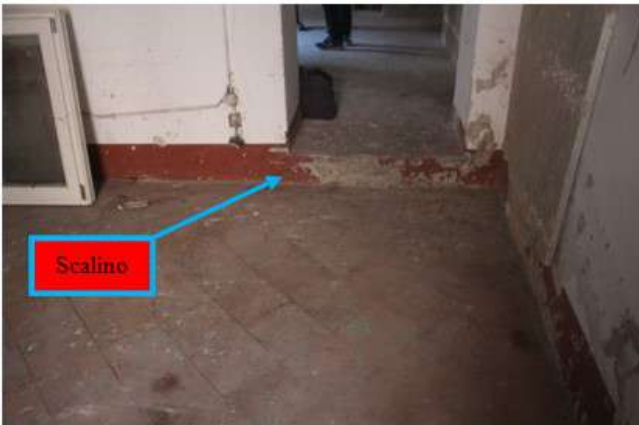
Foto 4-A: zona ufficio verso il magazzino
