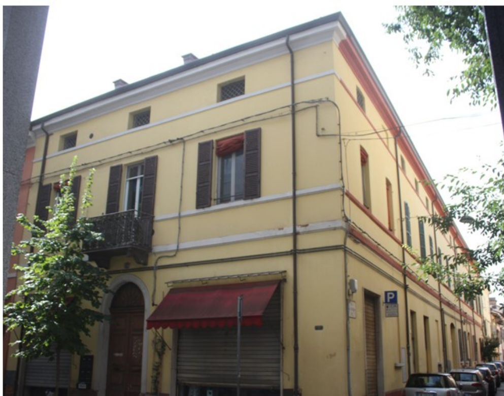
Foto 1: prospetto principale su Corso Diaz e di scorcio prospetto su via Nathan Levi
