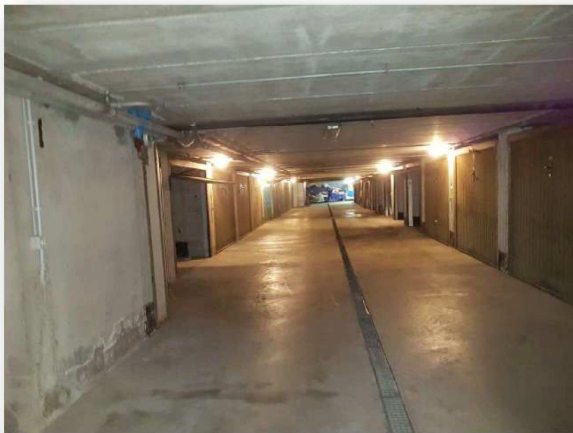
Foto n. 17 - spazio di manovra
