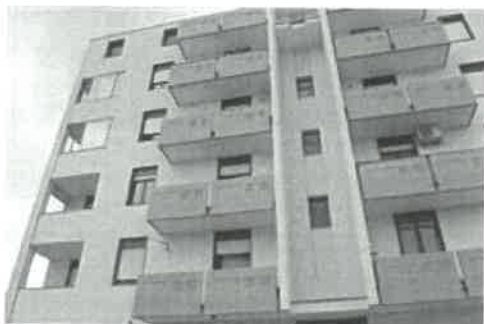
Foto 1 - vista del fabbricato
