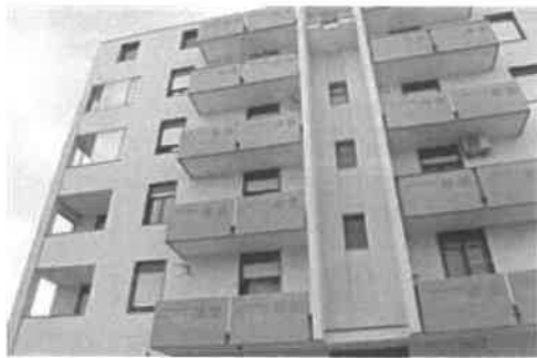
Foto 1 - vista del fabbricato
