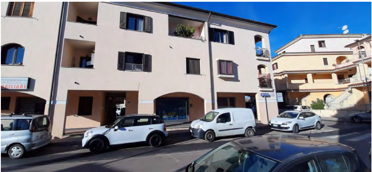
Foto n°3 vista via Lucania
