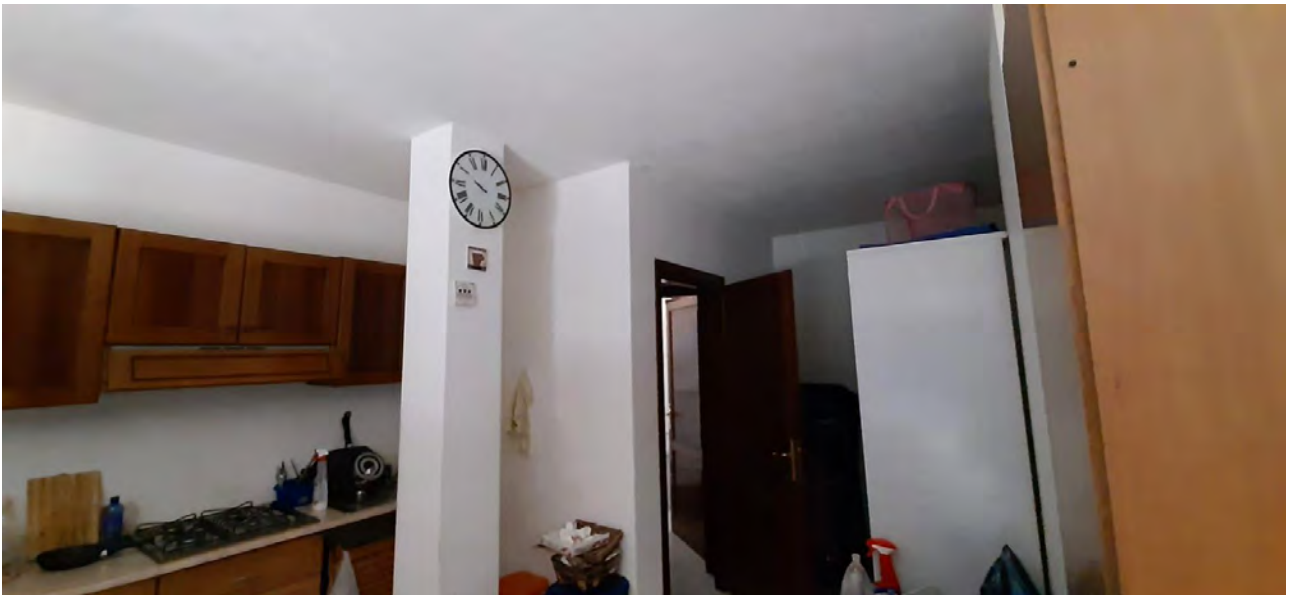
Foto n°12 vista ingresso antibagno e bagno
