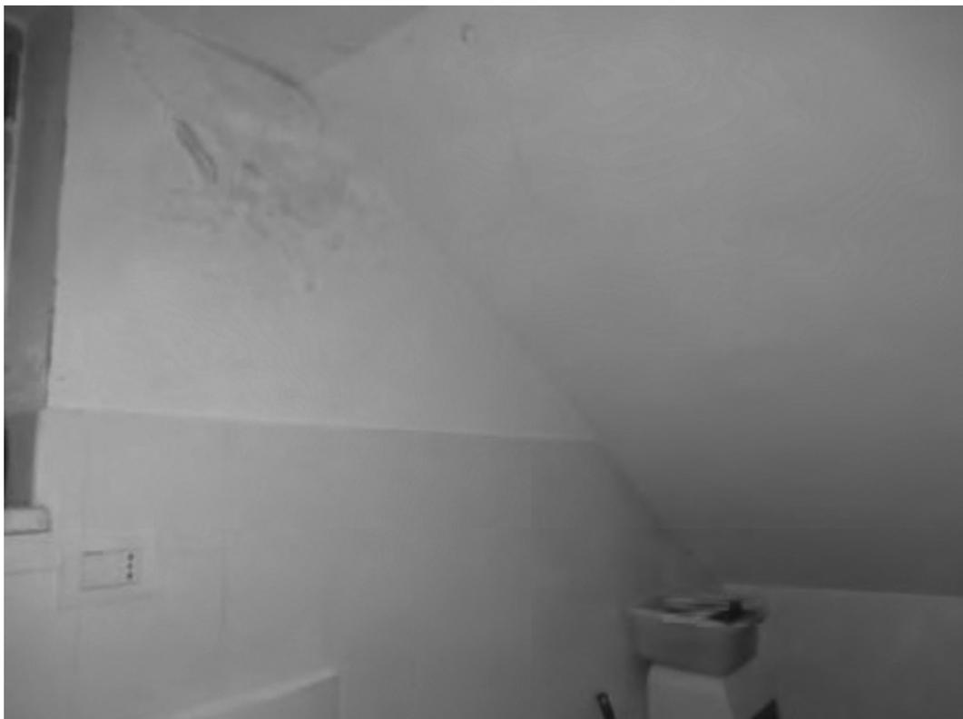
*Foto n° 36 – Locale pertinenza piano seminterrato subalterno n. 12 – vista particolare servizio igienico in sottoscala – presenza di umidità diffusa – Foto 18.03.2023*
