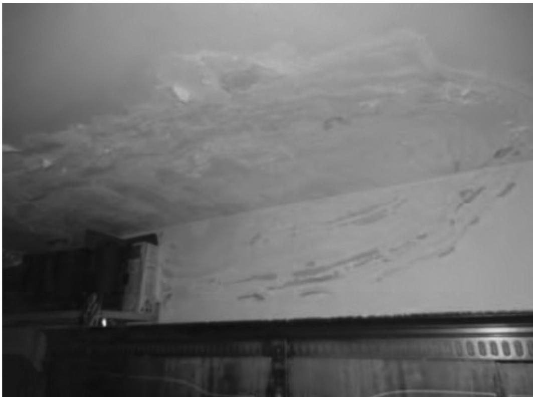
*Foto n° 42 – Locale pertinenza piano seminterrato subalterno n. 12 – vista particolare soffitto – presenza di umidità diffusa – Foto 18.03.2023*
