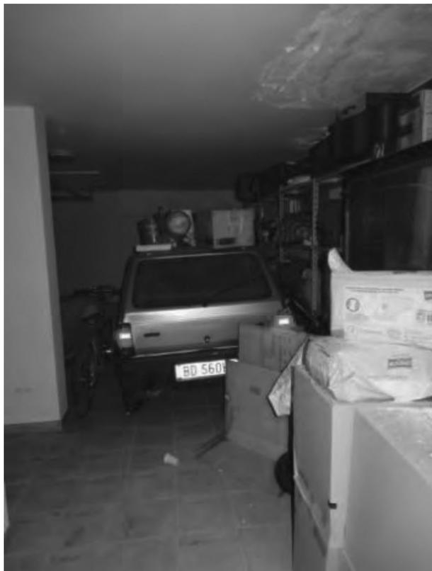
*Foto n° 41 – Locale pertinenza piano seminterrato subalterno n. 12 – vista particolare soffitto – presenza di umidità diffusa – Foto 30.09.2022*
