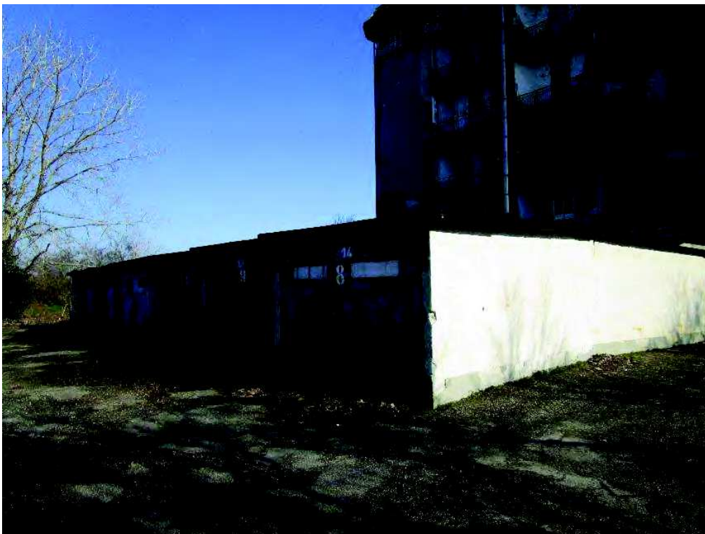
32. Fabbricato per box, lato ovest.
