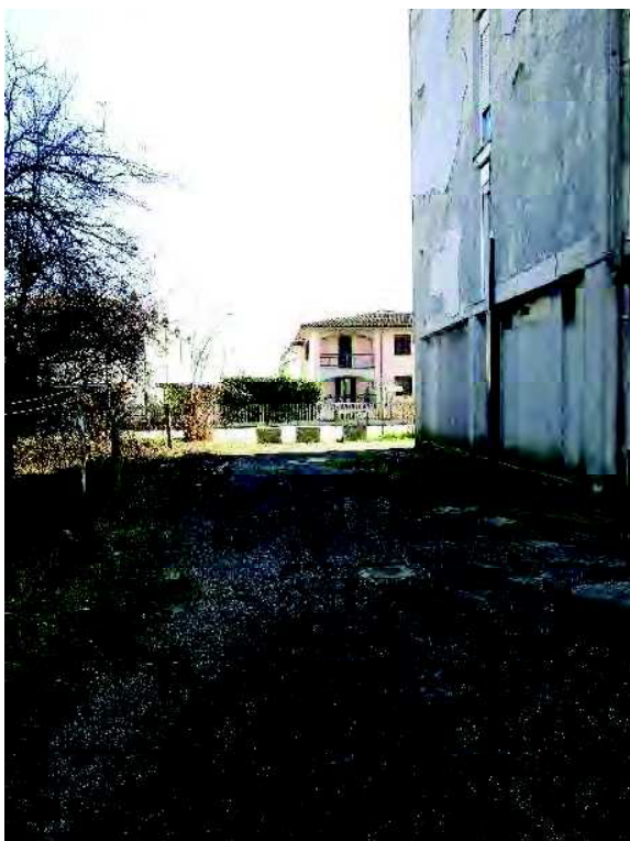
5. Area cortilizia, lato nord.
