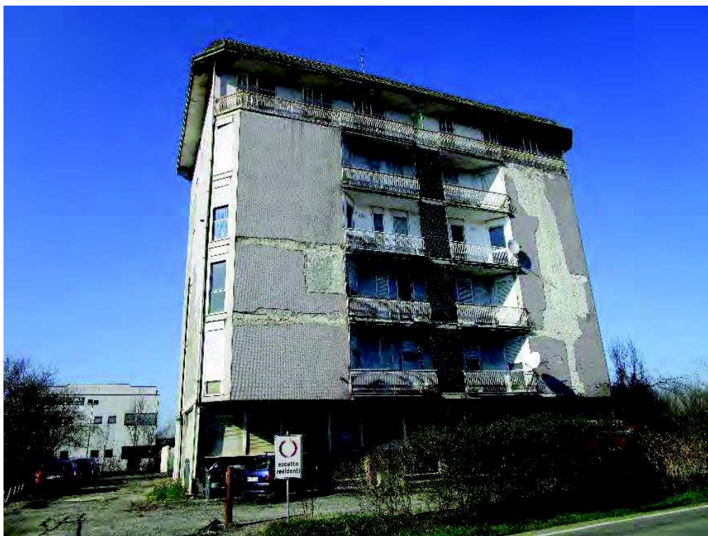
2. Fabbricato, vista da Via Vigevano lato sud-est.
