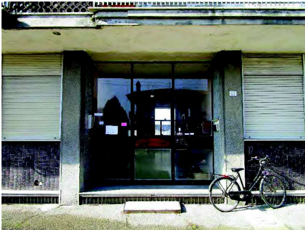
7. Accesso al fabbricato.
