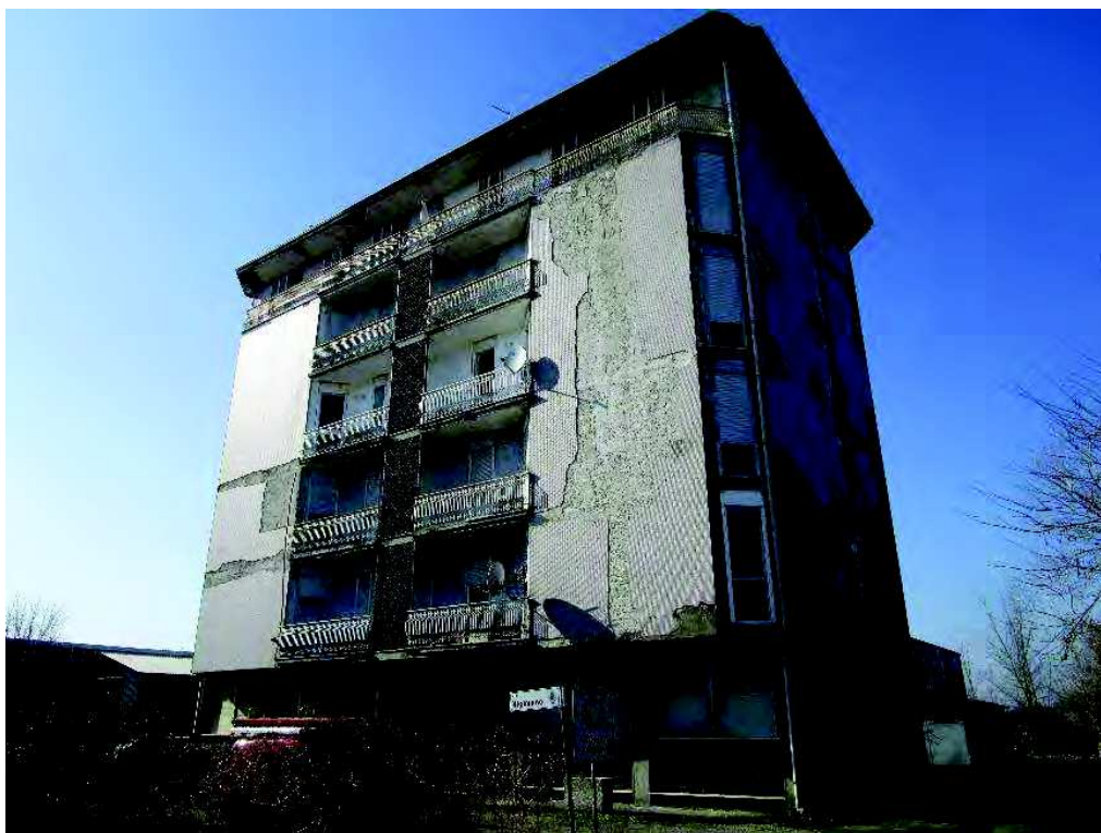
1. Fabbricato, vista da Via Vigevano lato nord-est.
