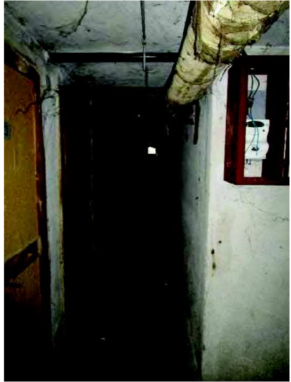
29. Corridoio di accesso alle cantine.
