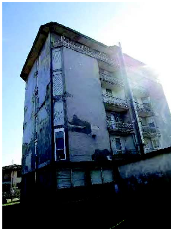
4. Fabbricato, lato nord-ovest.
