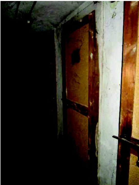
30. Ingresso per la cantina
