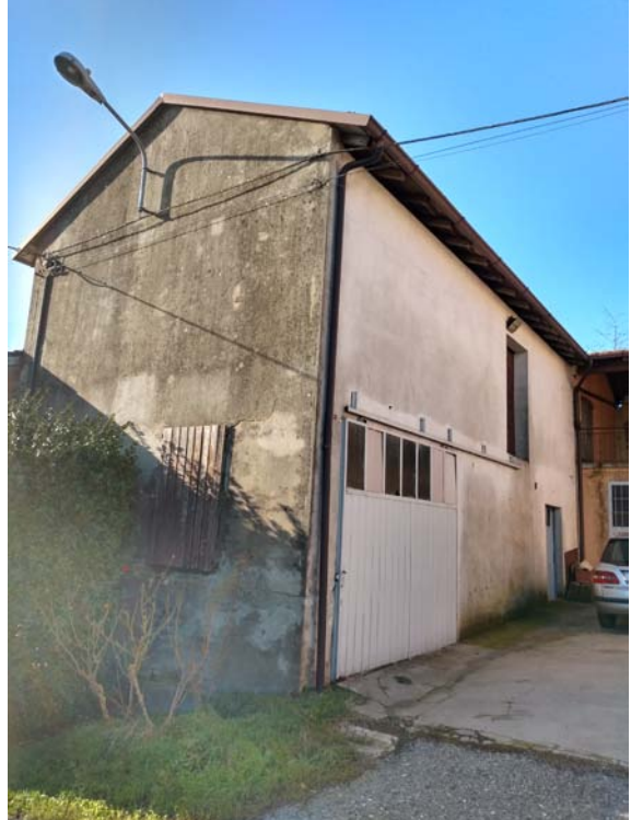
Immagine 28 - Vista esterna del corpo di fabbrica in cui si trova il deposito al piano primo
