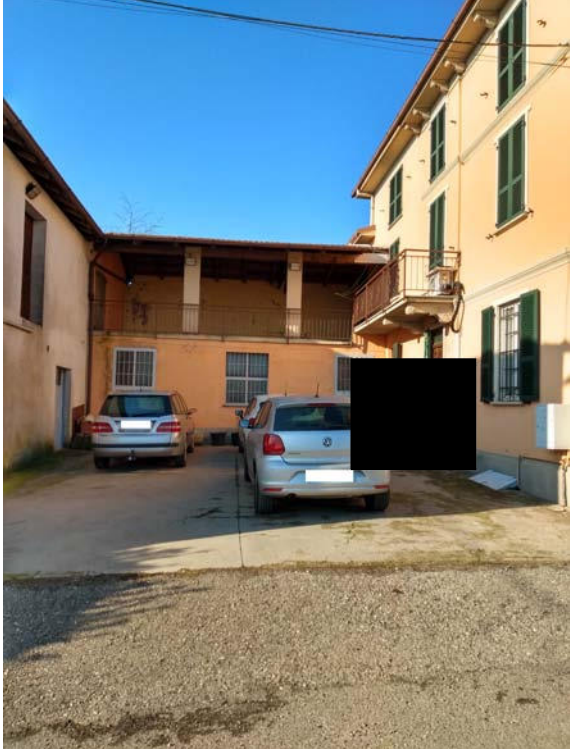
Immagine 27 - Vista dei fabbricati dalla strada vicinale
