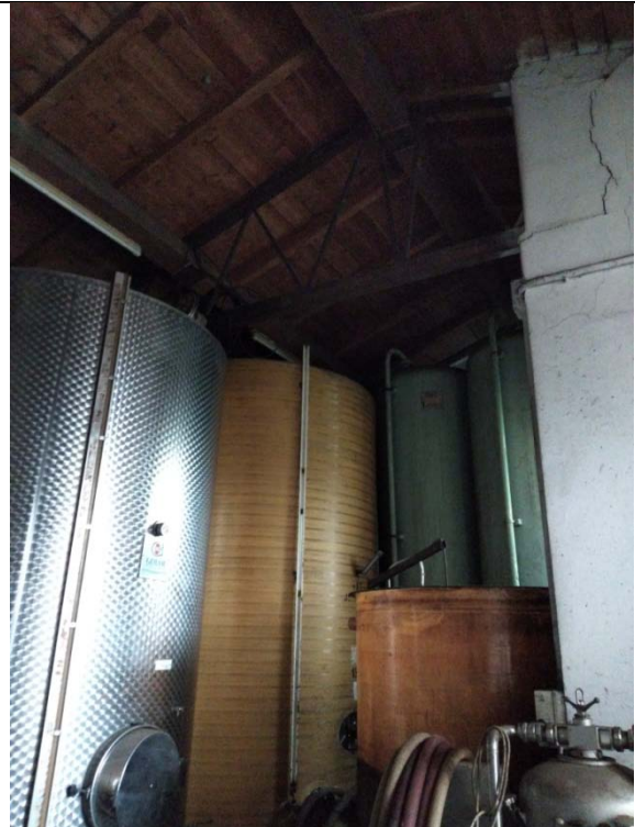
Immagine 4 - Vista interna del deposito
