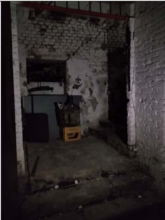
Immagine 35 - Corpo scale interno di connessione tra cantina e esterno su fronte strada
