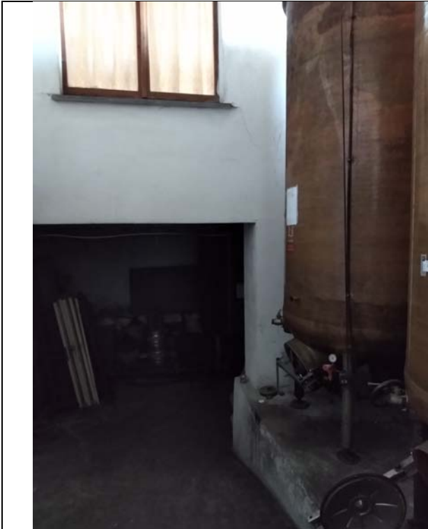
Immagine 33 - Rampa di accesso al locale cantina
