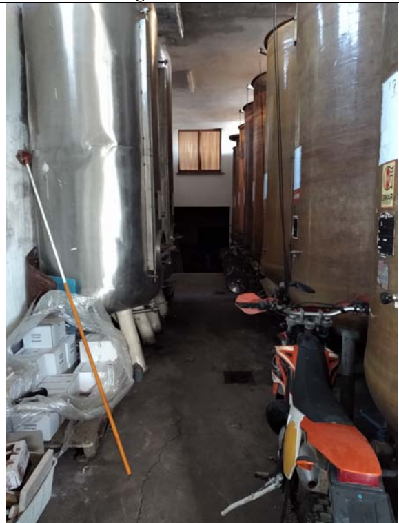
Immagine 32 - Vista con finestra dell'abitazione (2) aperta verso l'interno del laboratorio
