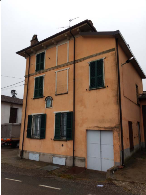
Immagine 1 - Vista esterna dell'abitazione a ridosso della quale si trova il deposito (1)
