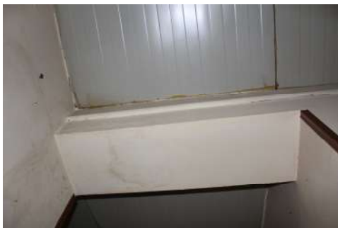
Area di accesso alla lavanderia (Unità "A", Vano 1)
