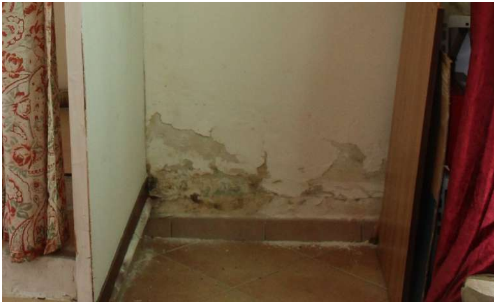
FOTO 45: UNITA' "A": Muratura che separa Veranda da Terrazzo
