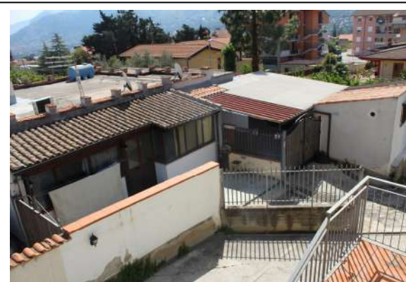
FOTO 4: Area di accesso comune.
