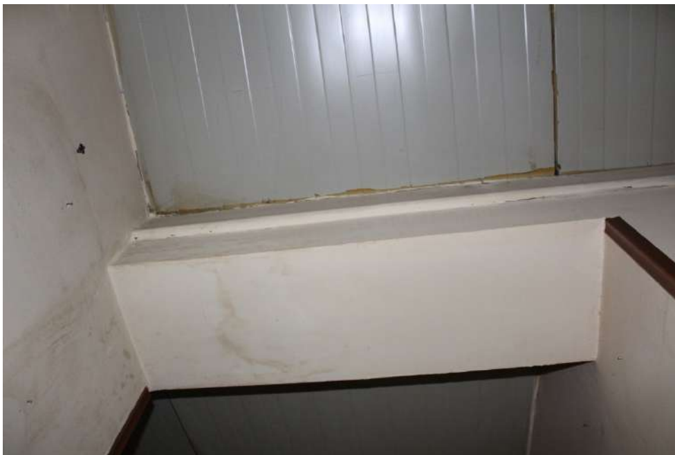
FOTO 41: UNITA' "A": Trave in prossimità del vano 3
