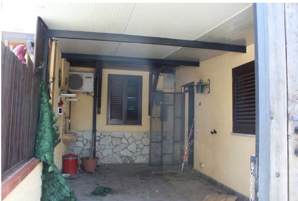
FOTO 8: Spazio esterno di pertinenza dell'unità "A"
