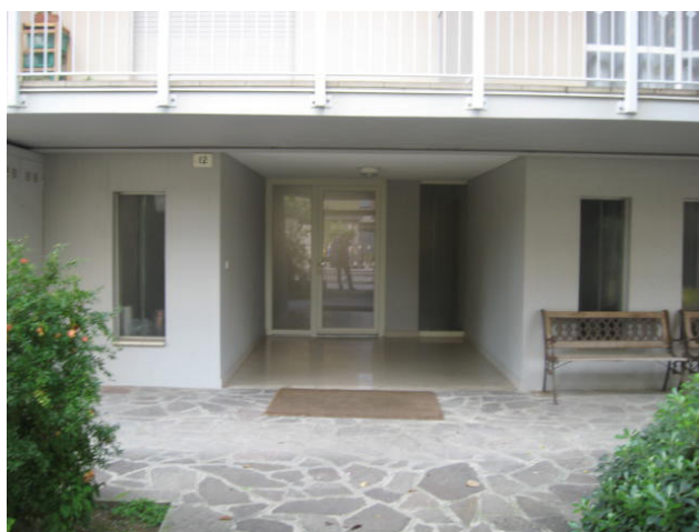
Ingresso comune e prospetto posteriore
