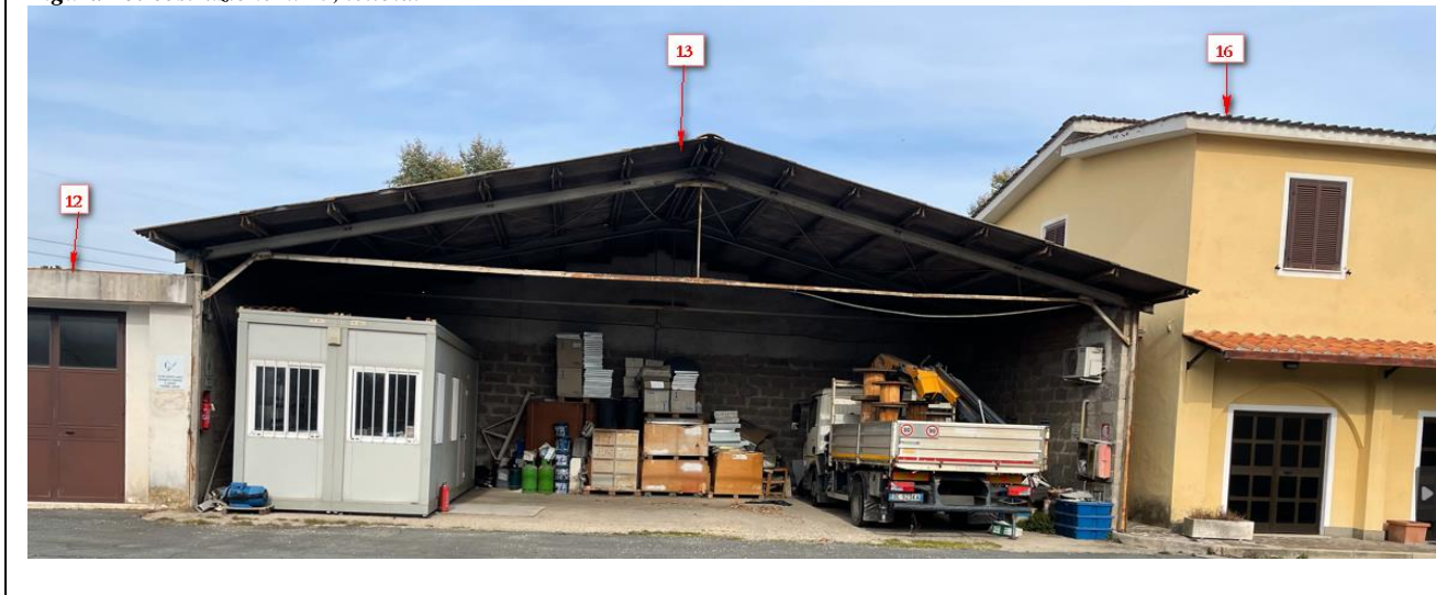
Figura 20: costruzione n. 13, tettoia.
