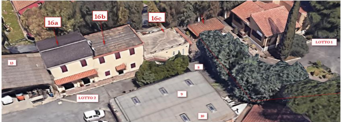
Figura 22: costruzione n.16 a), b), c).
