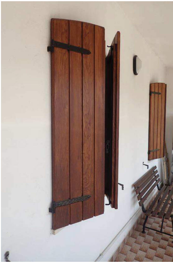
Foto 31 - Particolare infissi esterni
