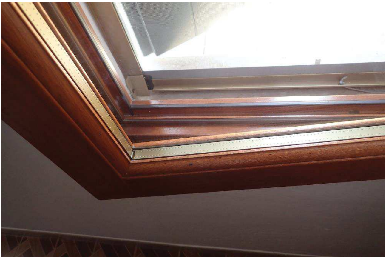
Foto 30 - Particolare infissi interni
