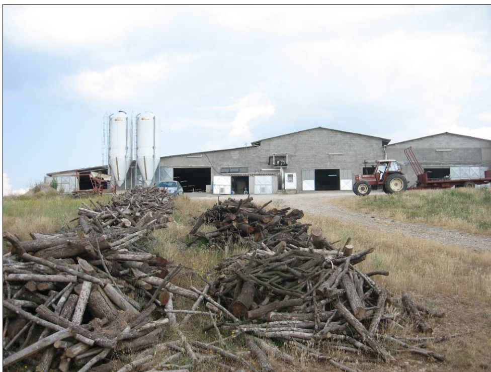
FOTO 2 – La parte sinistra della porzione di fabbricato adibita a stalla per ovini vista dalla corte antistante.
