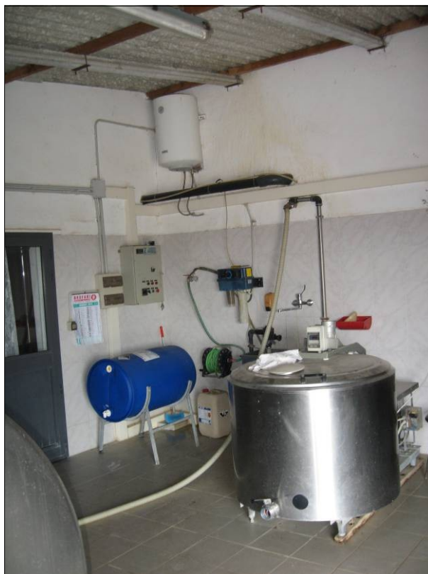
FOTO 8 – Il locale destinato alla refrigerazione del latte munto. Sulla sinistra si scorge la porta che conduce al locale destinato al sorvegliante.
