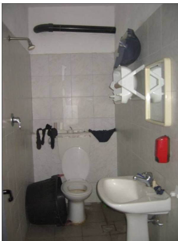
FOTO 10 – Il servizio igienico annesso al locale del sorvegliante.
