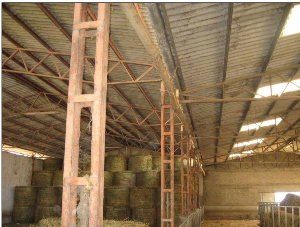
FOTO 12 – L'ovile e il fienile posti a destra della sala mungitura guardando il fronte anteriore del fabbricato.
