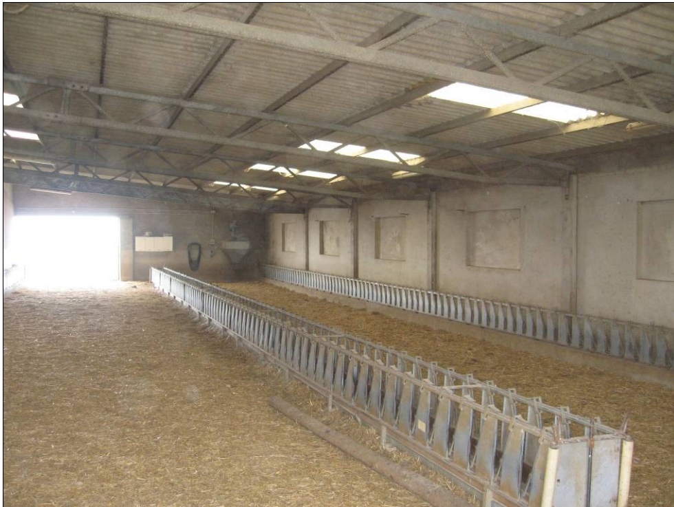
FOTO 5 – L'ovile adiacente alla sala mungitura.
