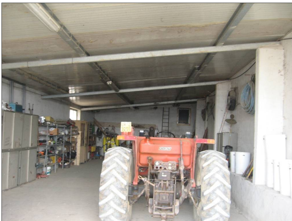
FOTO 4 – L'officina posta all'estrema sinistra della porzione di fabbricato rurale. La struttura portante è in elementi prefabbricati.
