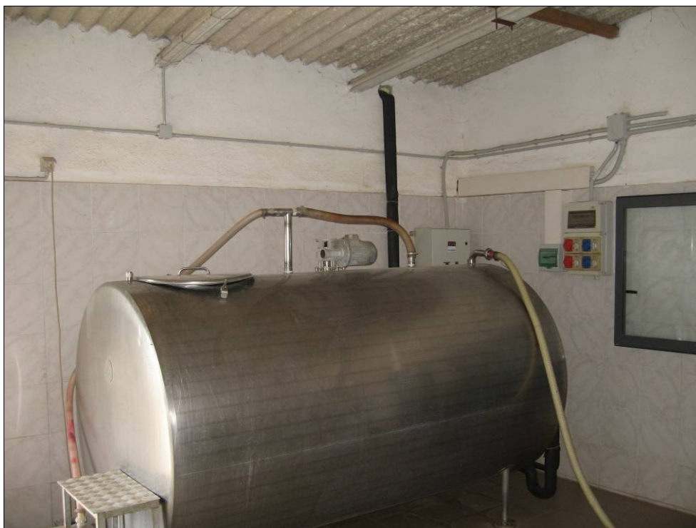
FOTO 7 – Il locale destinato alla refrigerazione del latte munto.
