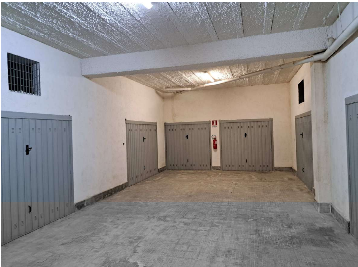
Foto n. 18 – Vista del piano cantinato e del box auto (vedi cono ottico - allegato J)
