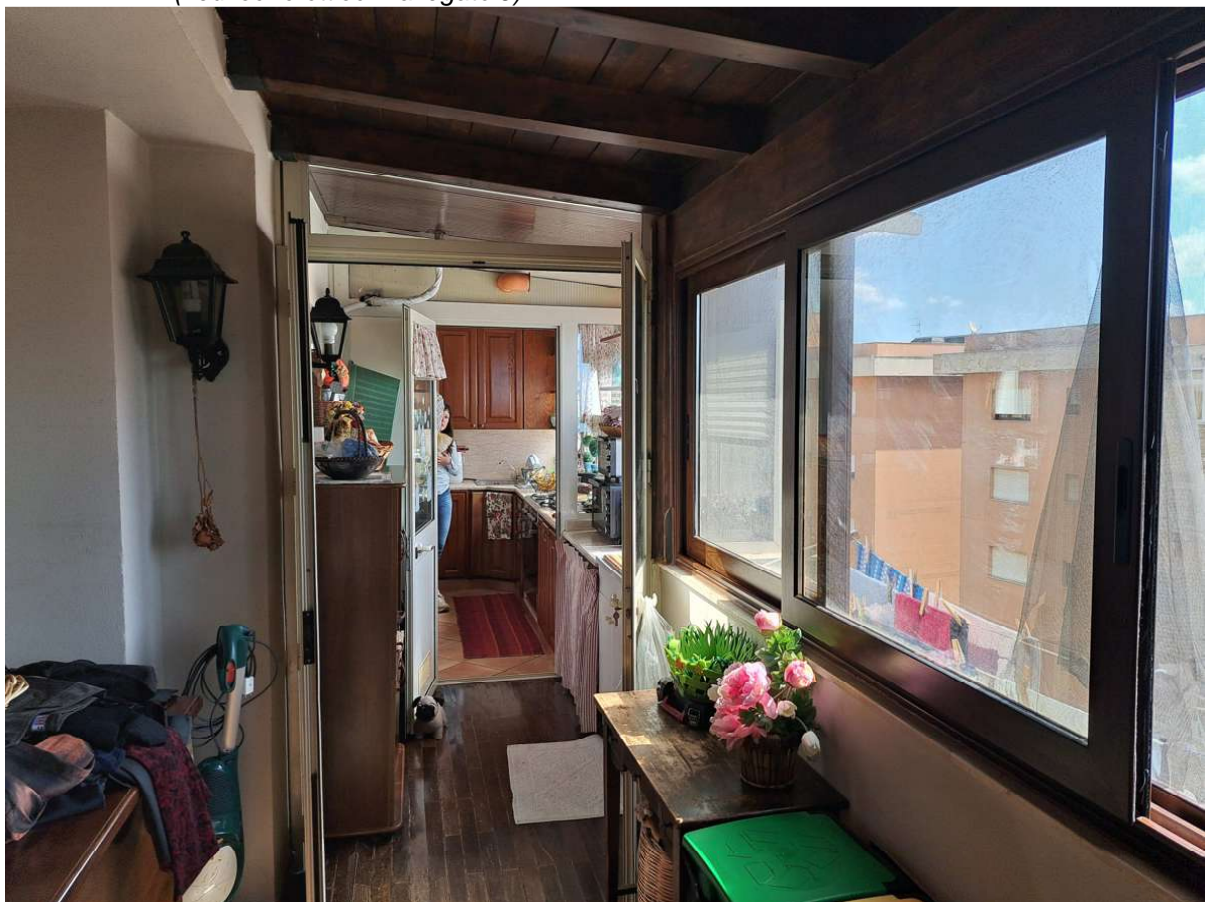
Foto n. 10 – Parte di balcone chiuso con struttura precaria (vedi cono ottico - allegato J)
