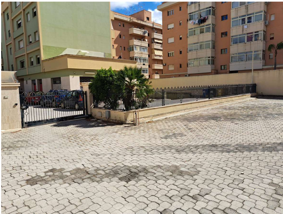
Foto n. 15 – Vista dal cortile comune del posto auto di pertinenza esclusiva dell'appartamento
