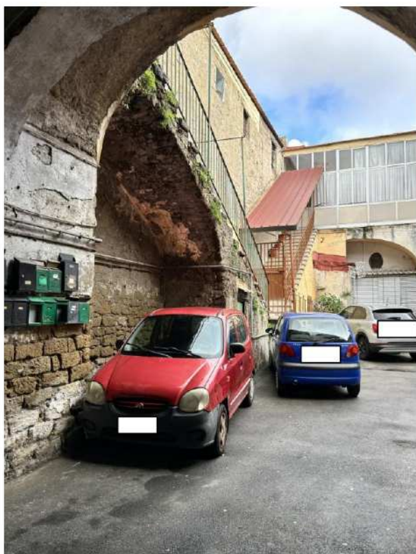
Foto n. 2 – Cortile e rampa scala di accesso
