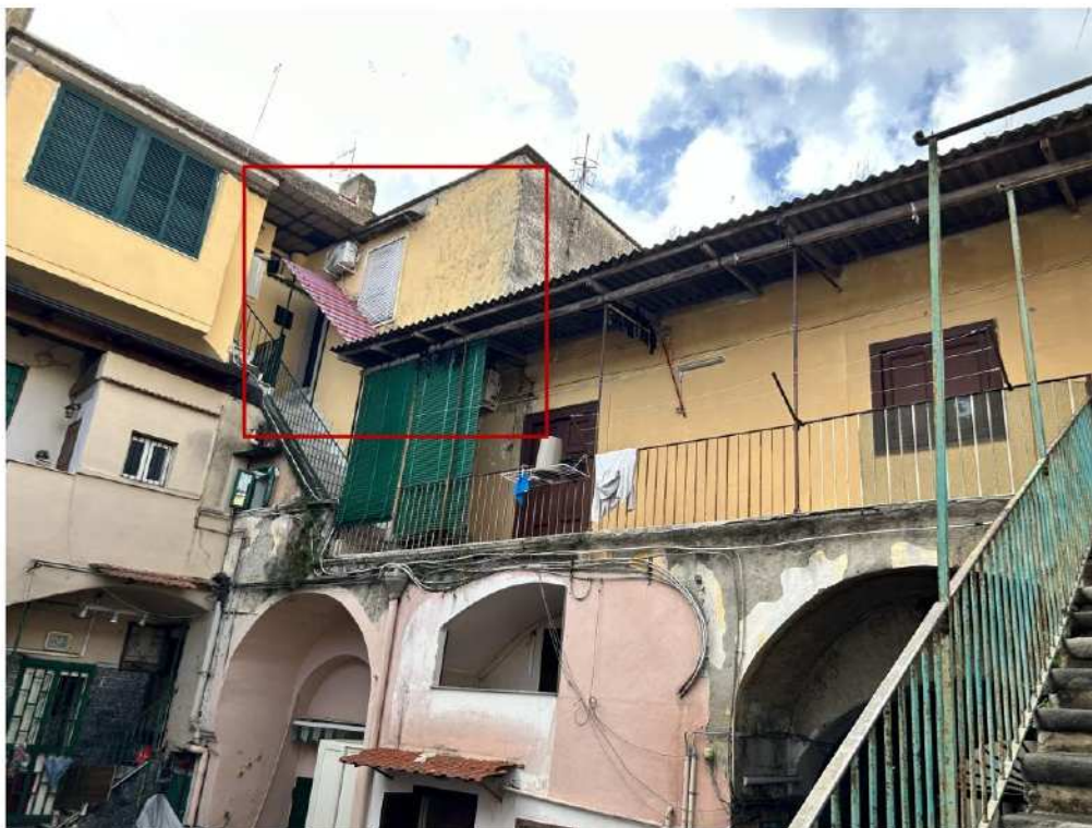
Foto n. 4 – Cortile rampa scala e ballatoio di accesso
