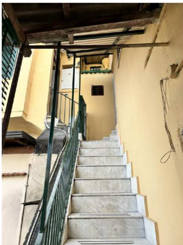
Foto n. 5 – Rampa scala di accesso
