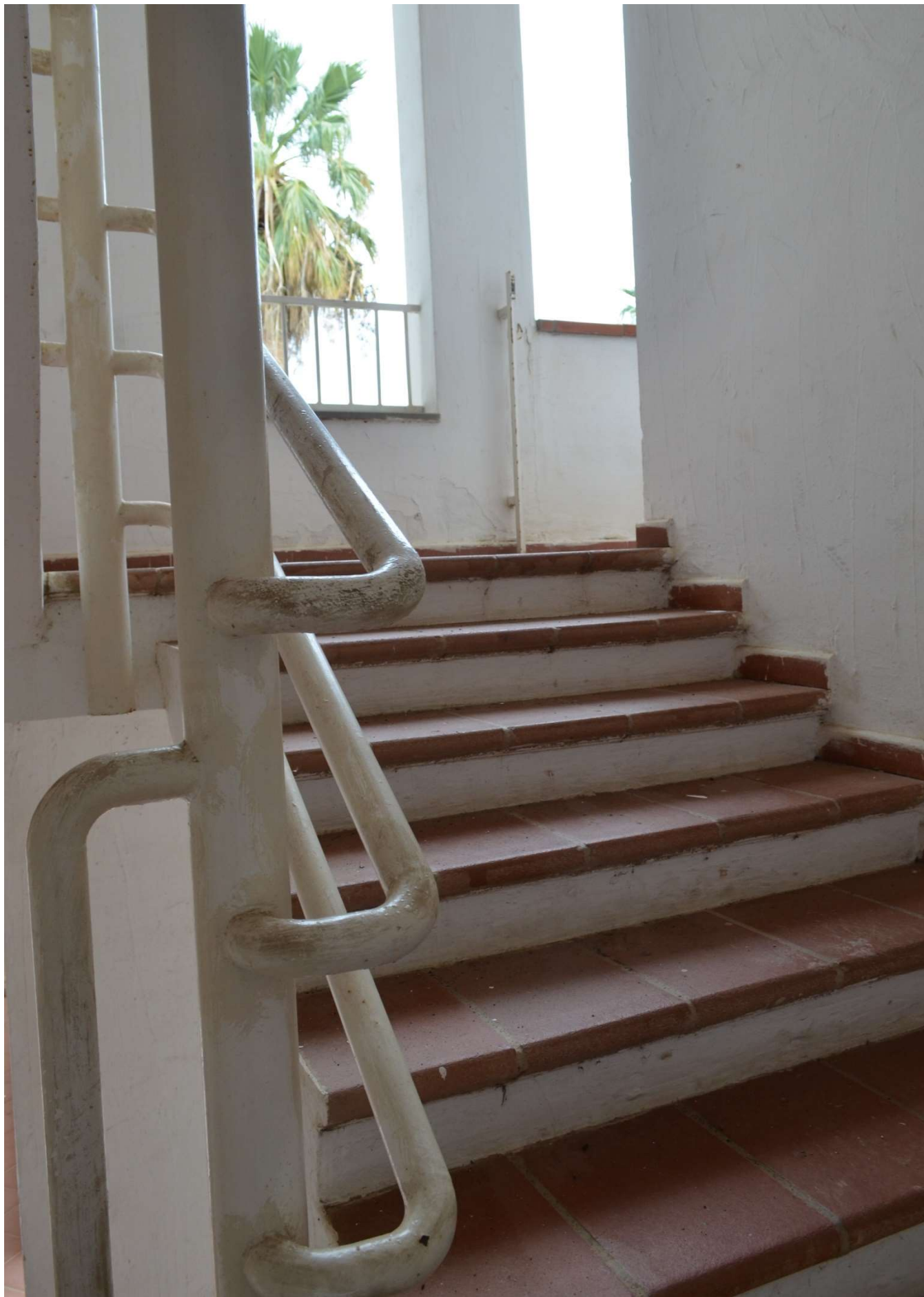
Foto n.7 Rampa di scala che collega il piano terra al piano primo
