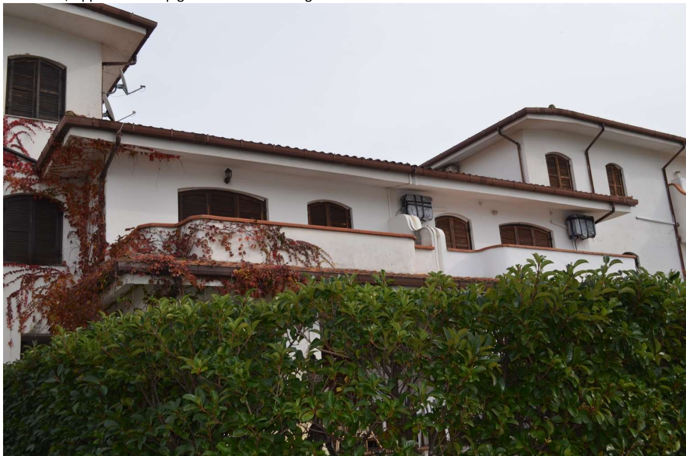
Foto n. 23; Appartamento pignorato visto dalla laguna
