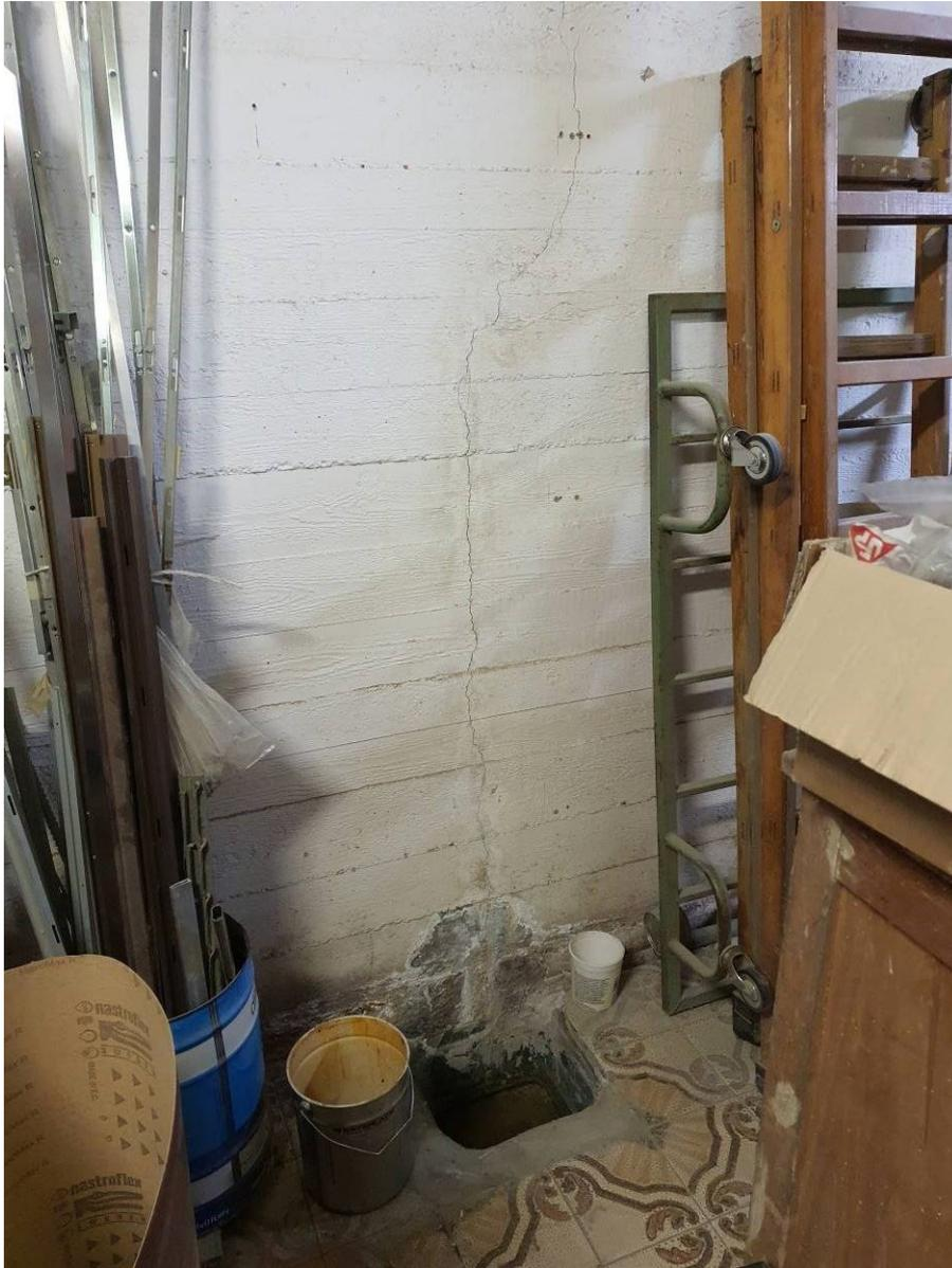
*Foto 43 – Fessurazione setto in c.a. controterra.*
