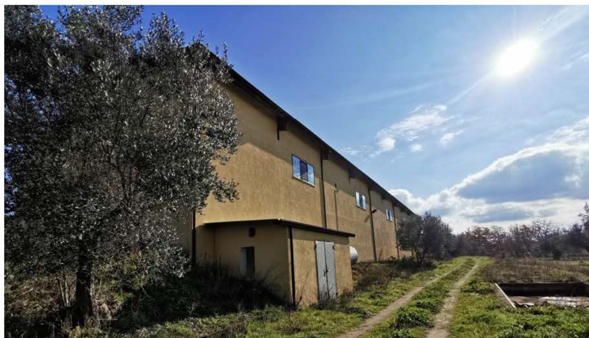
Figura 3 – Capannone _ Prospetto Ovest
