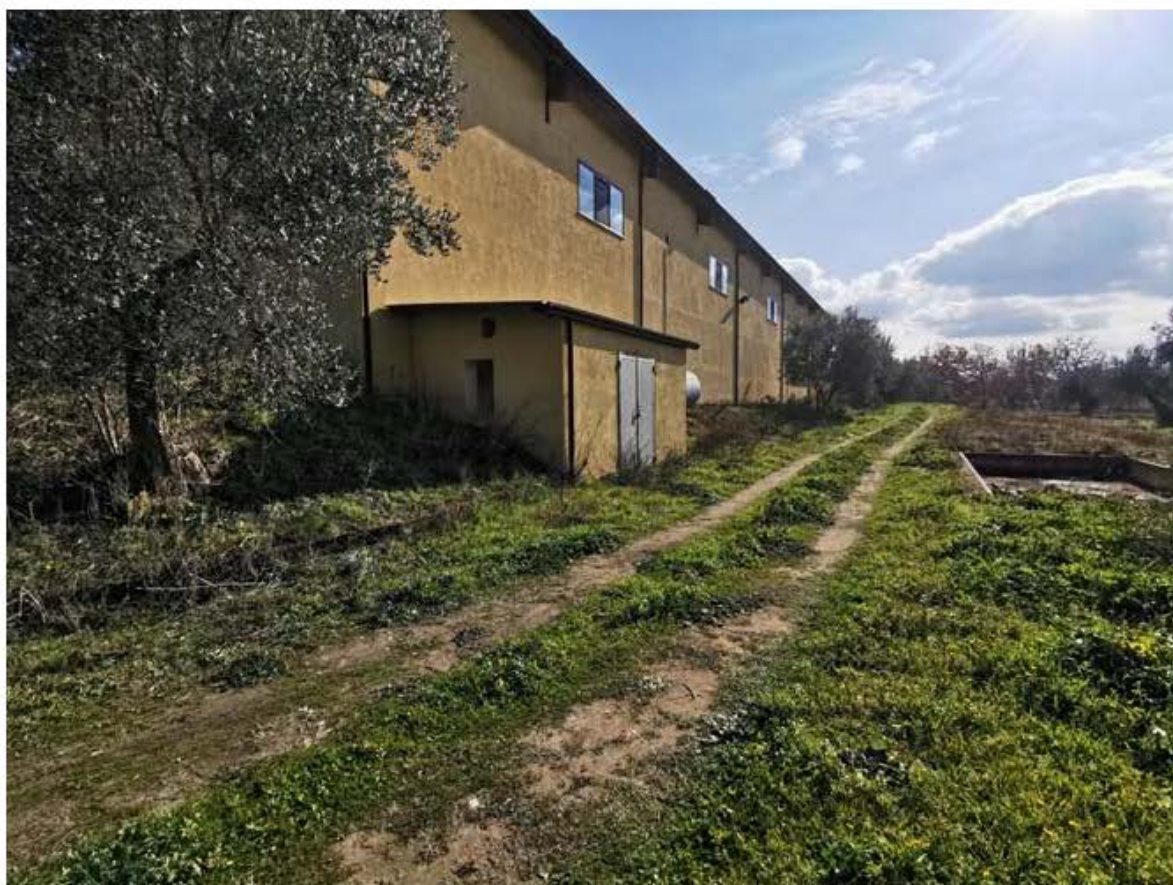
Figura 5 – Area esterna confine Ovest
