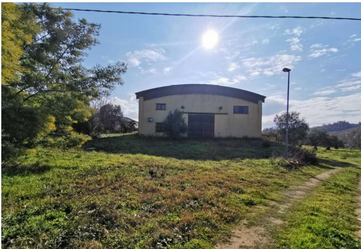
Figura 6 – Area esterna confine Nord
