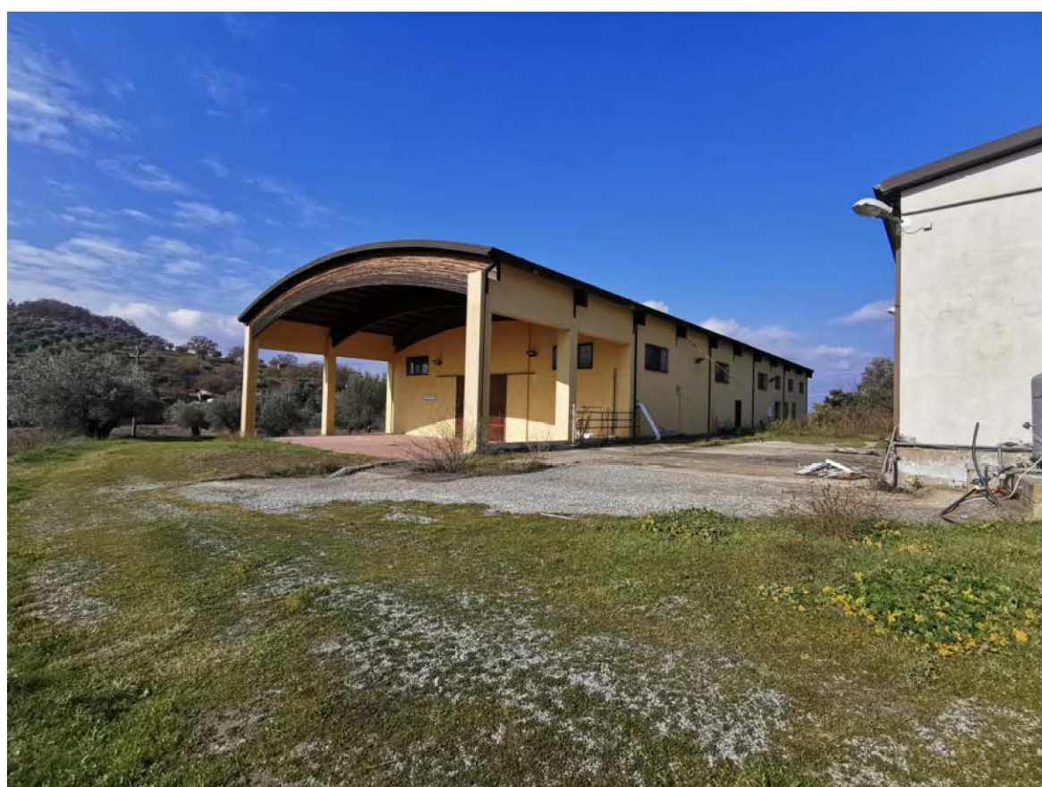
Figura 7 – Area esterna confine Sud
