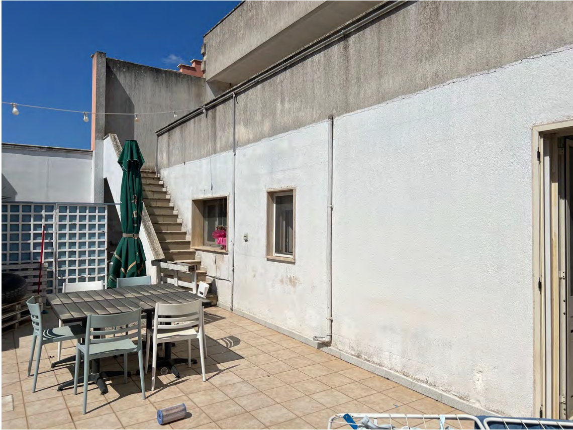
Foto 13 – Scoperto posteriore piano seminterrato
