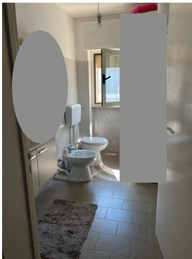
Foto 15 – WC piano seminterrato
