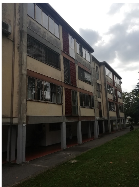
Foto 2: vista condominio fronte
