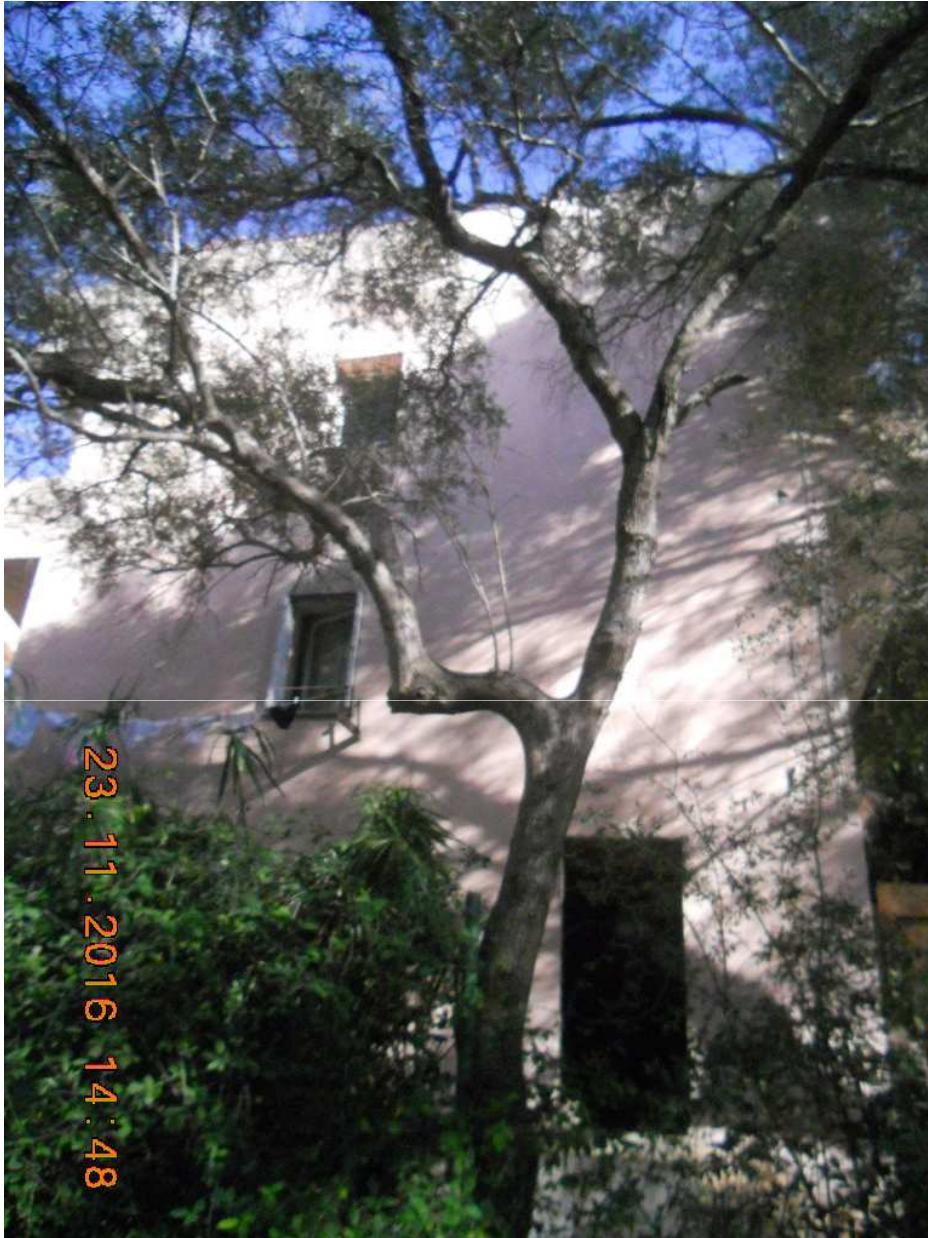
Foto 8. Prospetto a sud-ovest verso il Rio Cala Chiesa
