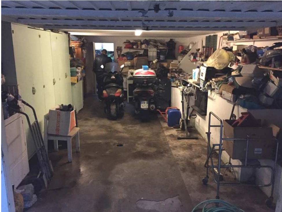
Foto 52. Interno magazzino, vista verso il retro in cui è stata realizzata un'apertura abusiva
