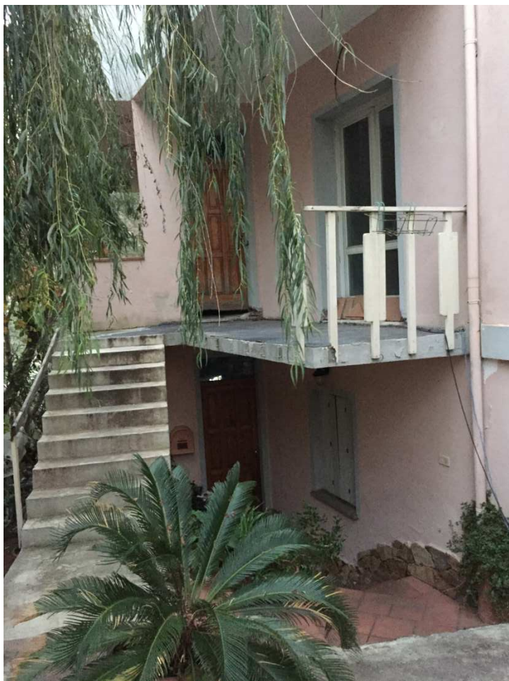
Foto 14 ( Sub.2 ) Scala esterna
