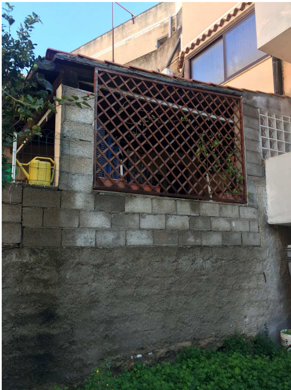
Foto 2b. Muro presente a confine, visibile sul retro del fabbricato dal cortile .
