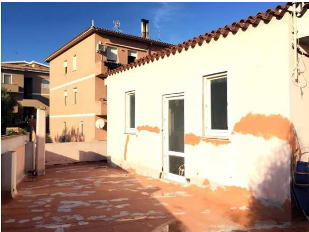
Foto 31. (Sub 2) Facciata esposta ad sud-ovest
