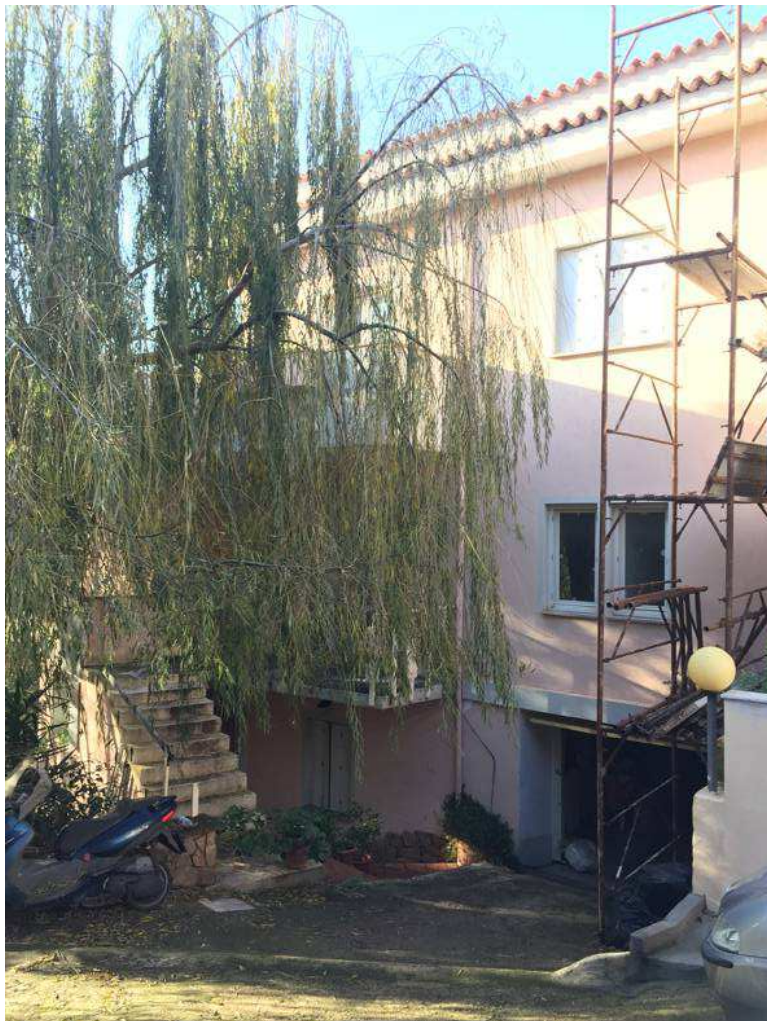
Foto 6. Prospetto principale del fabbricato
