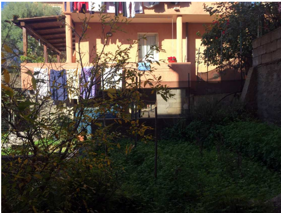
Foto 4a. Edificio confinante a nord-ovest, oltre il terreno di pertinenza
