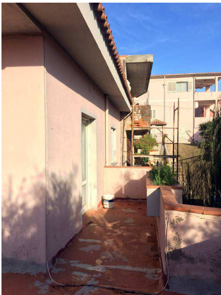
Foto 32. (Sub 2) Veranda, lato esposto a sud-est
