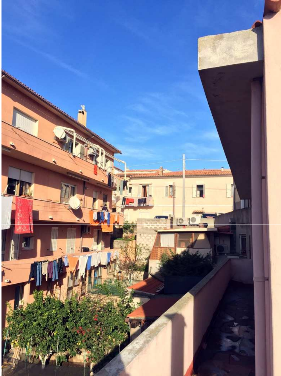
Foto 4b. Edificio a nord – ovest, visibile dal retro del fabbricato
