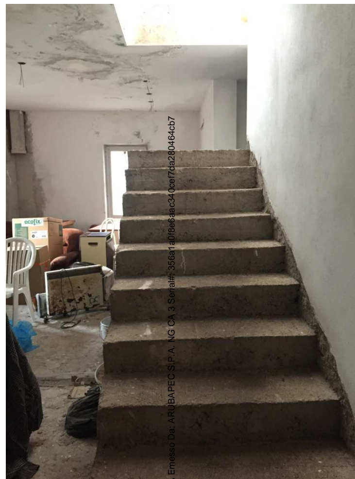
Foto 15. (Sub.2). Scala interna
