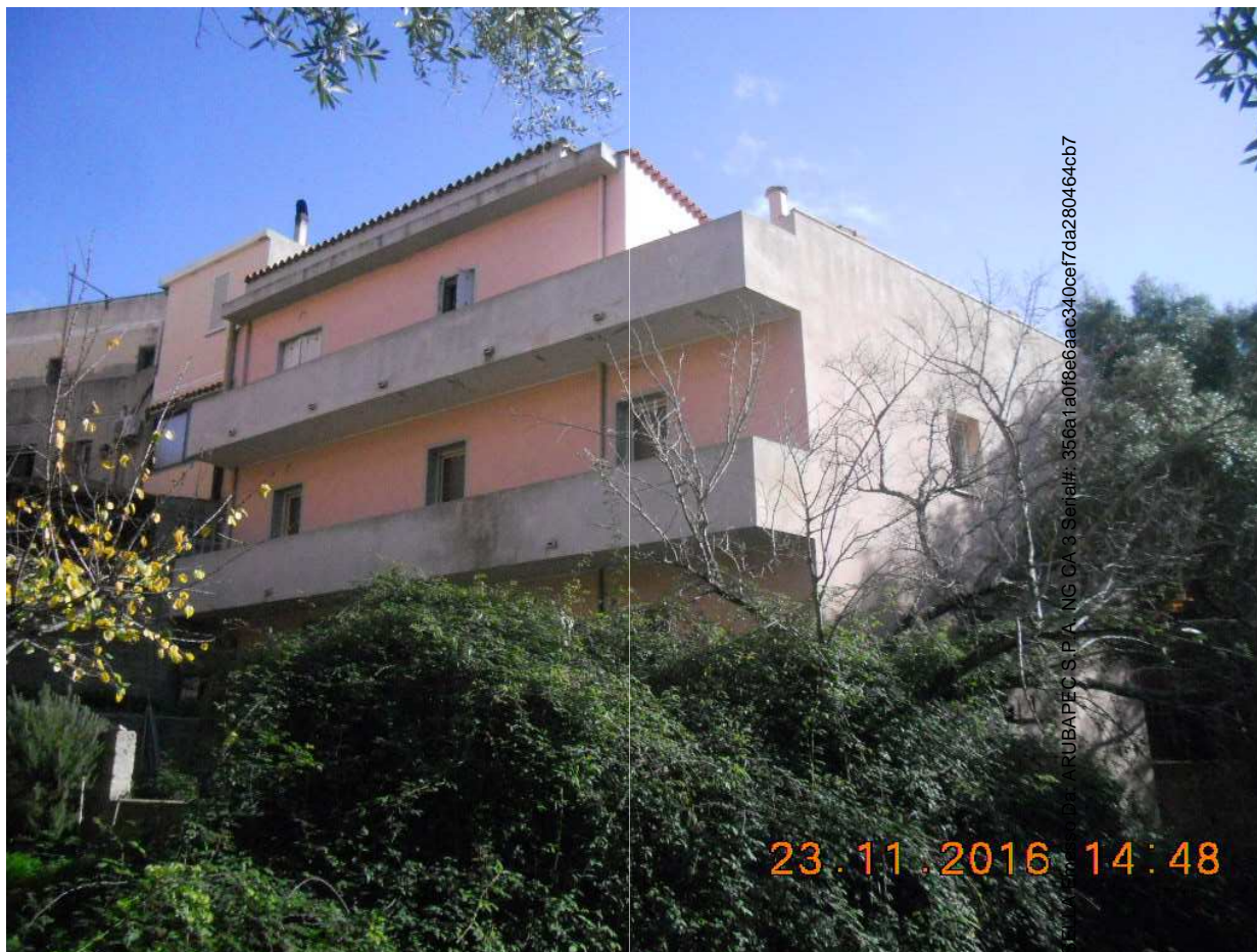
Foto 9. Prospetto sul retro a nord-ovest
