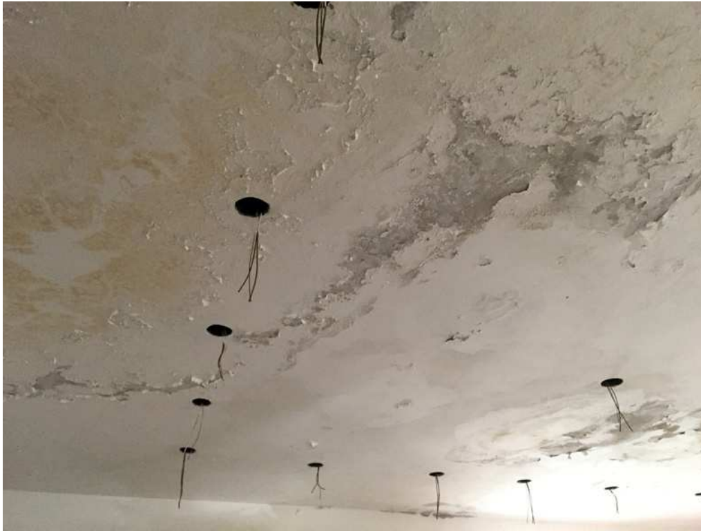
Foto 34. (Sub 2). Intradosso del solaio del soggiorno, corrispondente alla veranda
