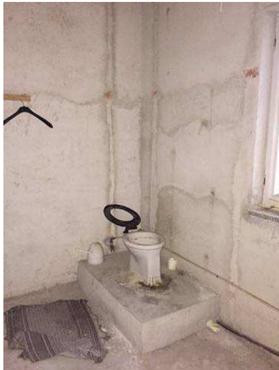
Foto 28-29 (Sub 2) Bagno, opere provvisorie
