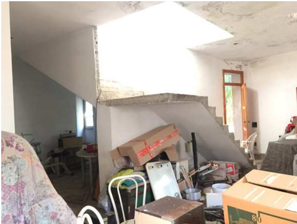
Foto 16. ( Sub 2) Vista sulle due rampe di scale per il collegamento al piano superiore
