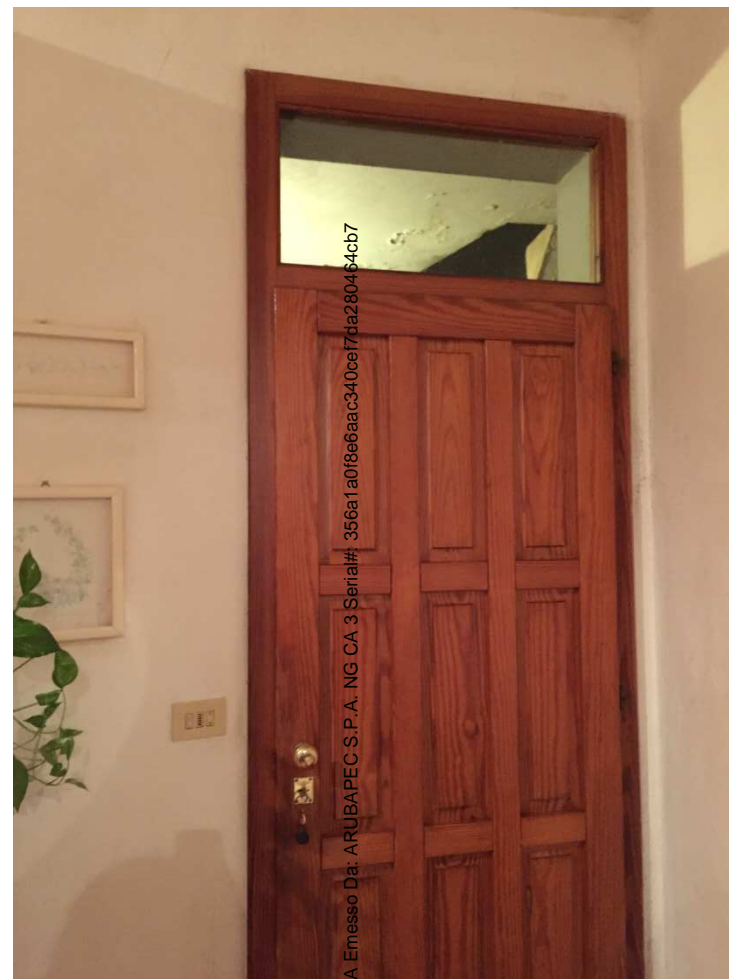
Foto 38. (Sub 4). Portone d'ingresso in legno
