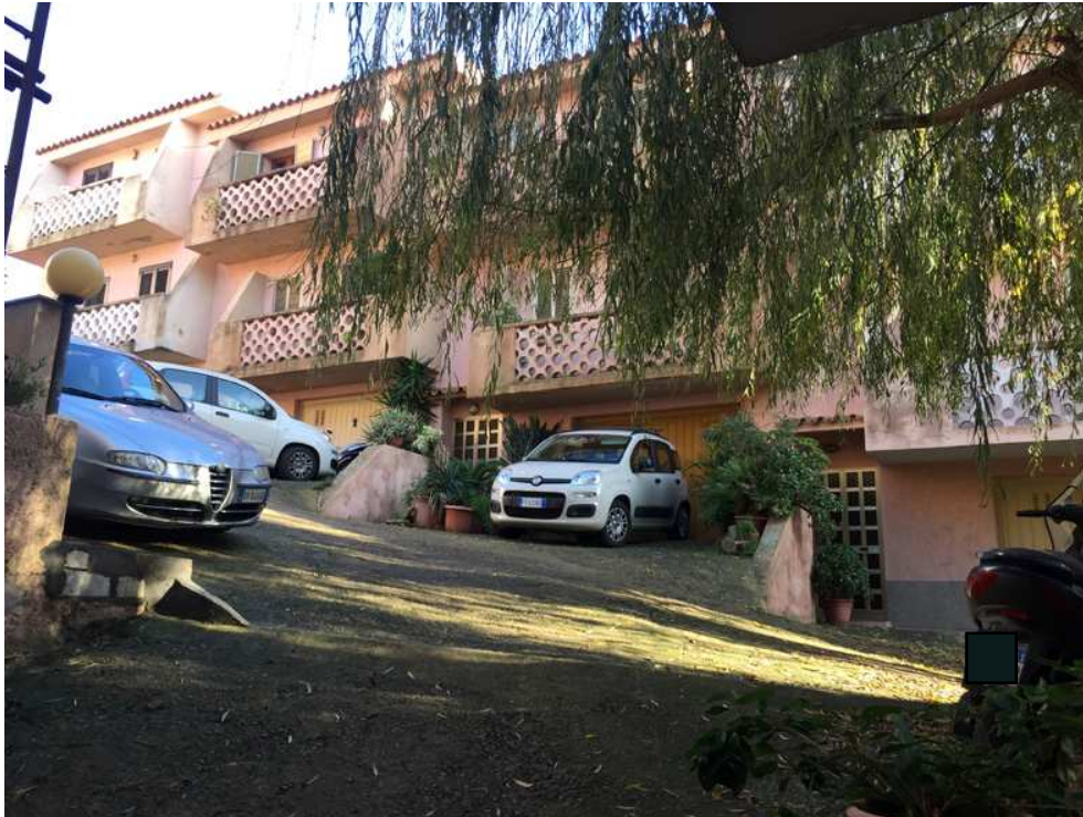
Foto 3. Edificio residenziale a schiera sul fronte del fabbricato
