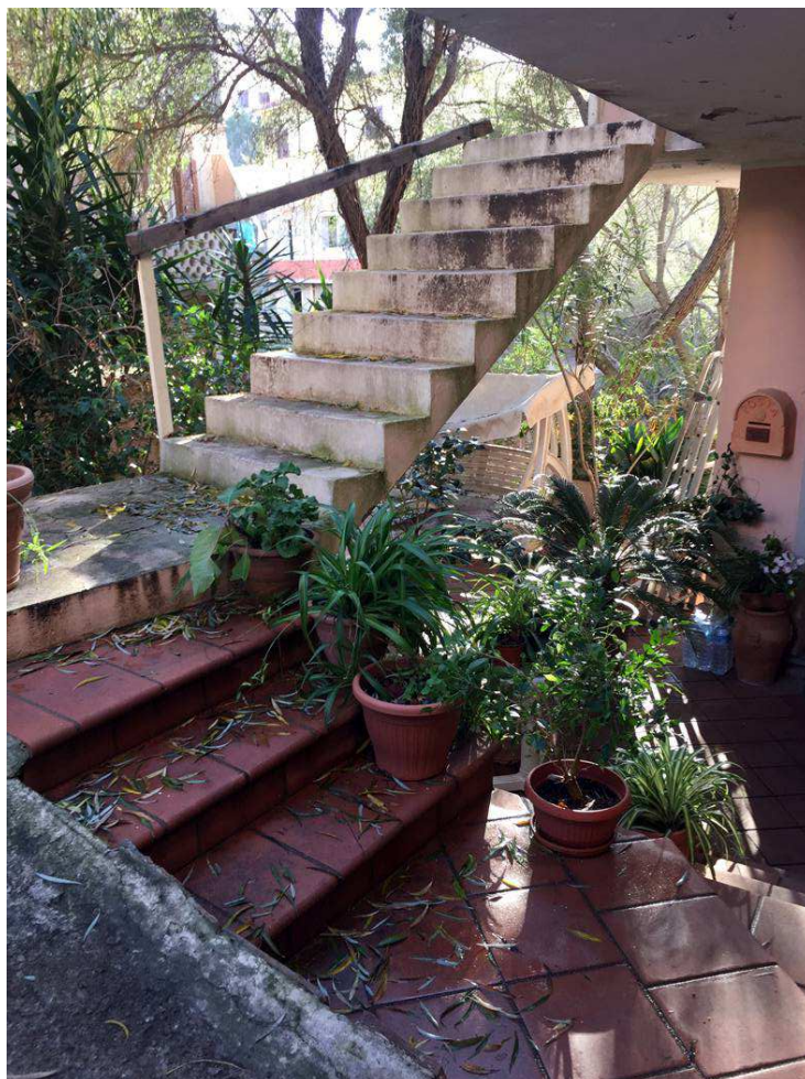
Foto 37b. ( Sub 4 ) Particolare scale ingresso.
