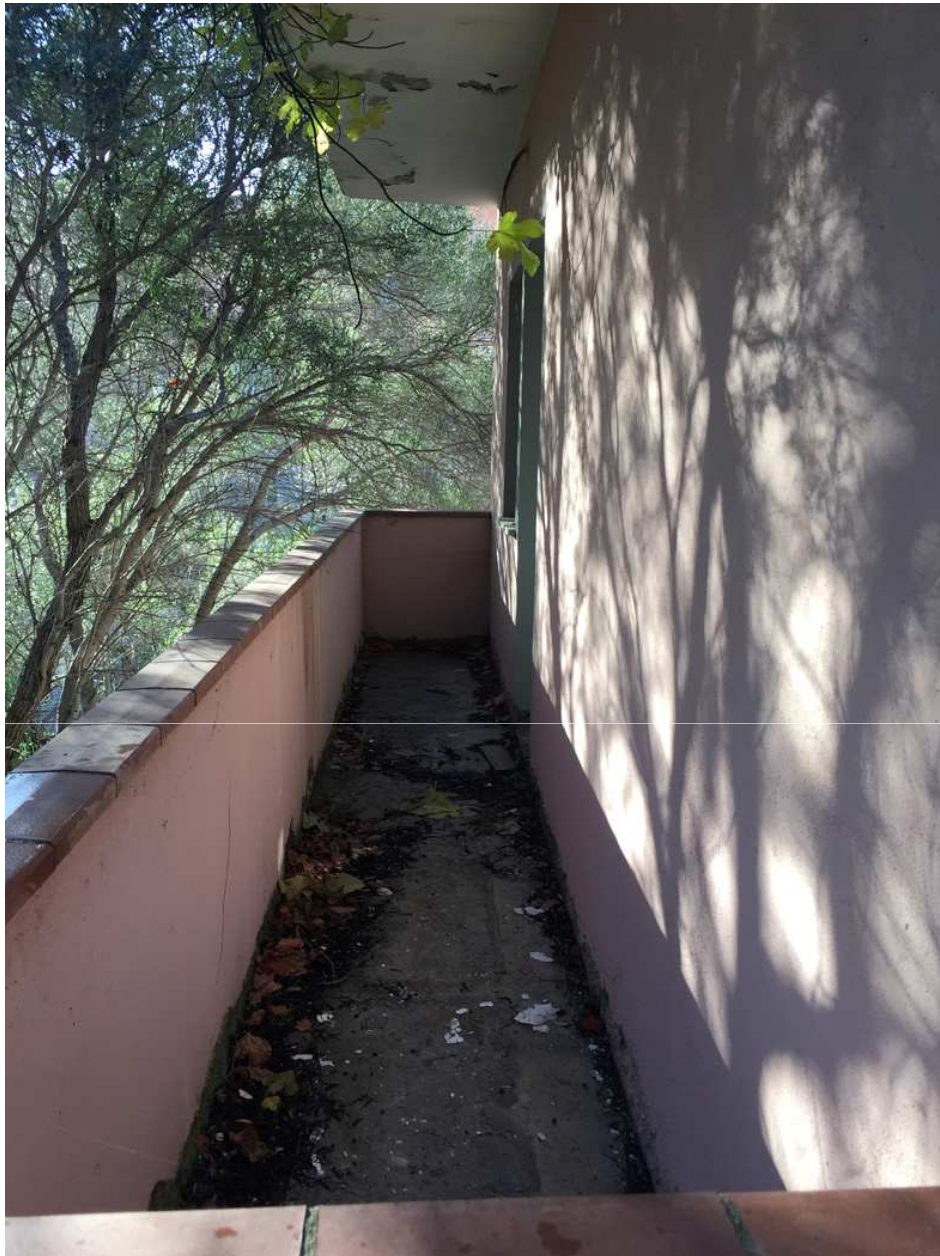
Foto 17b. (Sub.2). Balcone a sbalzo sul fronte, con accesso dal soggiorno
