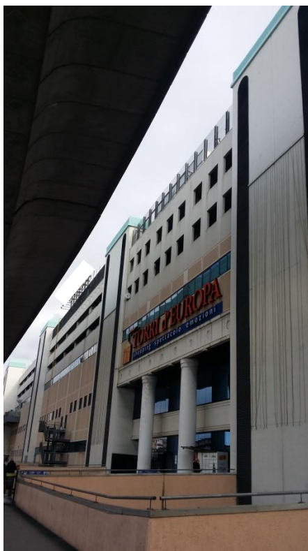
Foto n.3– Vista edificio (lato via Svevo)
