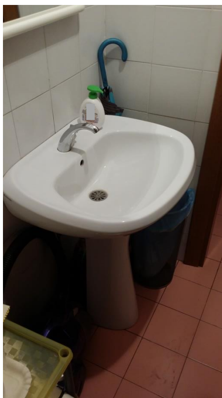
Foto n.32 – Locale anti-wc -vista n.1
