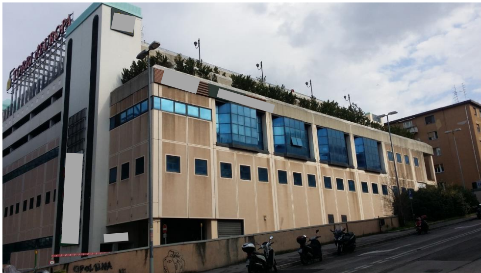
Foto n.6 – Vista edificio (lato via Doda)
