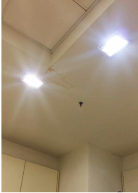
Foto n.25 – Vano principale – vista n.6
