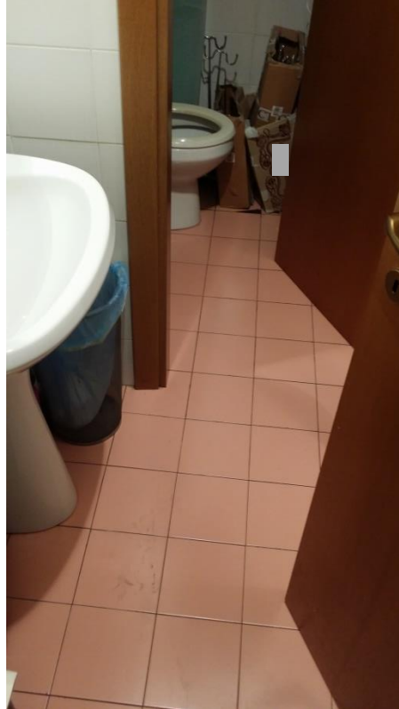
Foto n.29 – Locali wc e anti -wc
