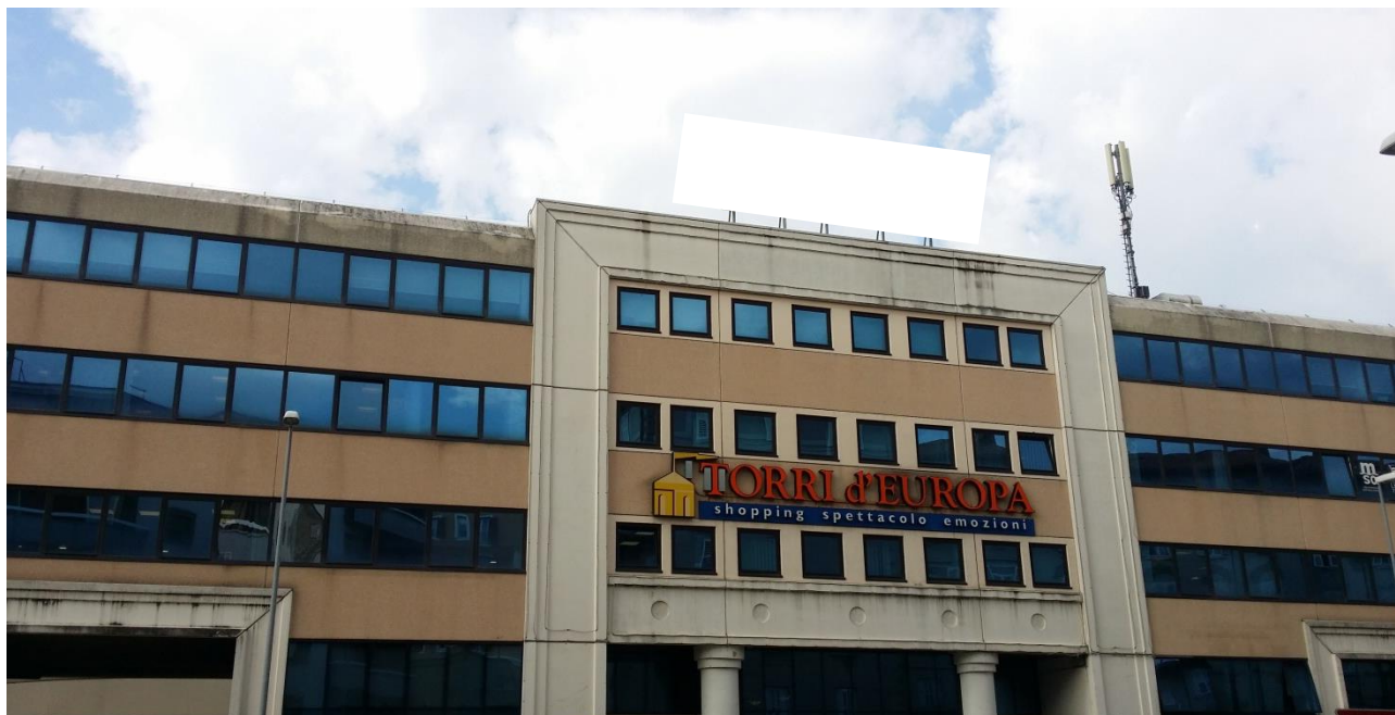
Foto n.1 – Vista edificio (lato via D'Alviano)
