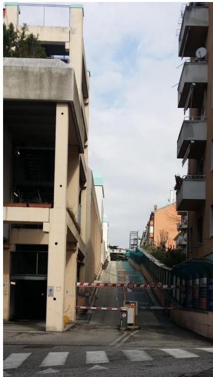
Foto n.8 – Ingresso piani autorimesse (livelli superiori- lato via Doda)
