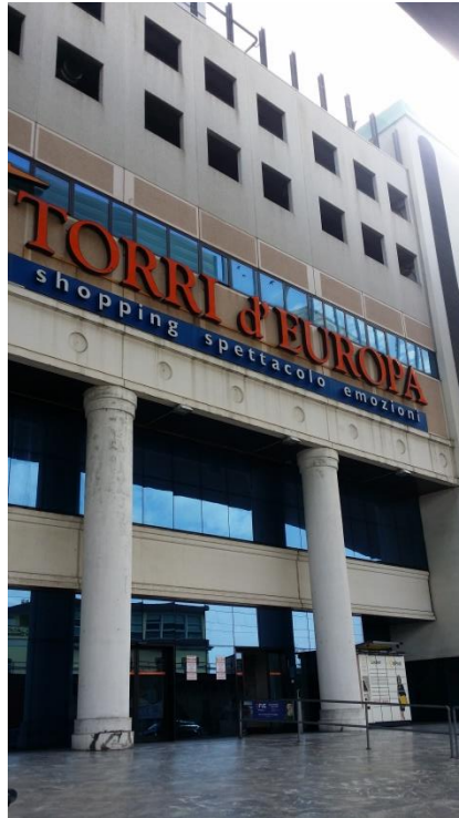
Foto n.5 – Vista ingresso edificio (lato via Svevo)
