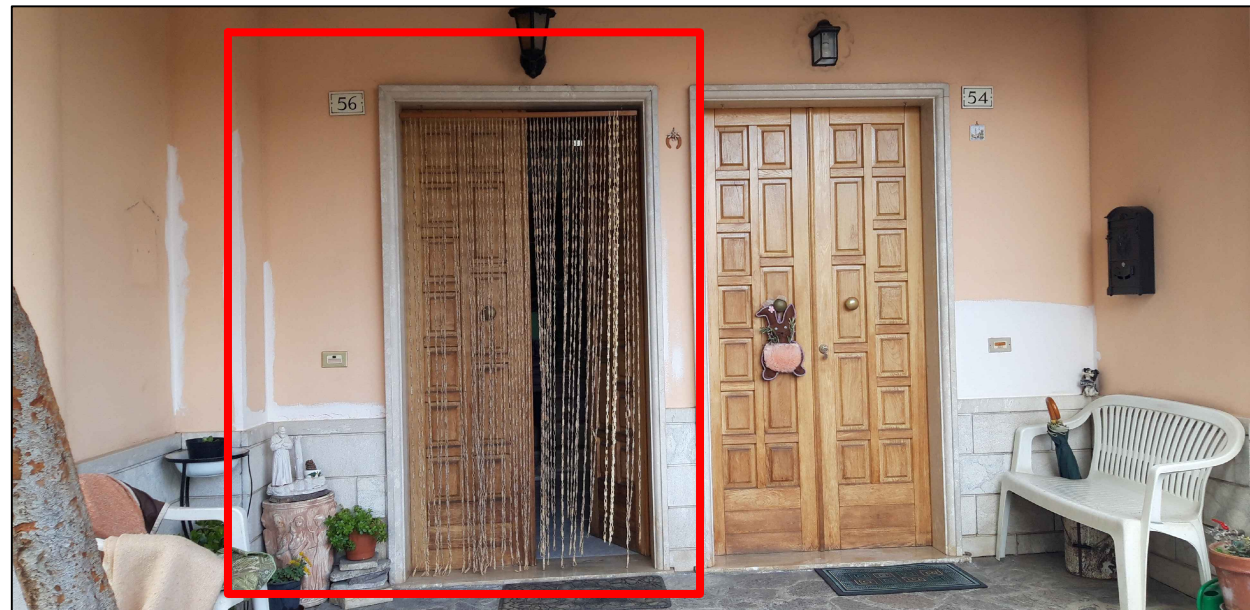
CIVICO 56 INGRESSO ALL'APPARTAMENTO SUB 3
