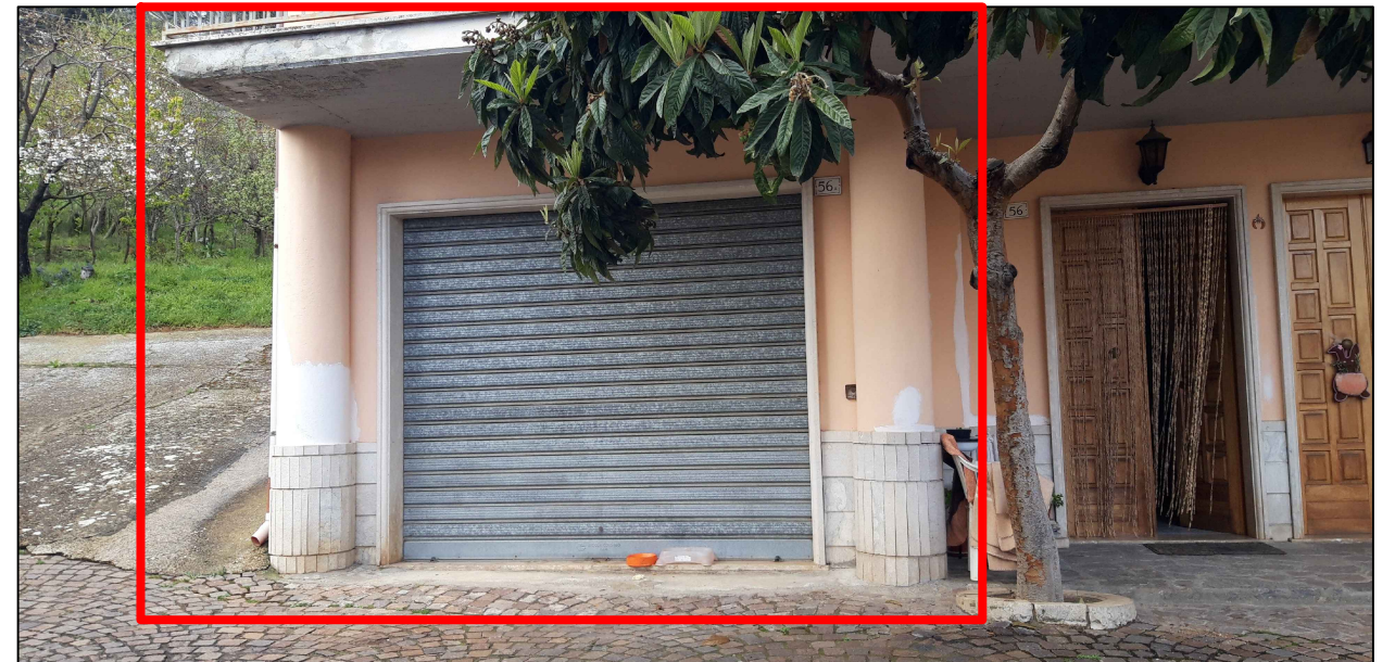
CIVICO 56/A INGRESSO AUTORIMESSA SUB 2
