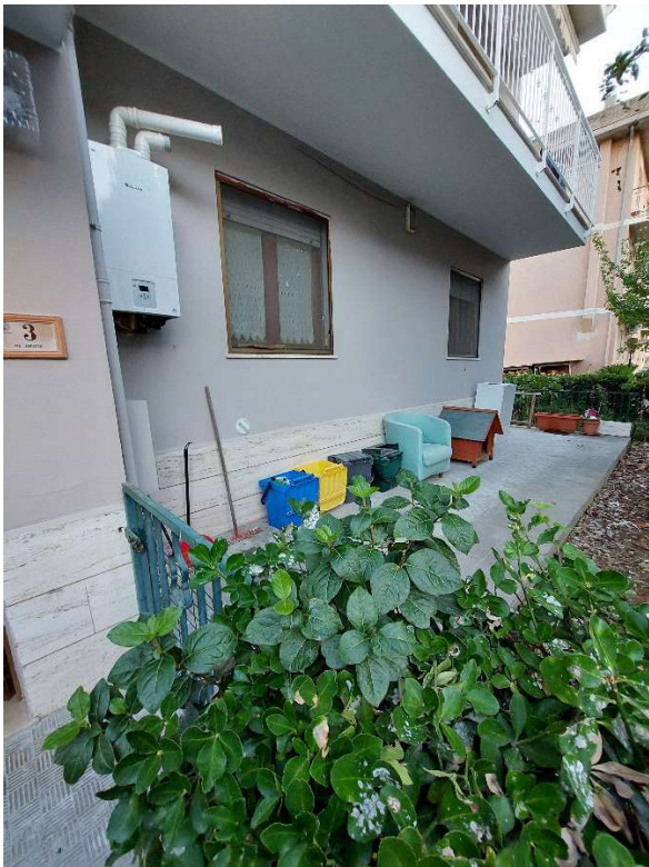
Vista sud-appartamento Ingresso scala condominiale
