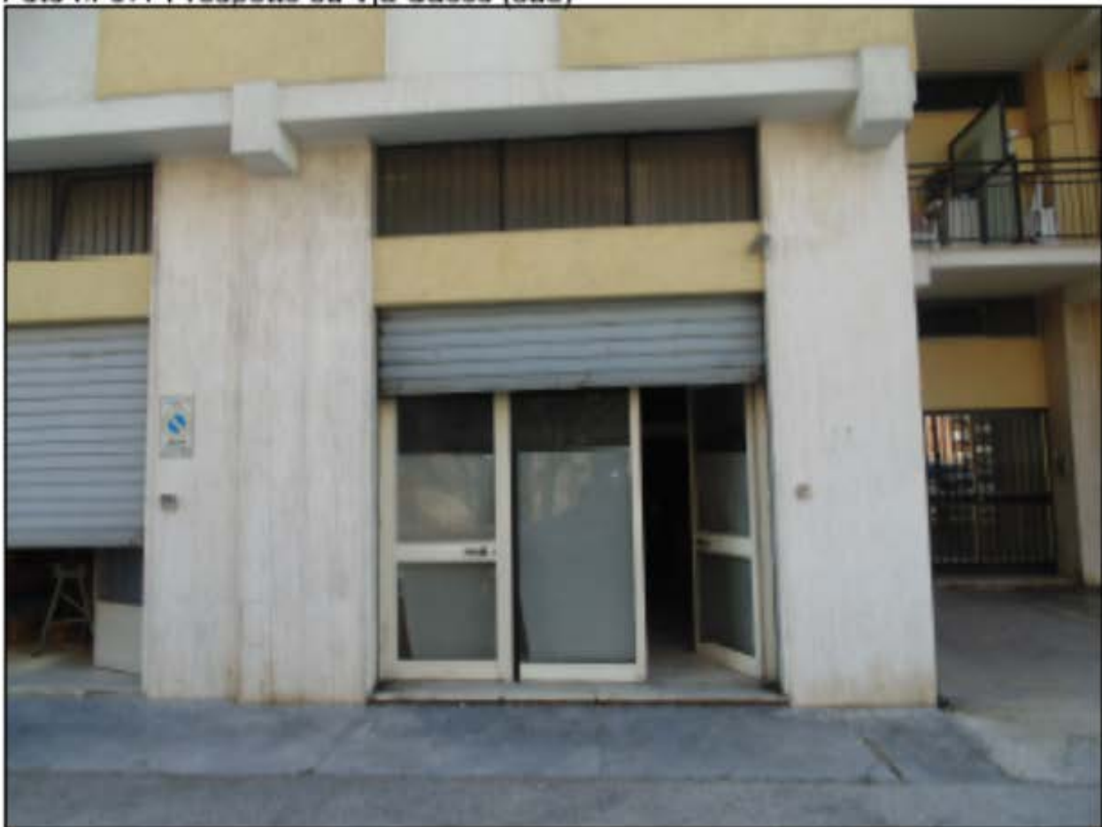
Foto n. 07: Prospetto su Via Sacco (sud)
