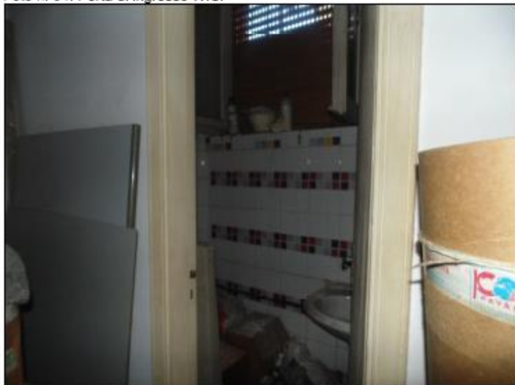
Foto n. 04: Porta di Ingresso W.C.
