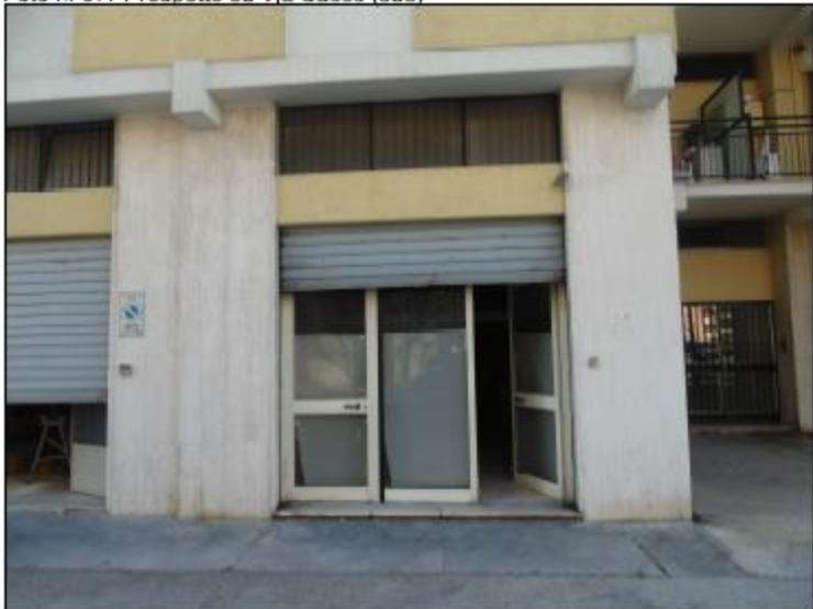
Foto n. 07: Prospetto su Via Sacco (sud)
