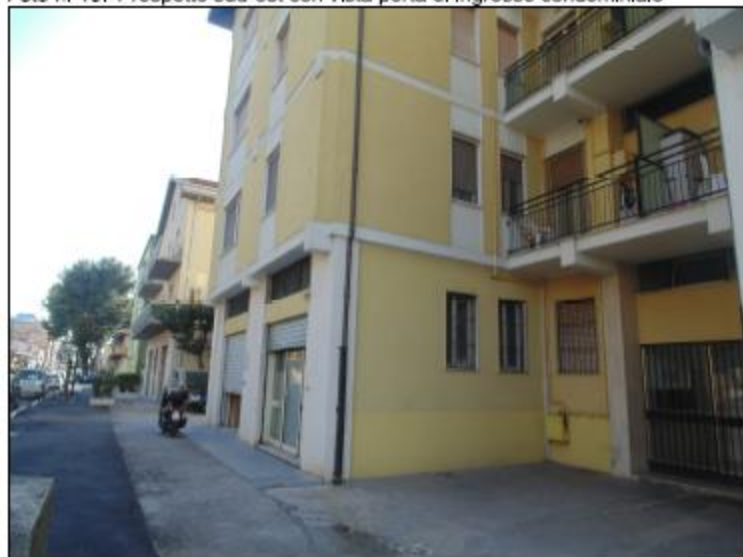
Foto n. 10: Prospetto sud-est con vista porta di Ingresso condominiale
