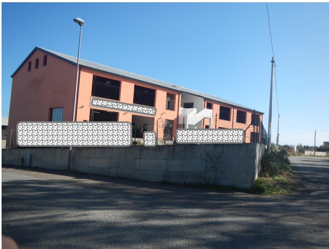
Foto 4: Prospetto Sud del fabbricato
