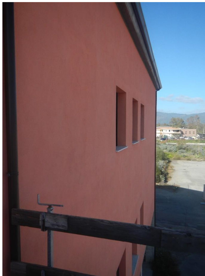
Foto 11: Dettaglio finestre Prospetto Nord
