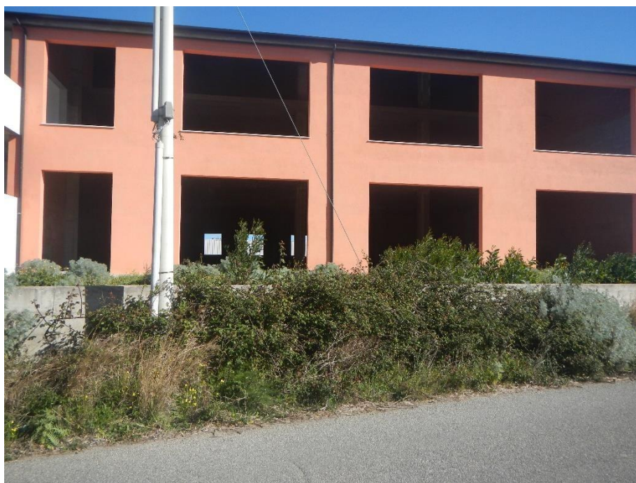
Foto 5: Dettaglio prospetto sud
