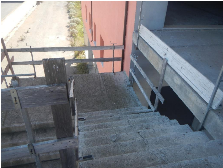
Foto 8: Scala esterna non ultimata
