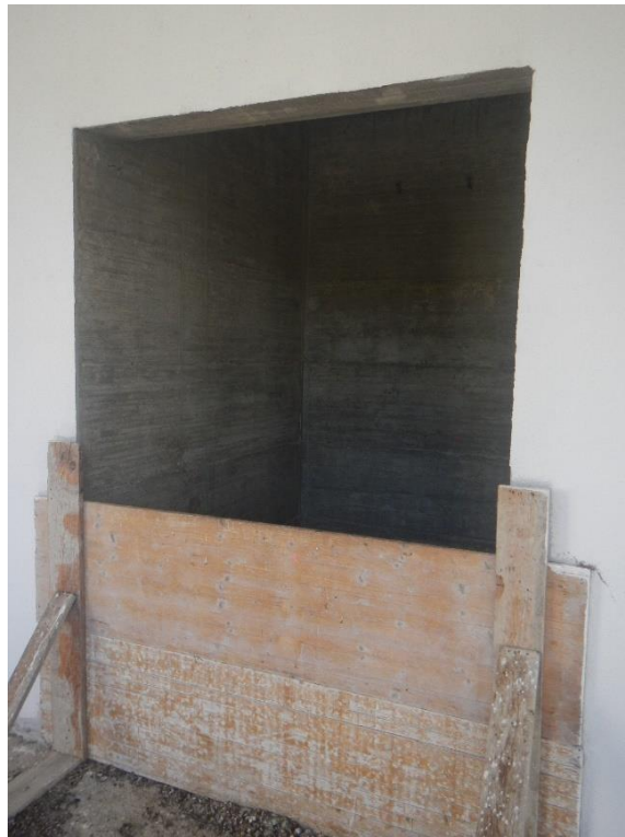
Foto 12: Vano montacarichi Lato Sud
