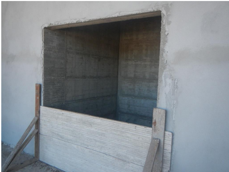
Foto 10: vano montacarichi Lato Nord
