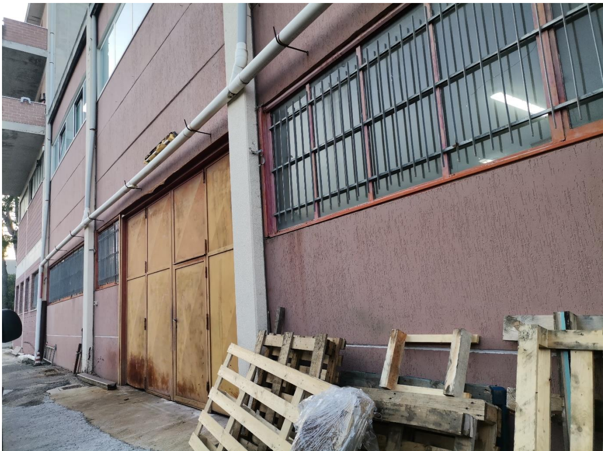
Foto n. 16: Prospetto est ed ingresso carrabile al laboratorio
