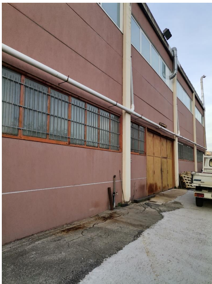
Foto n. 13: Prospetto est laboratorio con ingresso carrabile
