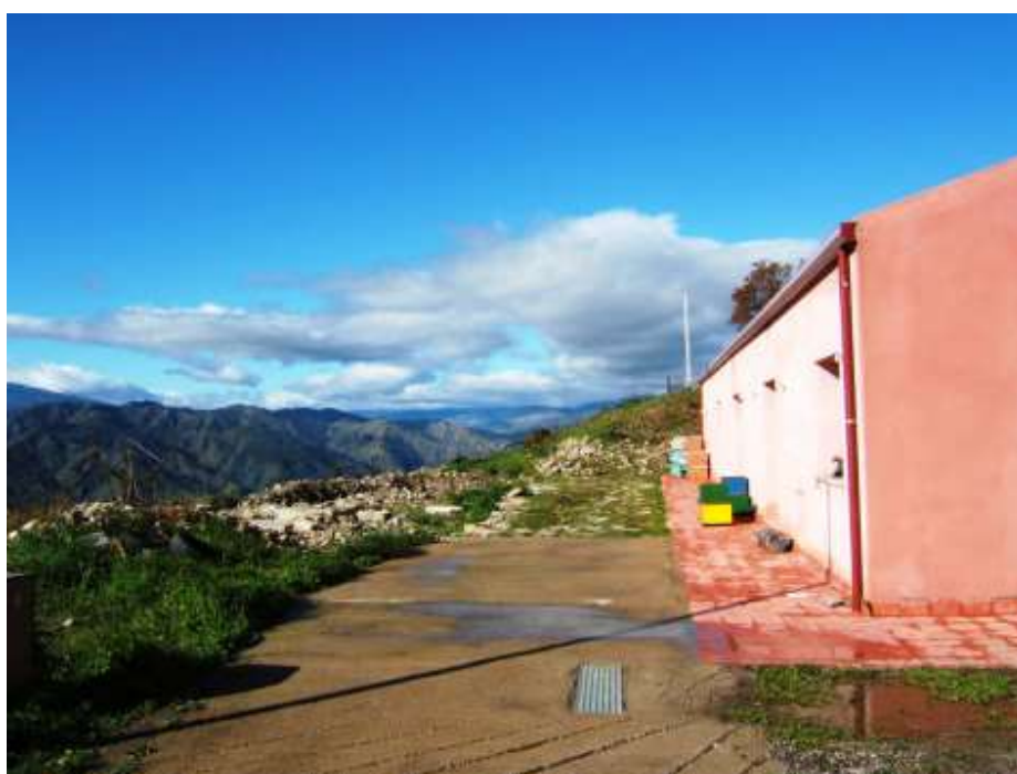
Foto n. 16: Lotto 2 – Spazi esterni circostanti il fabbricato
