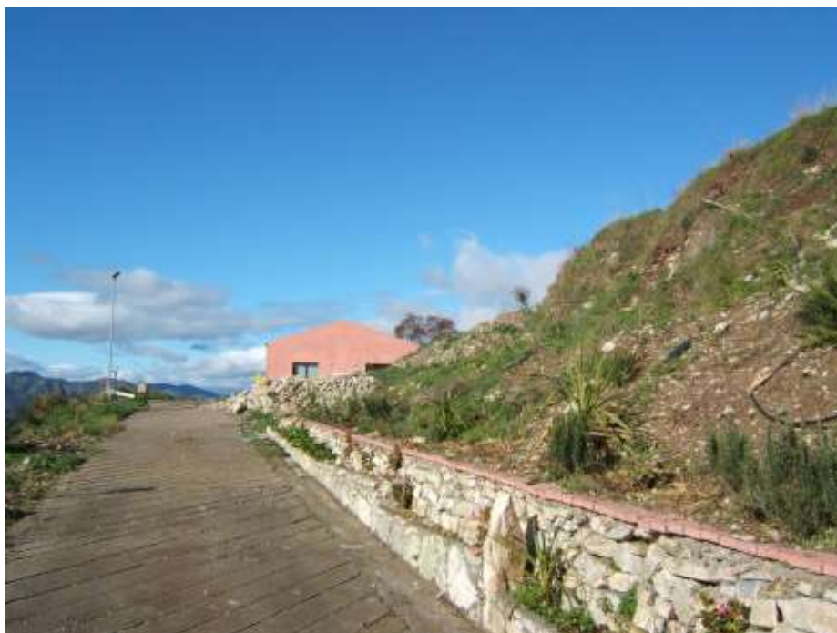
Foto n. 11: Lotto 2 – Percorso carrabile interno
