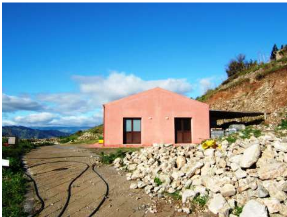
Foto n. 13: Lotto 2– Spazi esterni circostanti il fabbricato
