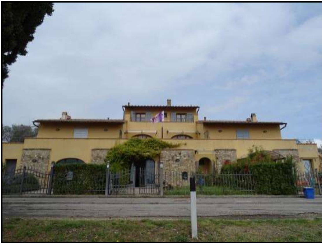
FOTO 1 PROSPETTO EDIFICIO SU VIA CELLOLE
