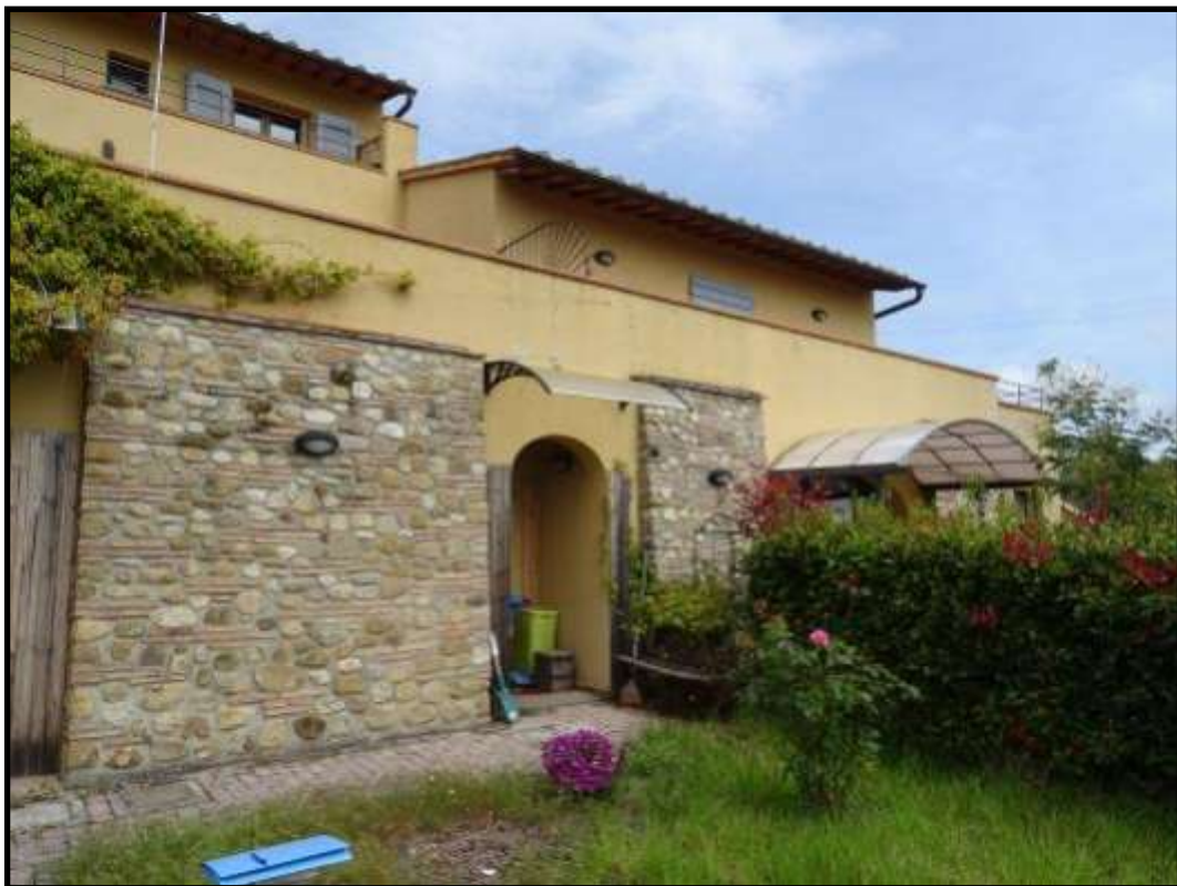
FOTO 6 ACCESSO AL VANO SCALA DAL RESEDE ESCLUSIVO
