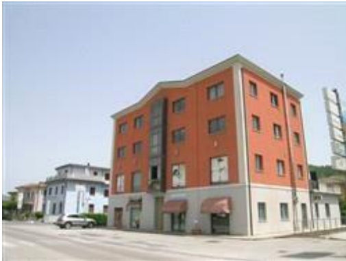
Vista da Lato Cagli
