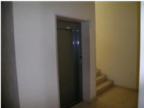
Vano ascensore comune
