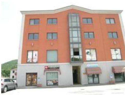
Fronte principale e ingresso condominiale
