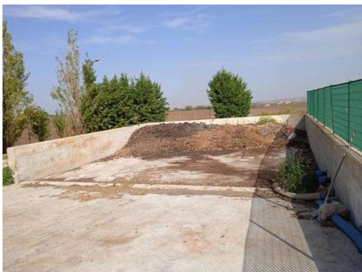
Foto n. 51 – Locale E - Concimaia - Part. 378 sub 5 - Vista esterna
