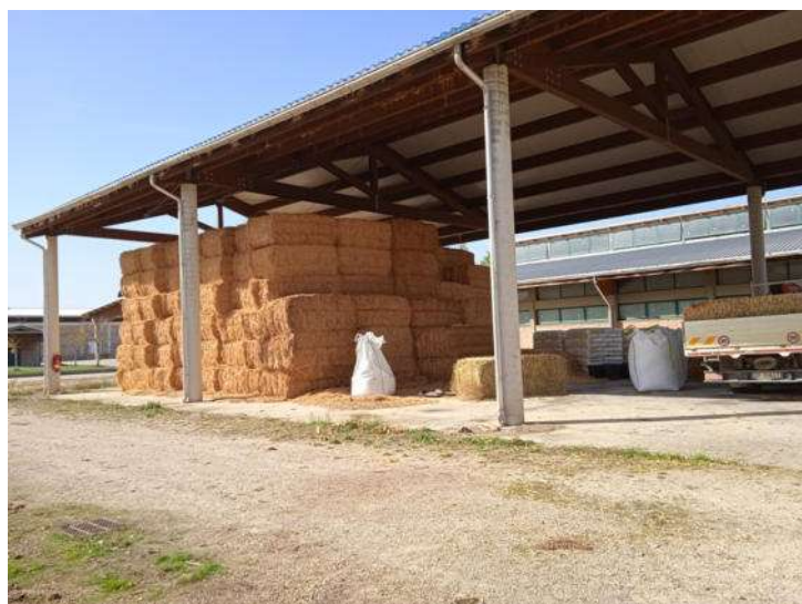
Foto n. 34 – Fabbricato C - Tettoia fienile - Part. 378 sub 5
