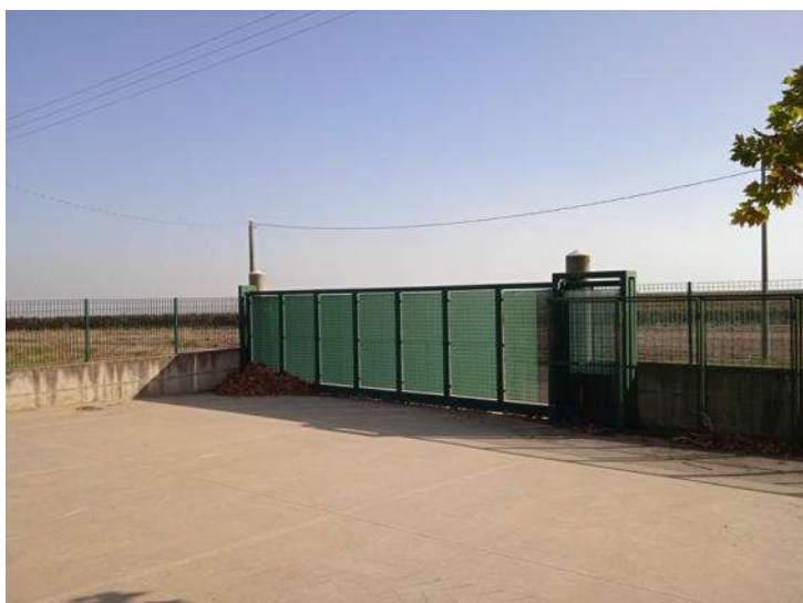
Foto n. 7 – Vista area esterna - accesso laterale destro
