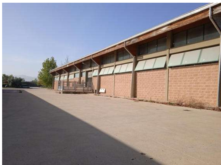
Foto n. 20 – Fabbricato B - Stalla - Part. 378 sub 5 - Vista esterna
