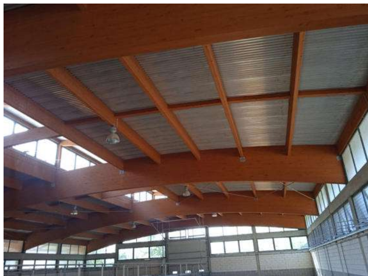
Foto n. 18 – Fabbricato A - Stalla - Part. 378 sub 5 - Vista interna
