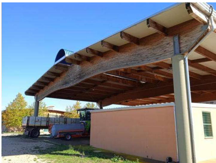
Foto n. 56 – Fabbricato F - Tettoia autoparco e deposito - Part. 378 sub 5
