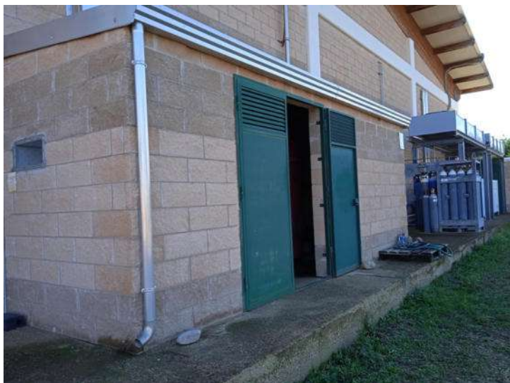
Foto n. 142 – Locali P-O - Vista esterna - Part. 378 sub 5
