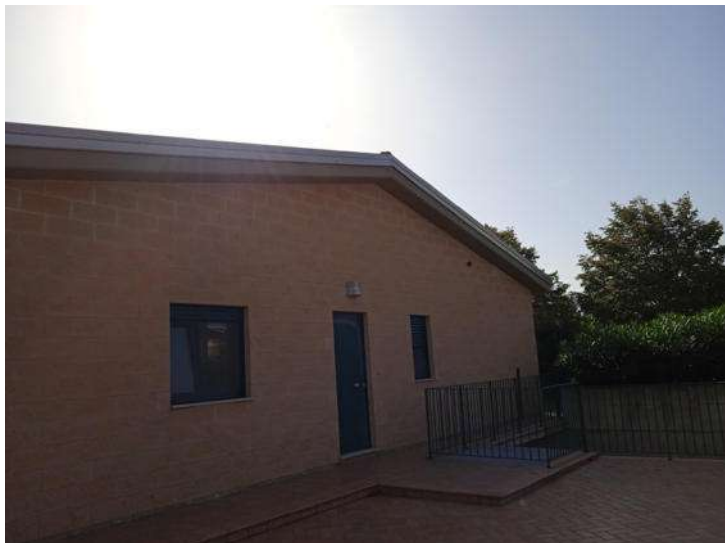
Foto n. 95 – Fabbricato L - Vista esterna - Part. 378 sub 3, 4, 5
