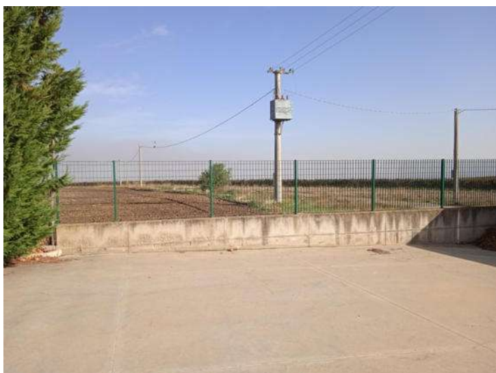
Foto n. 9 – Vista area esterna - recinzione
