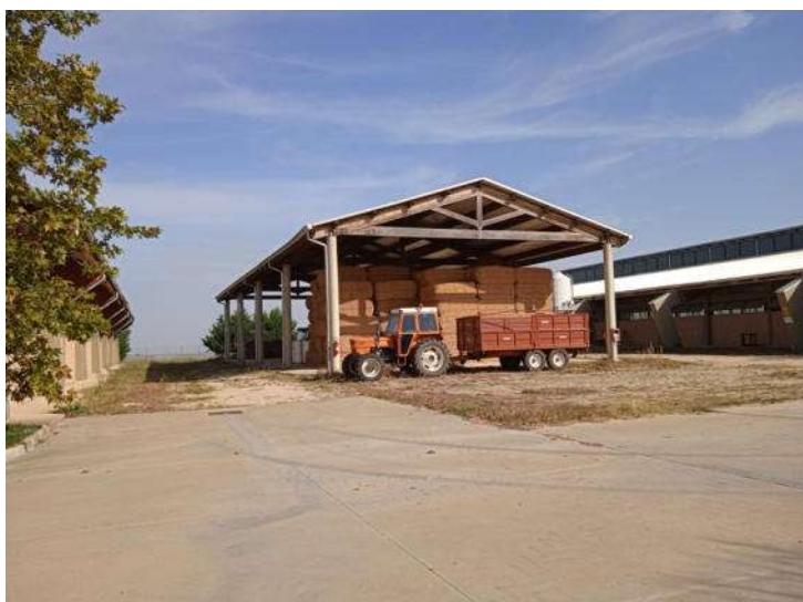
Foto n. 31 – Fabbricato C - Tettoia fienile - Part. 378 sub 5
