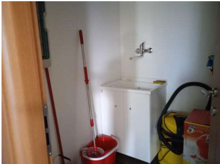
Foto n. 79 – Fabbricato H - Uffici piano terra - Part. 378 sub 5
