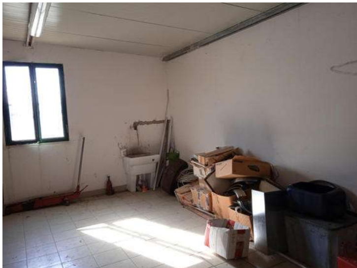
Foto n. 59 – Fabbricato F - Deposito - Part. 378 sub 5
