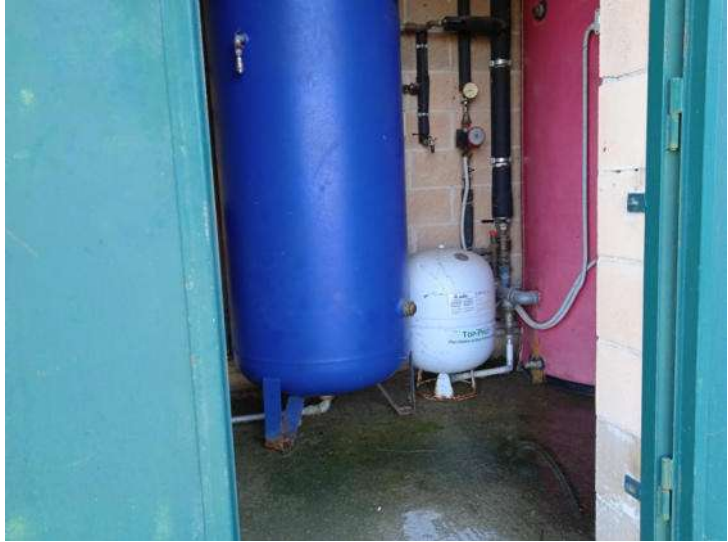
Foto n. 143 – Locale P - Vista interna - Part. 378 sub 5
