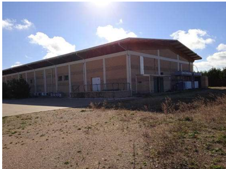
Foto n. 128 – Fabbricato N - Vista esterna - Part. 378 sub 5
