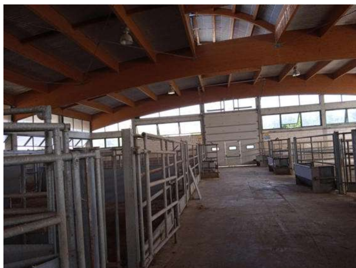
Foto n. 28 – Fabbricato B - Stalla - Part. 378 sub 5 - Vista interna
