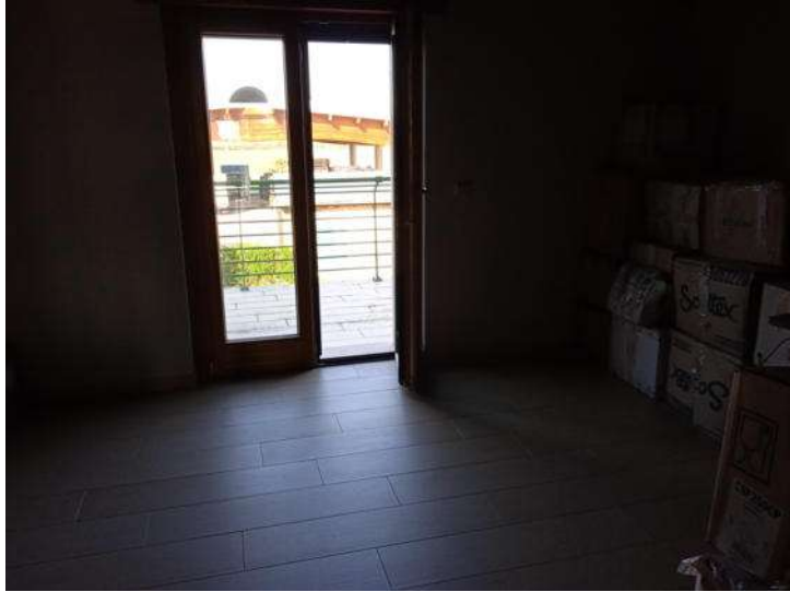
Foto n. 83 – Fabbricato H - Uffici piano primo - Part. 378 sub 5
