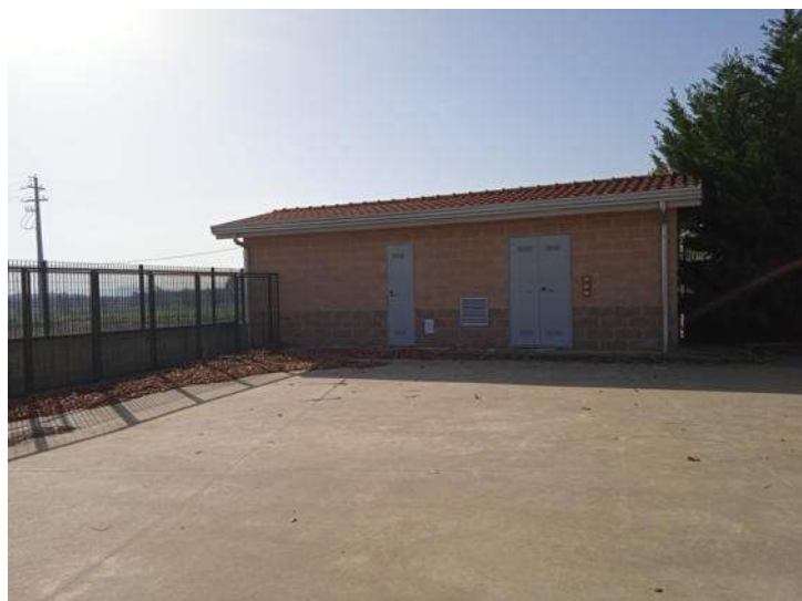
Foto n. 124 – Fabbricato M - Cabina elettrica - Part. 378 sub 2
