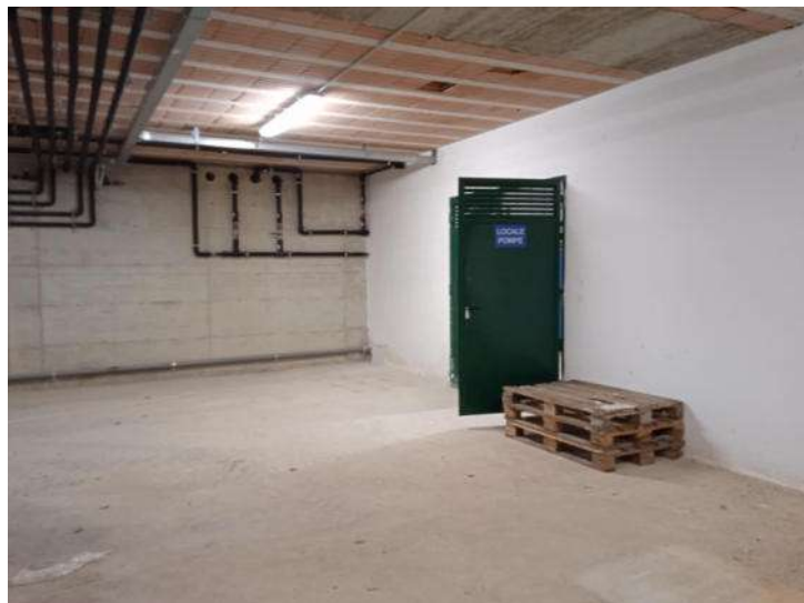
Foto n. 100 – Fabbricato L - Piano interrato - Part. 378 sub 5
