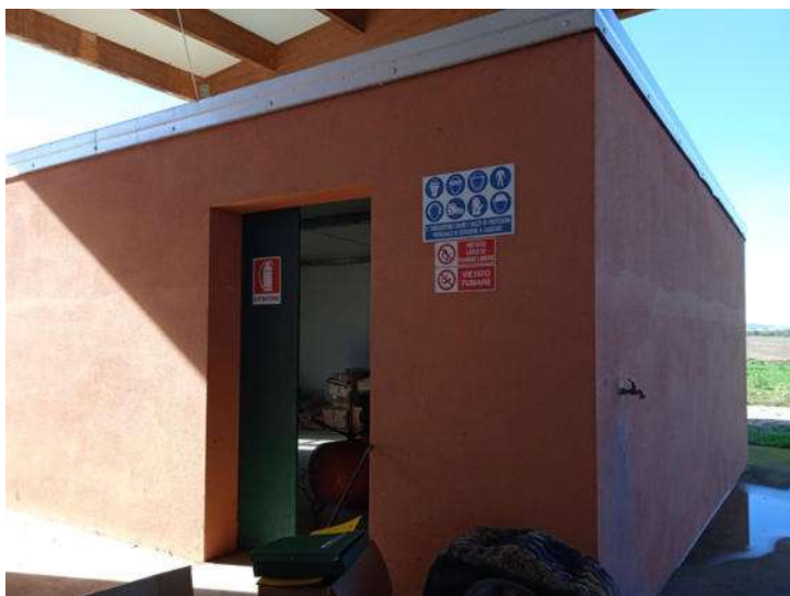
Foto n. 58 – Fabbricato F - Tettoia autoparco e deposito - Part. 378 sub 5
