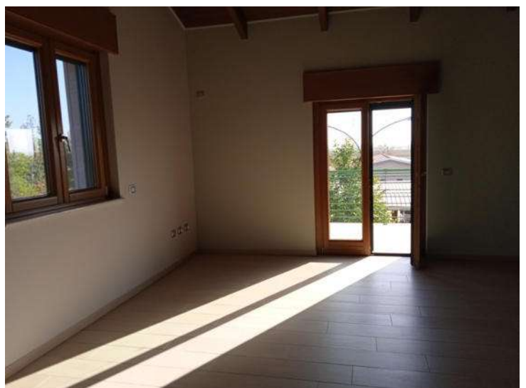
Foto n. 82 – Fabbricato H - Uffici piano primo - Part. 378 sub 5
