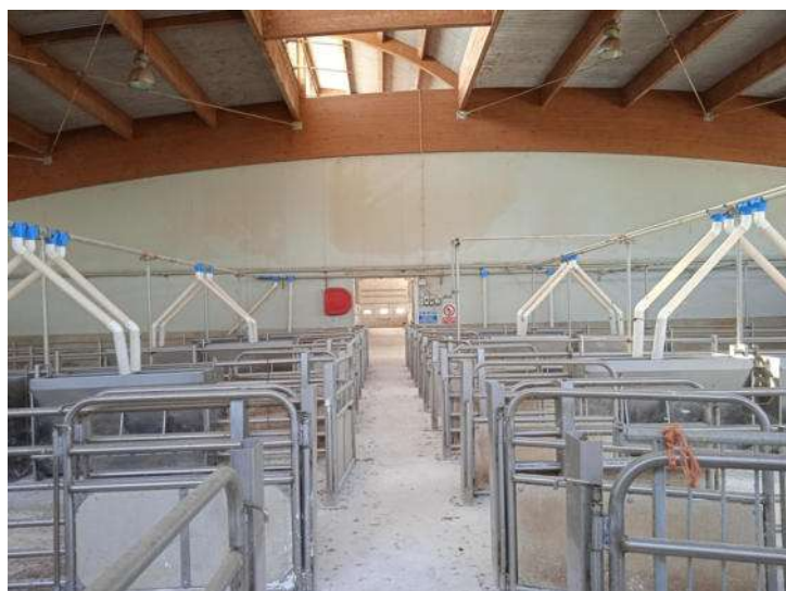
Foto n. 44 – Fabbricato D - Stalla - Part. 378 sub 5 - Vista interna
