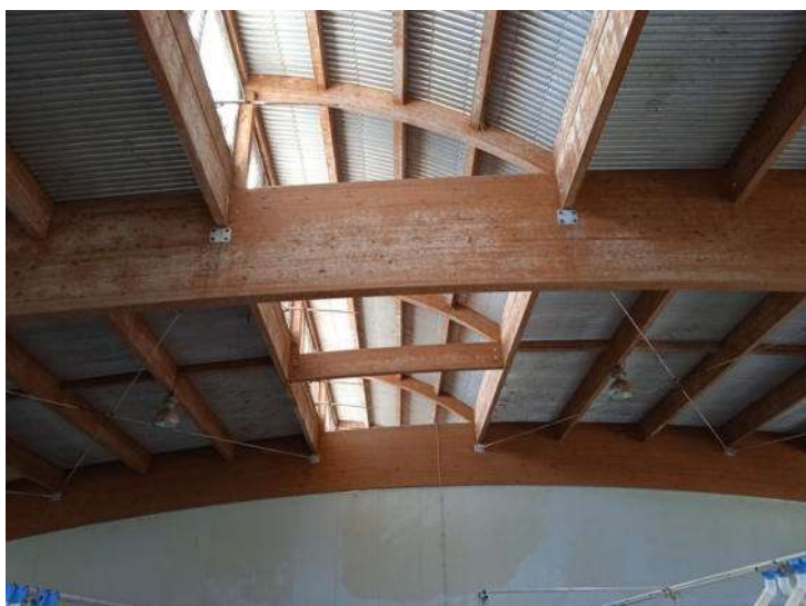
Foto n. 45 – Fabbricato D - Stalla - Part. 378 sub 5 - Vista interna
