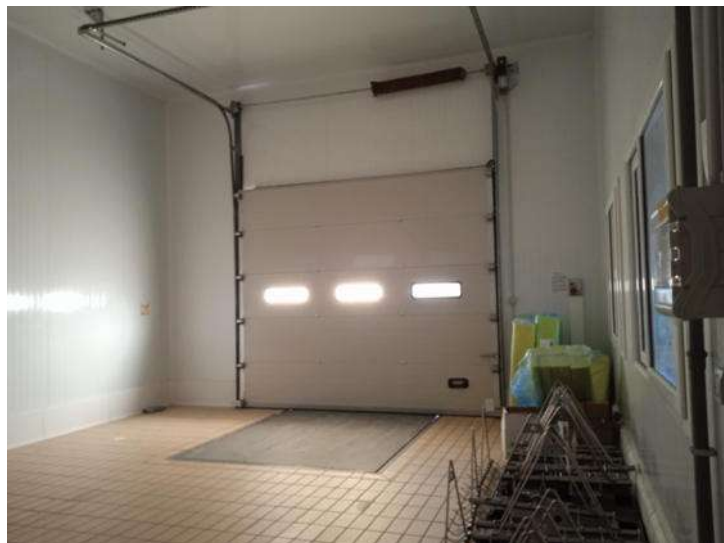
Foto n. 130 – Fabbricato N - Vista interna - Part. 378 sub 5
