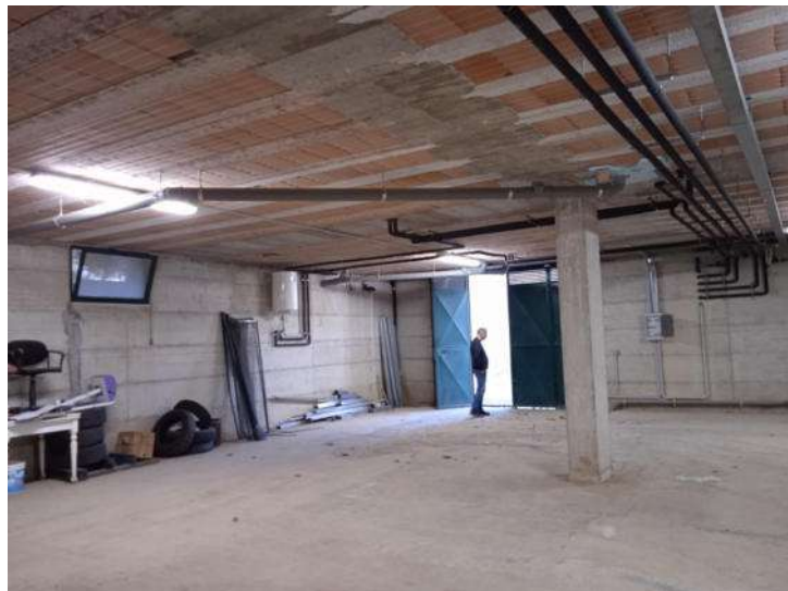
Foto n. 102 – Fabbricato L - Piano interrato - Part. 378 sub 5
