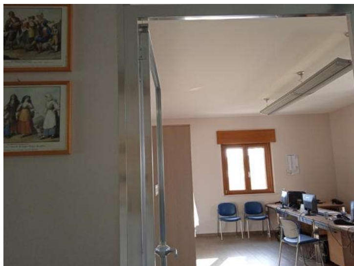
Foto n. 76 – Fabbricato H - Uffici piano terra - Part. 378 sub 5
