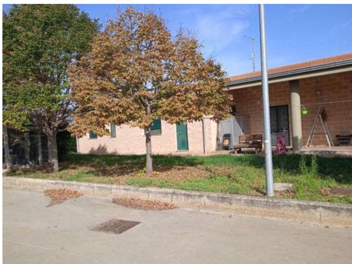
Foto n. 97 – Fabbricato L - Vista esterna - Part. 378 sub 3, 4, 5
