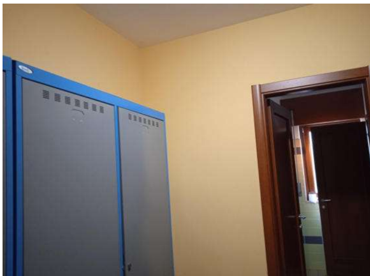
Foto n. 109 – Fabbricato L - Piano terra - Part. 378 sub 5
