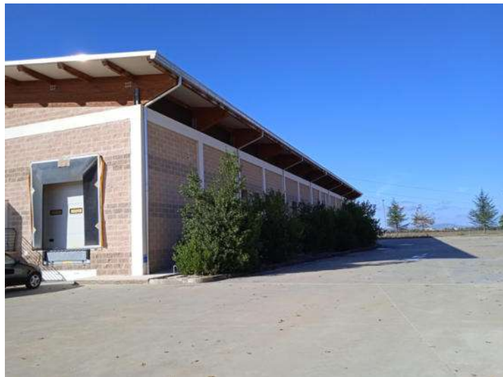
Foto n. 126 – Fabbricato N - Vista esterna - Part. 378 sub 5
