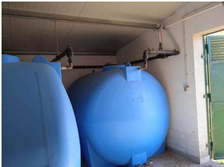
Foto n. 53 – Locale E - Riserva idrica - Part. 378 sub 5 - Vista interna
