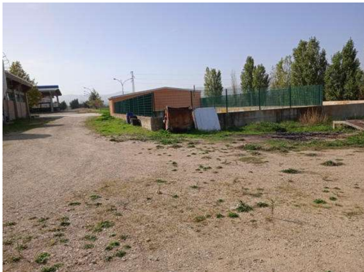
Foto n. 47 – Locale E - Riserva idrica e vasche - Part. 378 sub 5 - Vista esterna
