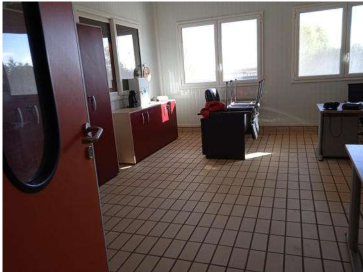
Foto n. 131 – Fabbricato N - Vista interna - Part. 378 sub 5
