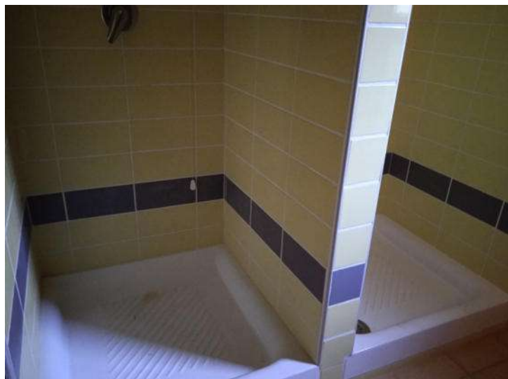
Foto n. 110 – Fabbricato L - Piano terra - Part. 378 sub 5
