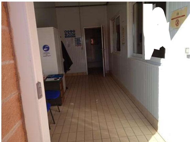
Foto n. 129 – Fabbricato N - Vista interna - Part. 378 sub 5
