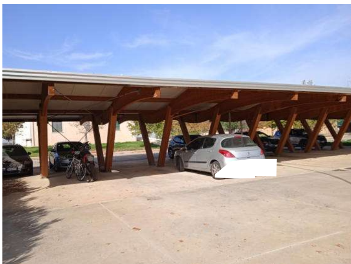
Foto n. 91 – Fabbricato I - Tettoia parcheggio - Part. 378 sub 5
