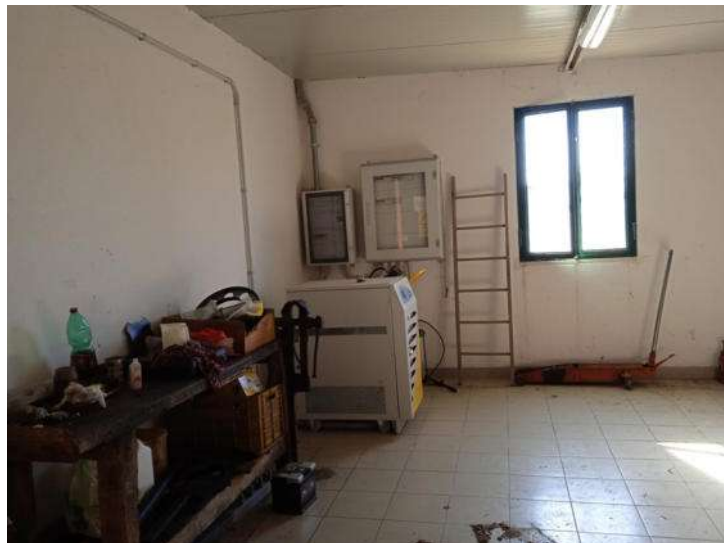
Foto n. 60 – Fabbricato F - Deposito - Part. 378 sub 5
