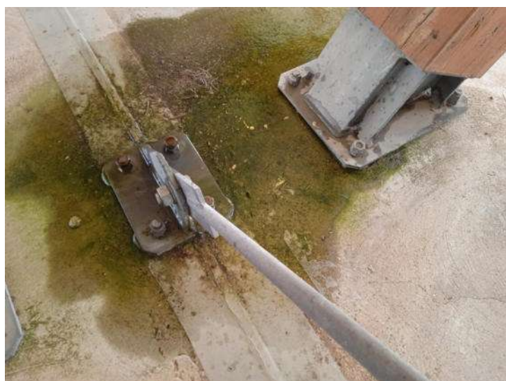
Foto n. 94 – Fabbricato I - Tettoia parcheggio - Part. 378 sub 5
