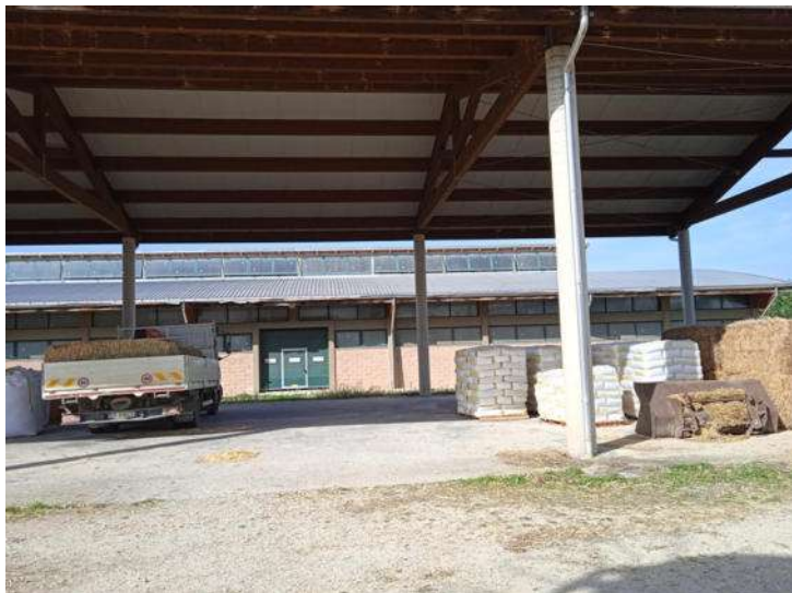
Foto n. 35 – Fabbricato C - Tettoia fienile - Part. 378 sub 5
