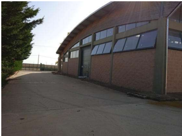
Foto n. 11 – Fabbricato A - Stalla - Part. 378 sub 5 - Vista esterna
