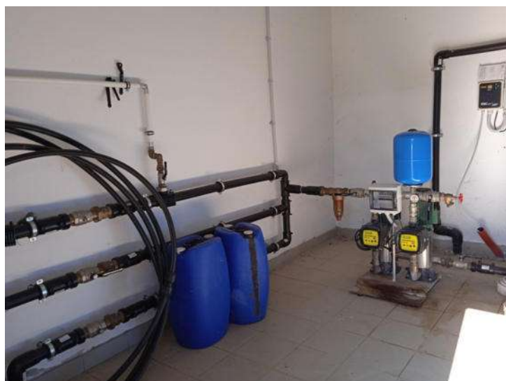
Foto n. 52 – Locale E - Riserva idrica - Part. 378 sub 5 - Vista interna
