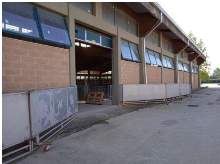
Foto n. 14 – Fabbricato A - Stalla - Part. 378 sub 5 - Vista esterna
