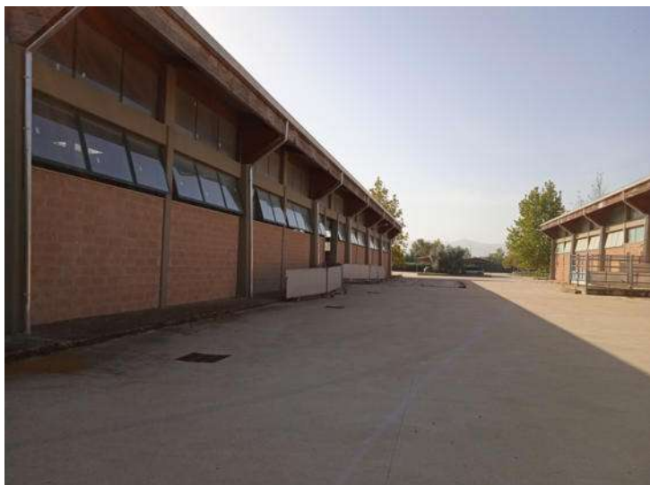
Foto n. 13 – Fabbricato A - Stalla - Part. 378 sub 5 - Vista esterna
