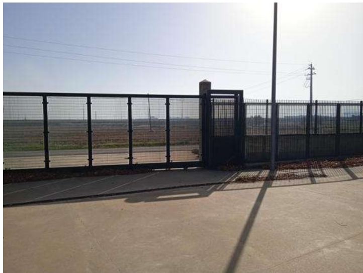
Foto n. 6 – Vista area esterna - accesso principale
