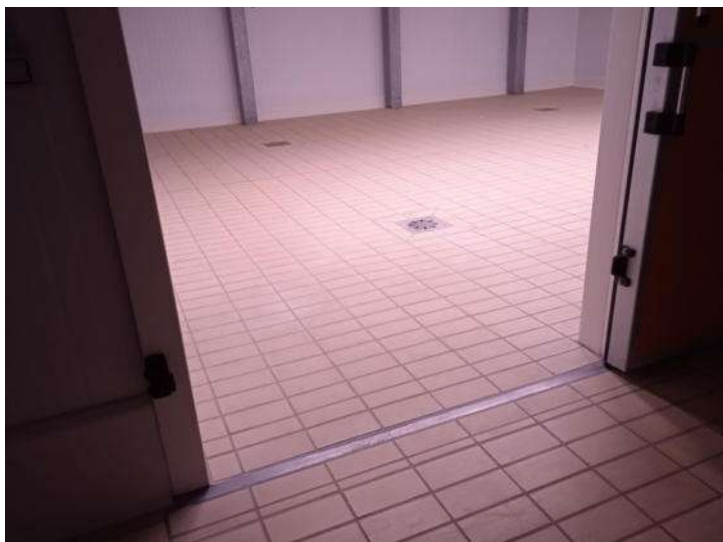
Foto n. 139 – Fabbricato N - Vista interna - Part. 378 sub 5
