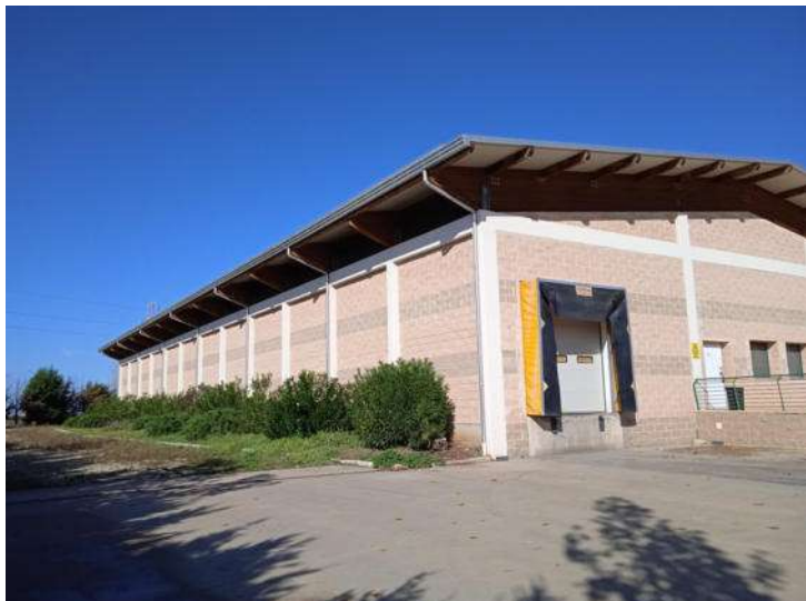
Foto n. 127 – Fabbricato N - Vista esterna - Part. 378 sub 5
