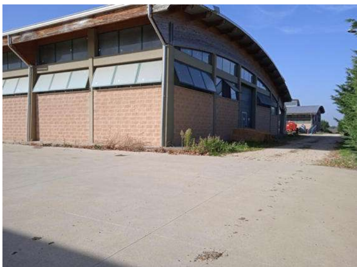
Foto n. 19 – Fabbricato B - Stalla - Part. 378 sub 5 - Vista esterna
