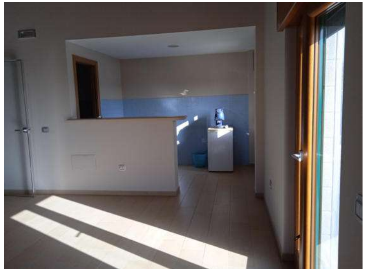
Foto n. 86 – Fabbricato H - Uffici piano primo - Part. 378 sub 5
