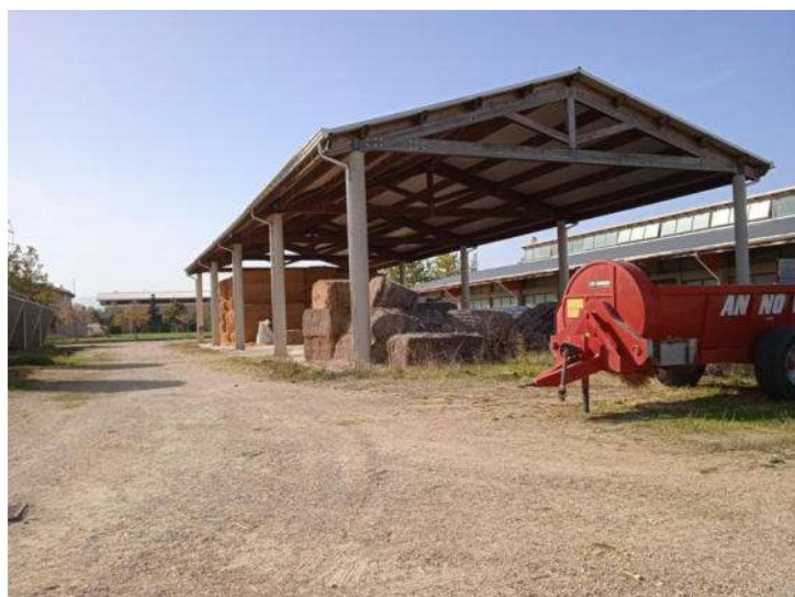
Foto n. 32 – Fabbricato C - Tettoia fienile - Part. 378 sub 5
