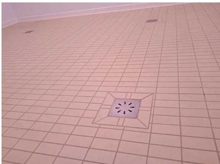
Foto n. 135 – Fabbricato N - Vista interna - Part. 378 sub 5
