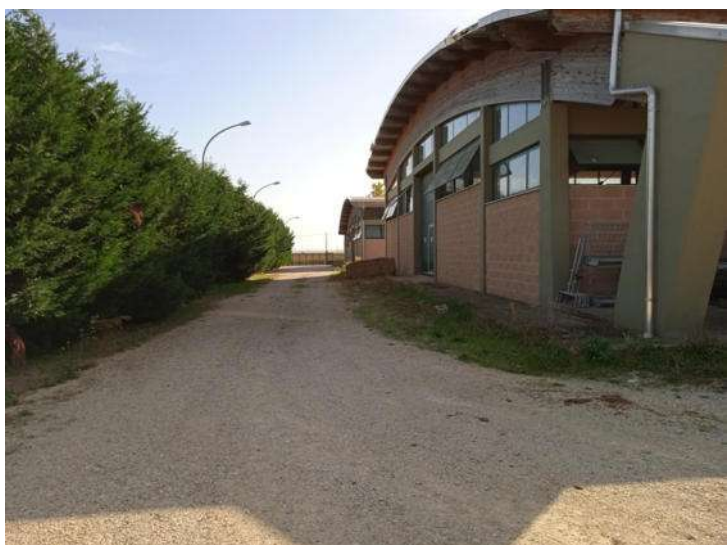
Foto n. 21 – Fabbricato B - Stalla - Part. 378 sub 5 - Vista esterna
