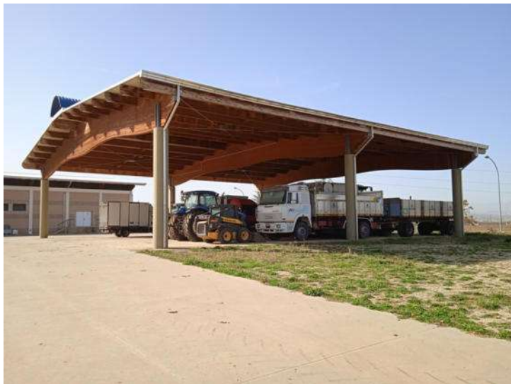
Foto n. 54 – Fabbricato F - Tettoia autoparco e deposito - Part. 378 sub 5
