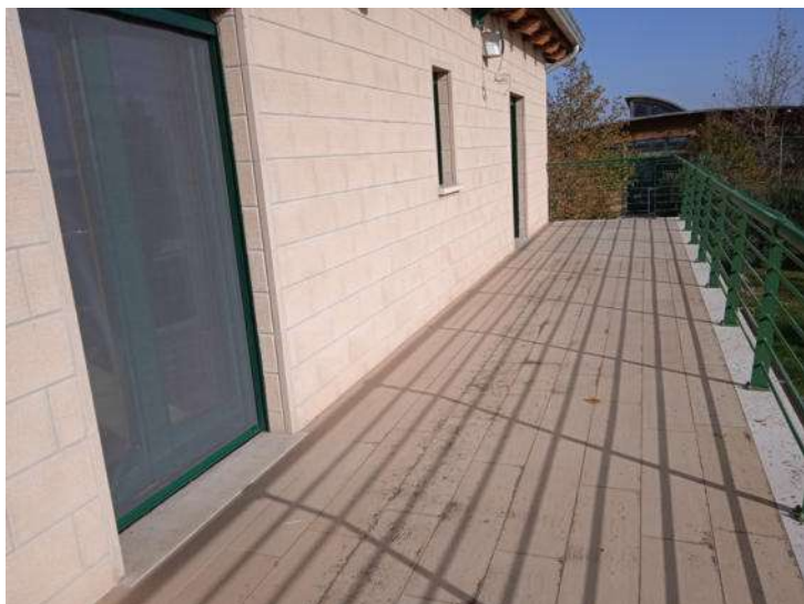
Foto n. 89 – Fabbricato H - Uffici piano primo - Part. 378 sub 5
