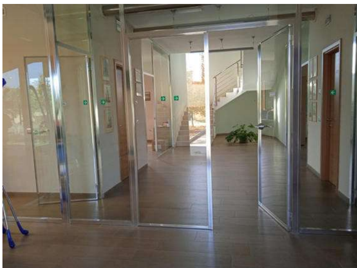
Foto n. 73 – Fabbricato H - Uffici piano terra - Part. 378 sub 5
