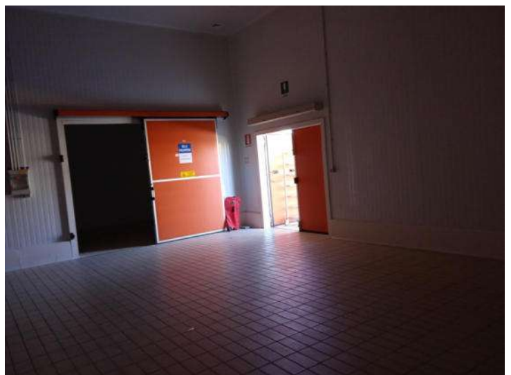
Foto n. 136 – Fabbricato N - Vista interna - Part. 378 sub 5
