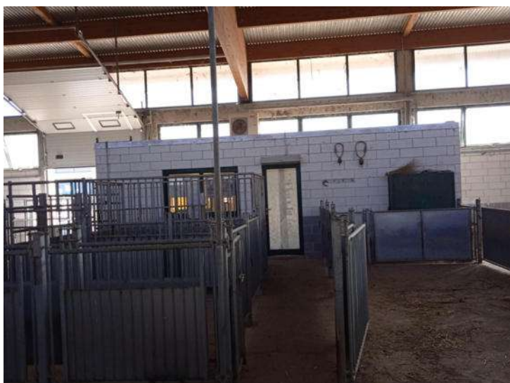
Foto n. 27 – Fabbricato B - Stalla - Part. 378 sub 5 - Vista interna
