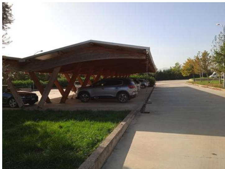
Foto n. 90 – Fabbricato I - Tettoia parcheggio - Part. 378 sub 5
