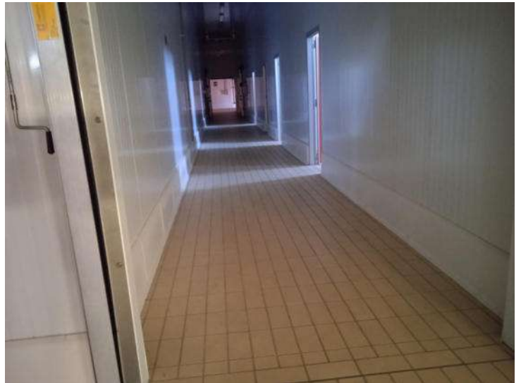
Foto n. 132 – Fabbricato N - Vista interna - Part. 378 sub 5
