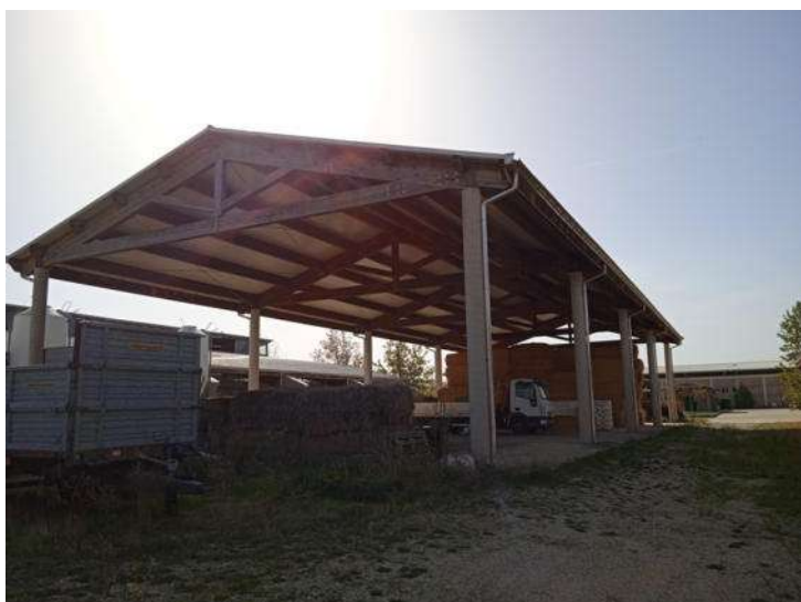
Foto n. 33 – Fabbricato C - Tettoia fienile - Part. 378 sub 5
