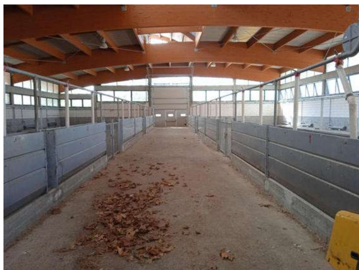
Foto n. 16 – Fabbricato A - Stalla - Part. 378 sub 5 - Vista interna
