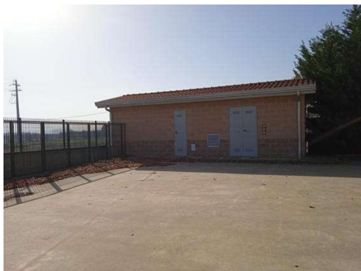
Foto n. 8 – Vista area esterna - accesso laterale sinistro
