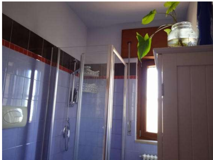
Foto n. 120 – Fabbricato L - Piano terra - Part. 378 sub 3
