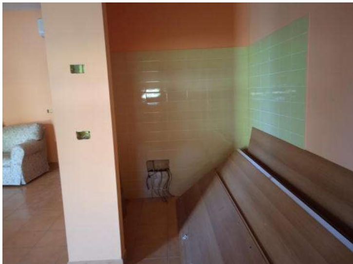
Foto n. 113 – Fabbricato L - Piano terra - Part. 378 sub 4
