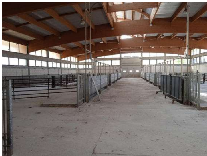
Foto n. 42 – Fabbricato D - Stalla - Part. 378 sub 5 - Vista interna
