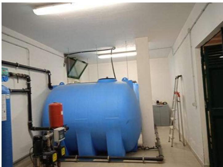
Foto n. 103 – Fabbricato L - Piano interrato - Part. 378 sub 5
