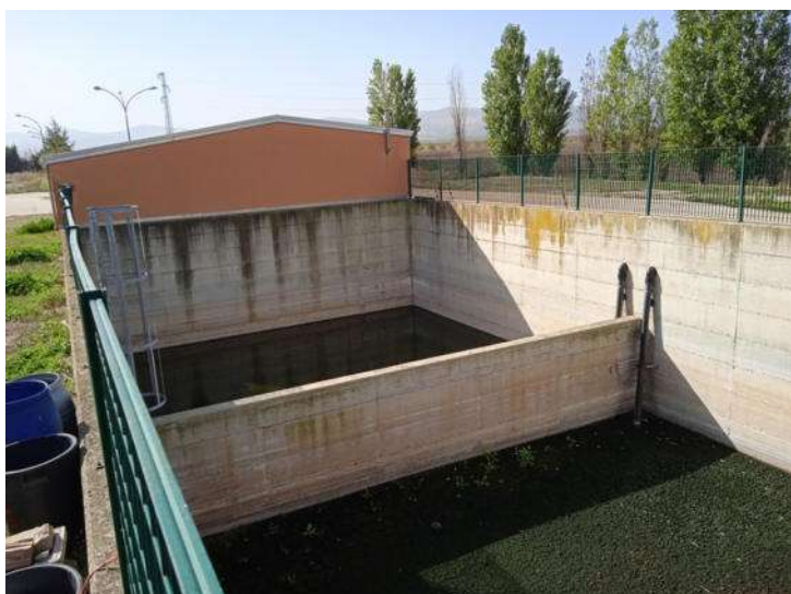
Foto n. 49 – Locale E - Vasche - Part. 378 sub 5 - Vista esterna
