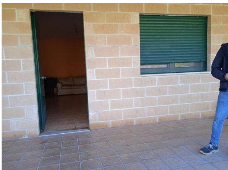
Foto n. 111 – Fabbricato L - Piano terra - Part. 378 sub 4
