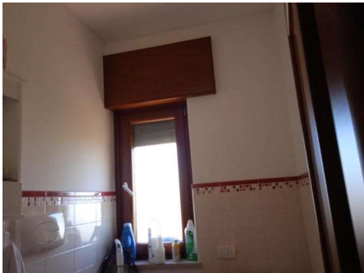
Foto n. 119 – Fabbricato L - Piano terra - Part. 378 sub 3
