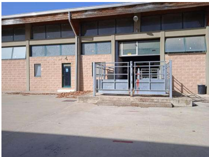
Foto n. 23 – Fabbricato B - Stalla - Part. 378 sub 5 - Vista esterna
