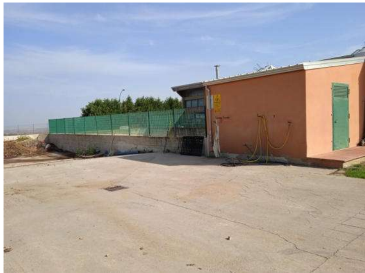
Foto n. 48 – Locale E - Riserva idrica e vasche - Part. 378 sub 5 - Vista esterna
