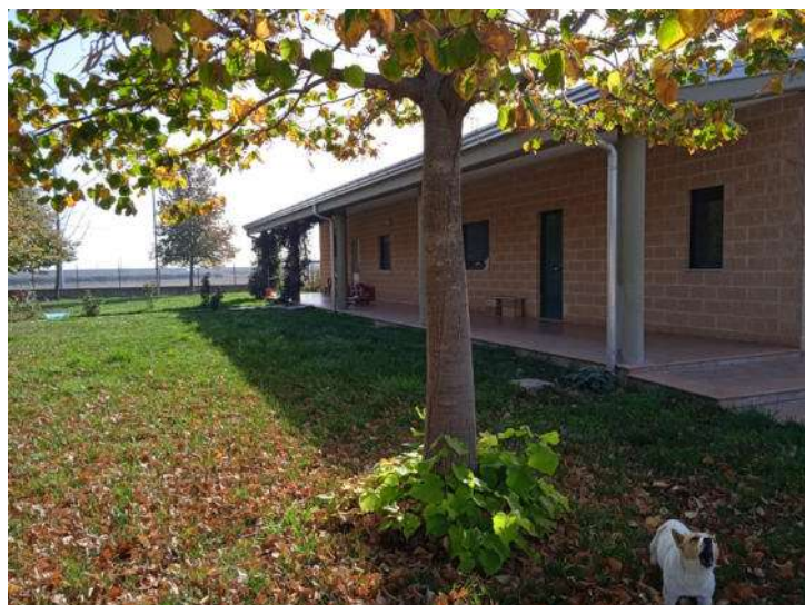
Foto n. 98 – Fabbricato L - Vista esterna - Part. 378 sub 3, 4, 5
