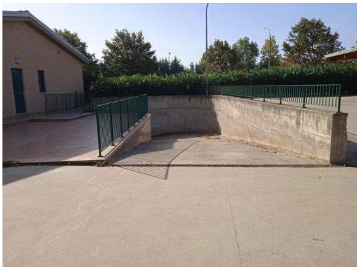
Foto n. 99 – Fabbricato L - Vista esterna - Part. 378 sub 3, 4, 5
