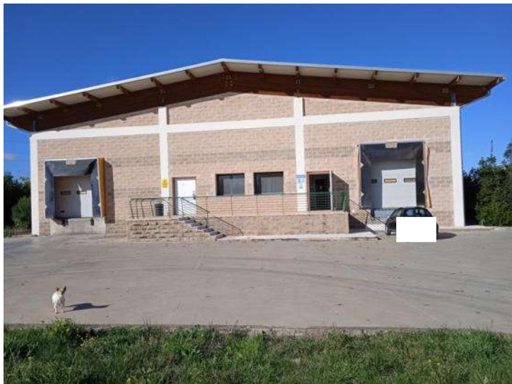
Foto n. 125 – Fabbricato N - Vista esterna - Part. 378 sub 5
