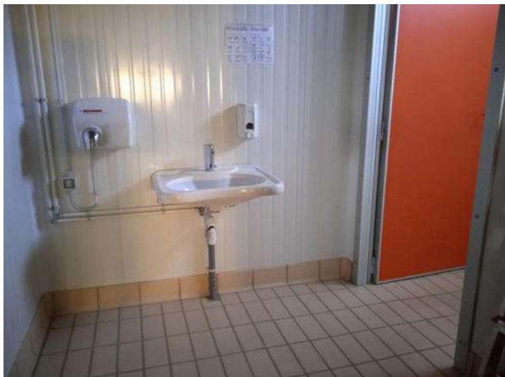
Foto n. 133 – Fabbricato N - Vista interna - Part. 378 sub 5
