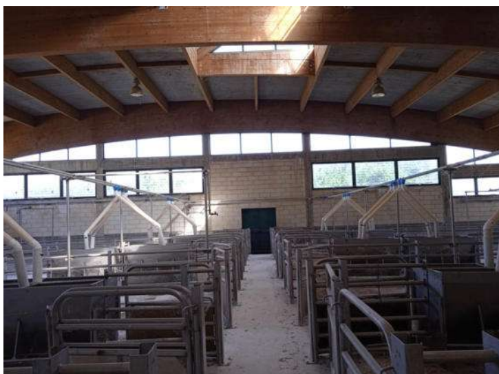
Foto n. 43 – Fabbricato D - Stalla - Part. 378 sub 5 - Vista interna
