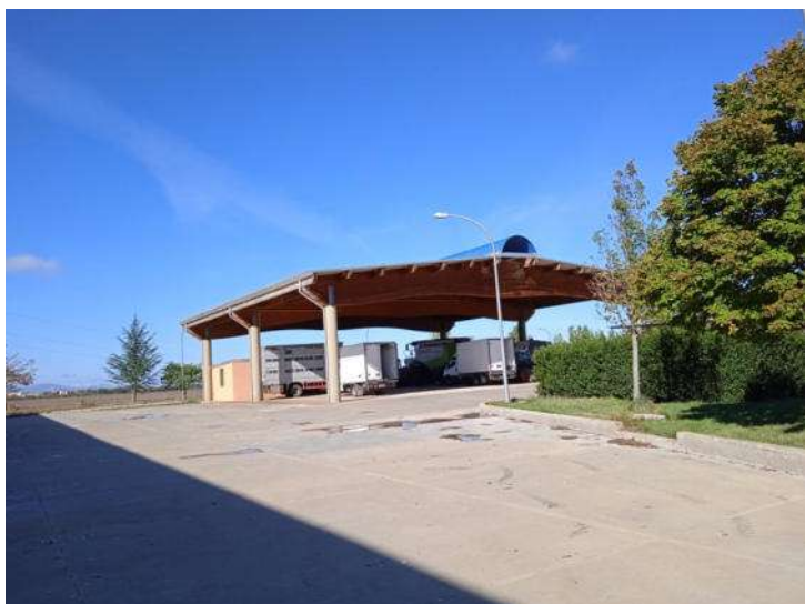
Foto n. 55 – Fabbricato F - Tettoia autoparco e deposito - Part. 378 sub 5
