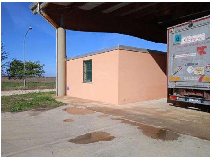
Foto n. 57 – Fabbricato F - Tettoia autoparco e deposito - Part. 378 sub 5
