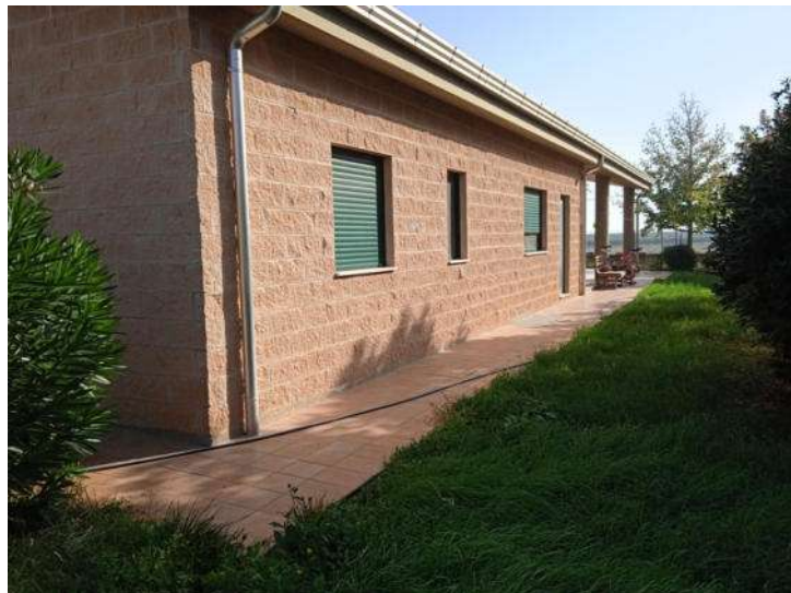
Foto n. 96 – Fabbricato L - Vista esterna - Part. 378 sub 3, 4, 5
