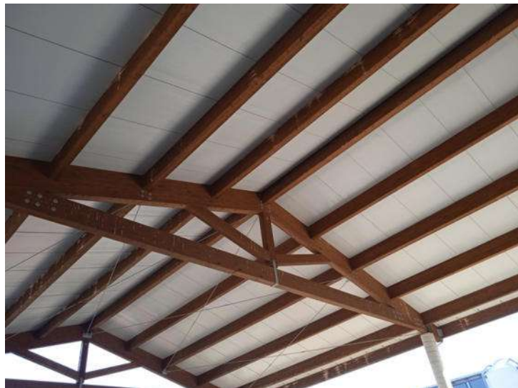
Foto n. 36 – Fabbricato C - Tettoia fienile - Part. 378 sub 5
