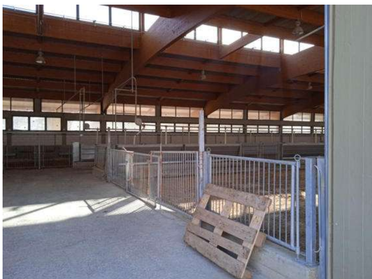
Foto n. 15 – Fabbricato A - Stalla - Part. 378 sub 5 - Vista interna
