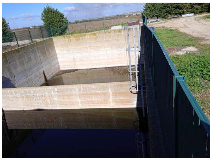
Foto n. 50 – Locale E - Vasche - Part. 378 sub 5 - Vista esterna
