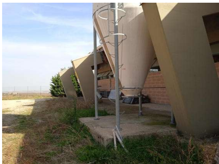
Foto n. 22 – Fabbricato B - Stalla - Part. 378 sub 5 - Vista esterna
