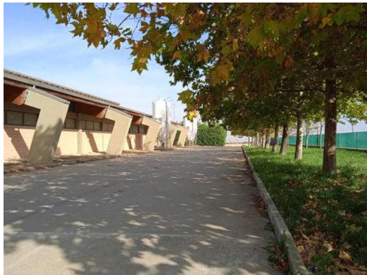
Foto n. 12 – Fabbricato A - Stalla - Part. 378 sub 5 - Vista esterna
