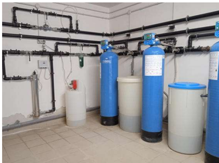
Foto n. 104 – Fabbricato L - Piano interrato - Part. 378 sub 5
