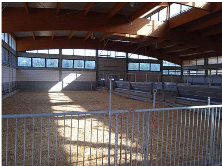
Foto n. 17 – Fabbricato A - Stalla - Part. 378 sub 5 - Vista interna
