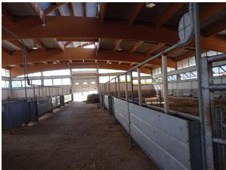
Foto n. 29 – Fabbricato B - Stalla - Part. 378 sub 5 - Vista interna
