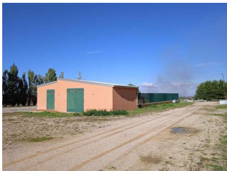
Foto n. 46 – Locale E - Riserva idrica e vasche - Part. 378 sub 5 - Vista esterna
