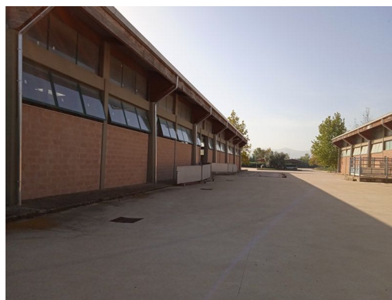
Vista esterna prospetti
