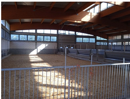
Fabbricato A - Vista interna
