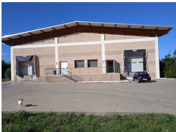
Vista esterna prospetti
