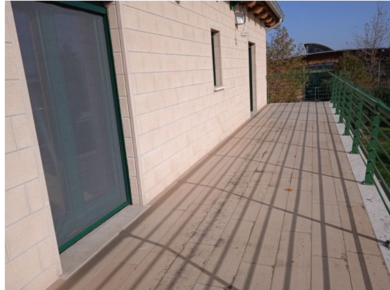
Fabbricato H - Vista interna piano primo
