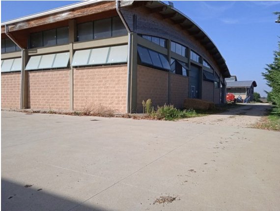
Vista esterna prospetti
