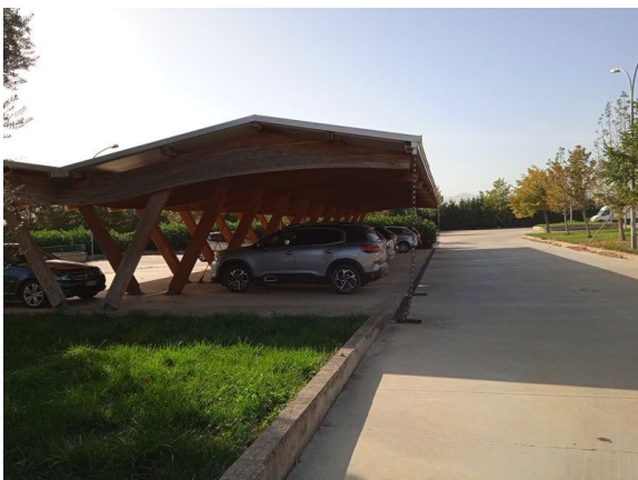
Vista tettoia parcheggio
