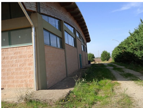
Vista esterna prospetti
