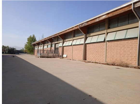
Vista esterna prospetti
