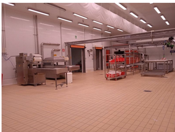
Fabbricato N - Vista interna
