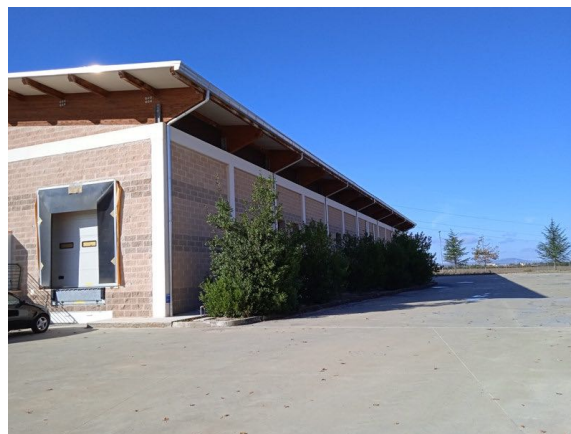
Vista esterna prospetti
