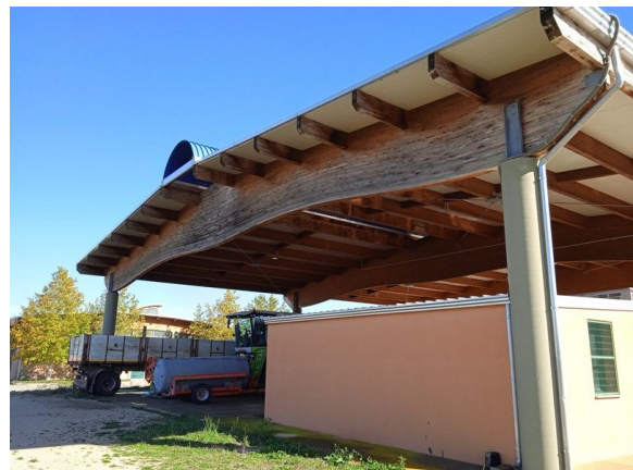
Vista tettoia e deposito
