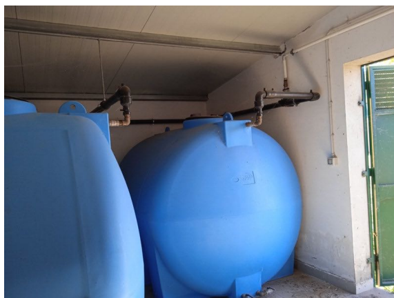
Vista esterna locale riserva idrica
