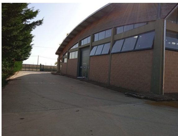
Vista esterna prospetti
