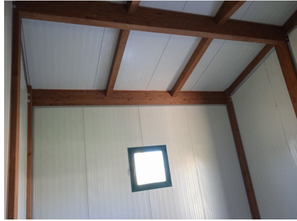
Vista interna deposito G
