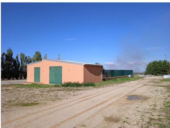
Vista esterna locale riserva idrica
