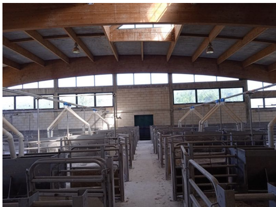
Fabbricato D - Vista interna
