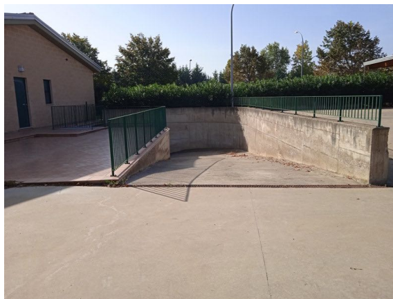
Vista esterna prospetti
