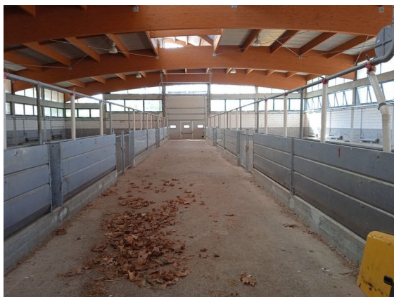
Fabbricato A - Vista interna
