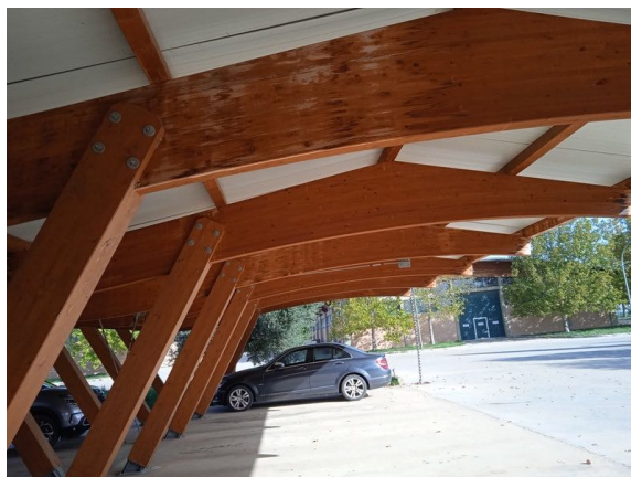
Vista tettoia parcheggio
