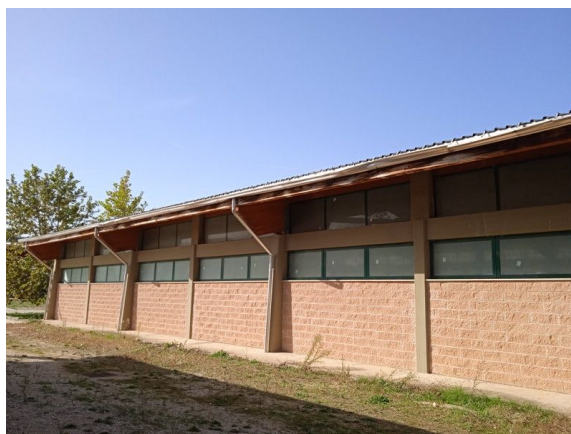
Vista esterna prospetti
