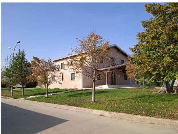
Vista esterna prospetti
