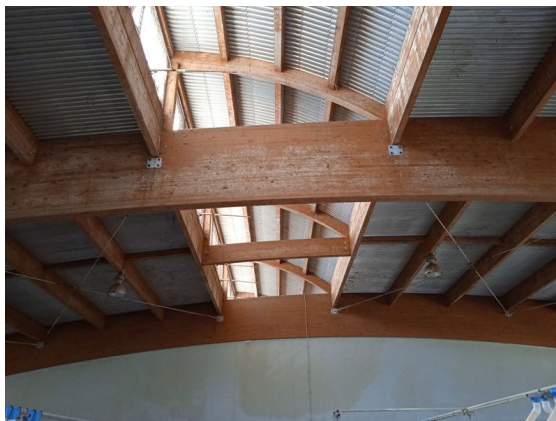
Fabbricato D - Vista interna
