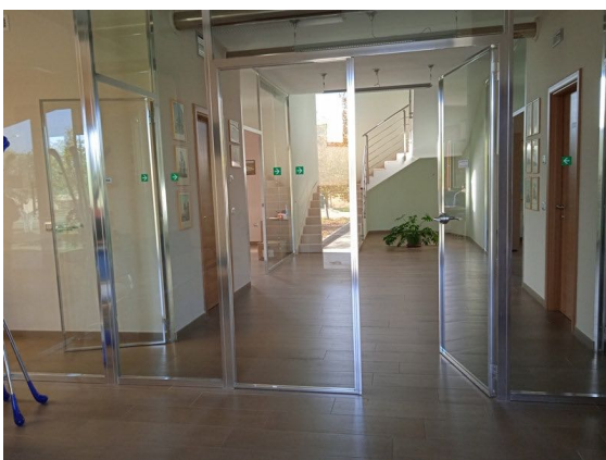
Fabbricato H - Vista interna piano terra
