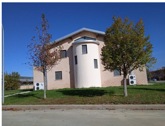
Vista esterna prospetti
