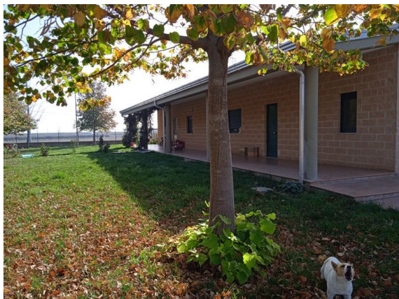
Vista esterna prospetti
