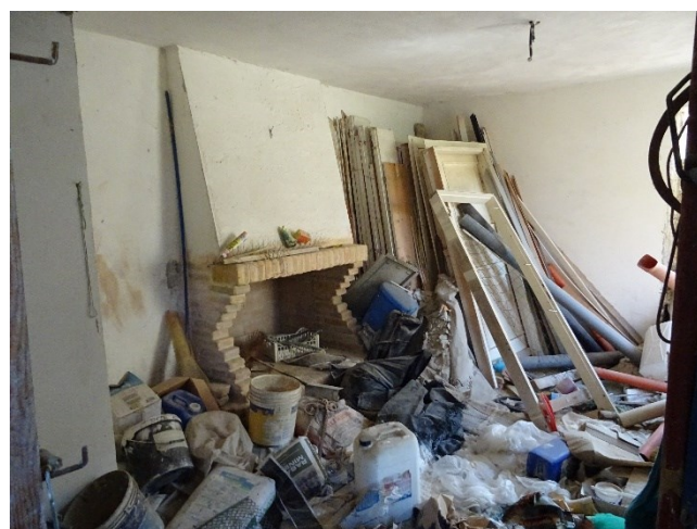
Sub.4 Abitaz.: Piano T – Cucina (vista da ingresso)
