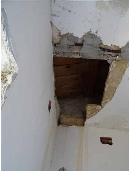
Sub.4 Abitaz.: Vista stralcio sottotetto da P1
