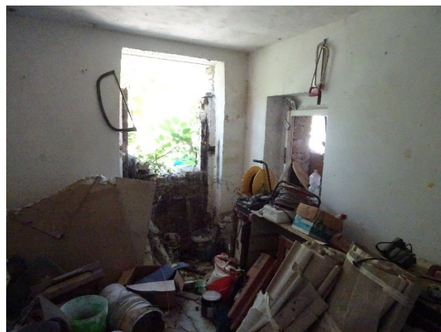
Sub.4 Abitaz.: Piano T – Camera lato S-O
