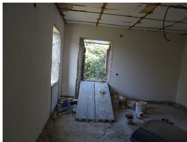
Sub.4 Abitaz.: Piano 1° – Camera lato N-E
