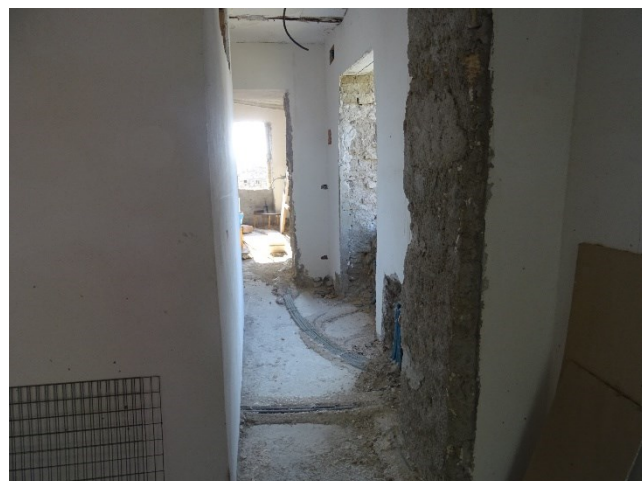
Sub.4 Abitaz.: Piano 1° – Disimpegno
