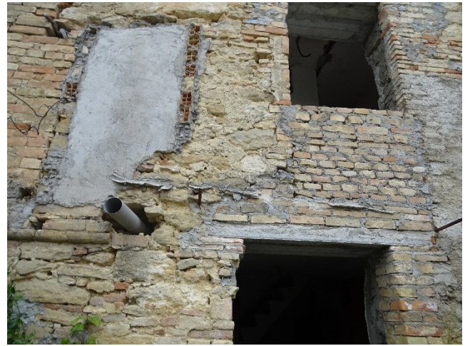
Sub.4 Zona esterna precedente ingresso e WC esterno su ballatoio P1 (demoliti)
