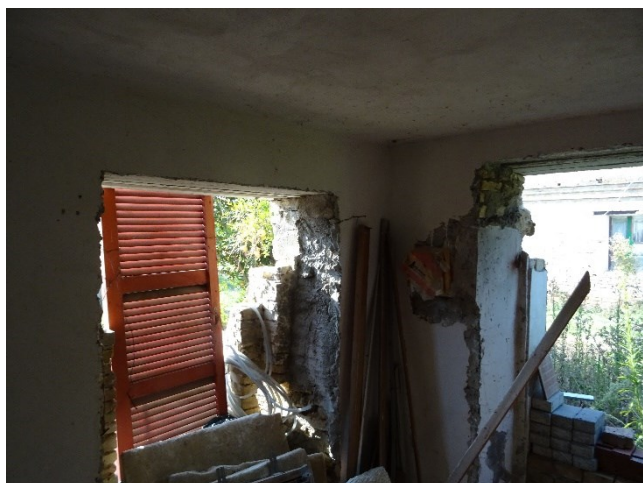
Sub.4 Abitaz.: Piano T – Cucina (angolo lato Sud)
