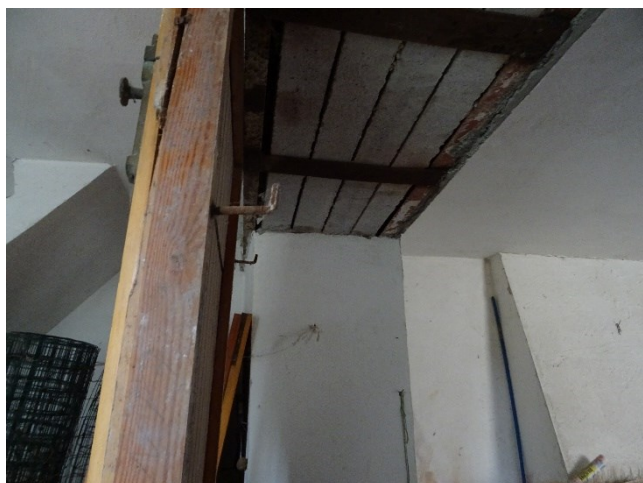
Sub.4 Abitaz.: Piano T – Apertura setto cucina-ingresso
