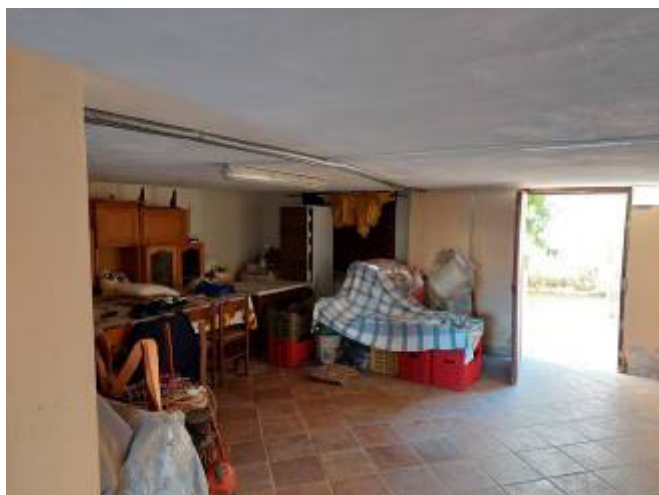
Pilotis adibito a deposito - PT
