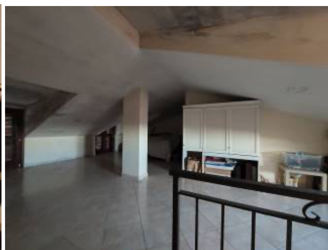
Sottotetto mansardato – P3
