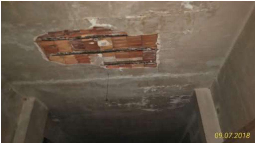
Esecuzione immobiliare n. 214.2015 Lotto 003. Foto n 4. Interno. Soffitto.
