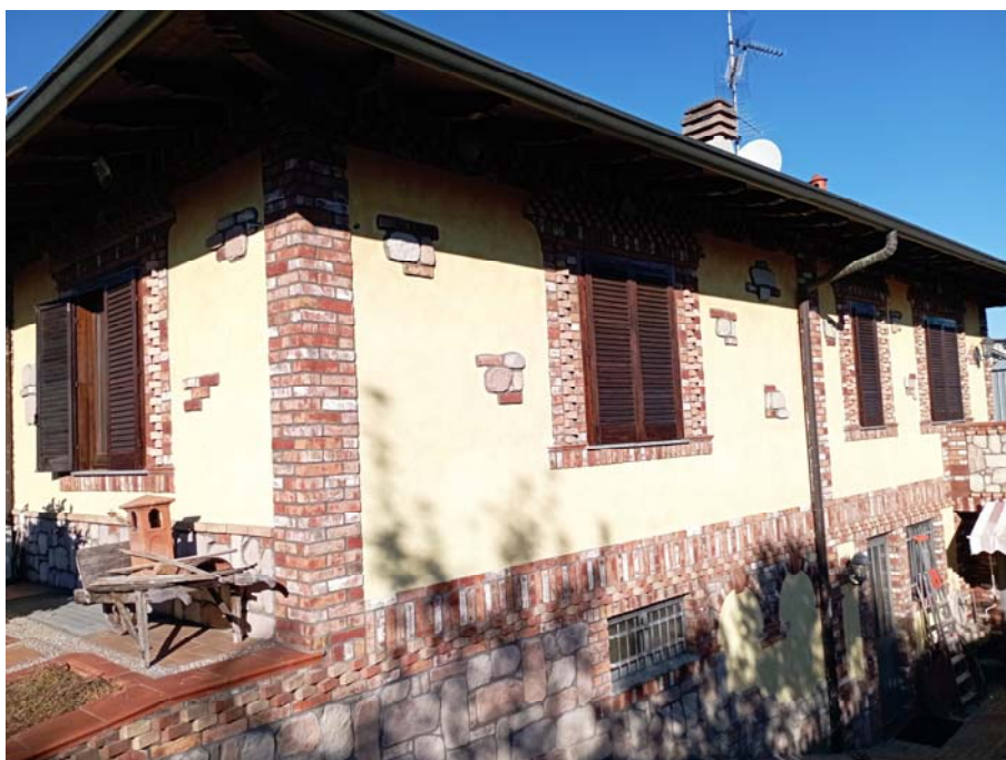
F2 FRONTE DESTRO (RAMPA CARRABILE)
