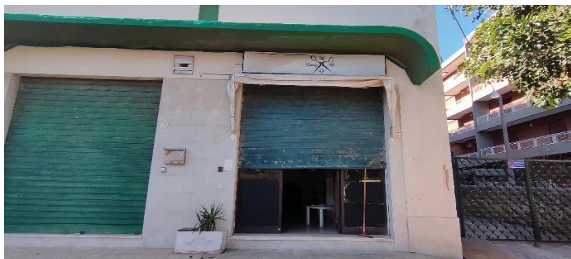
Foto 8: esterno lato via servi di maria
