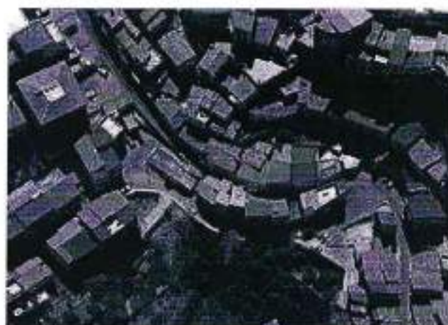
foto aerea della zona in cui ricade il fabbricato
