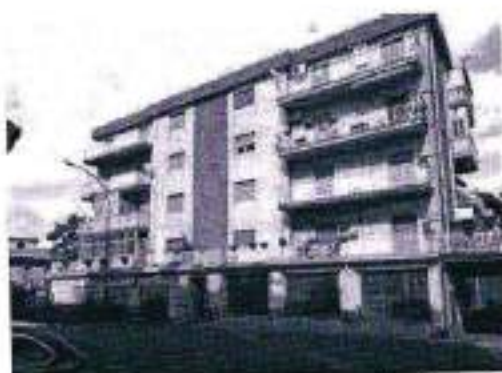
Prospetto principale del fabbricato con in evidenza il corpo "N"
