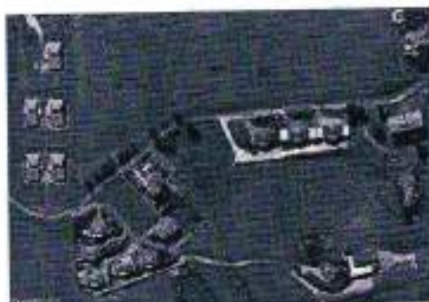
foto aerea dalla zona in cui ricade il fabbricato di cui al corpo "D"
