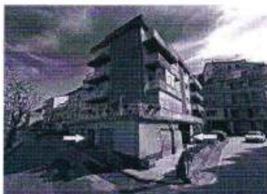
Edificio in cui ricade il corpo "O" (in evidenza gli accessi)
