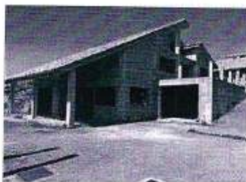
Fabbricato di cui al corpo "A"
