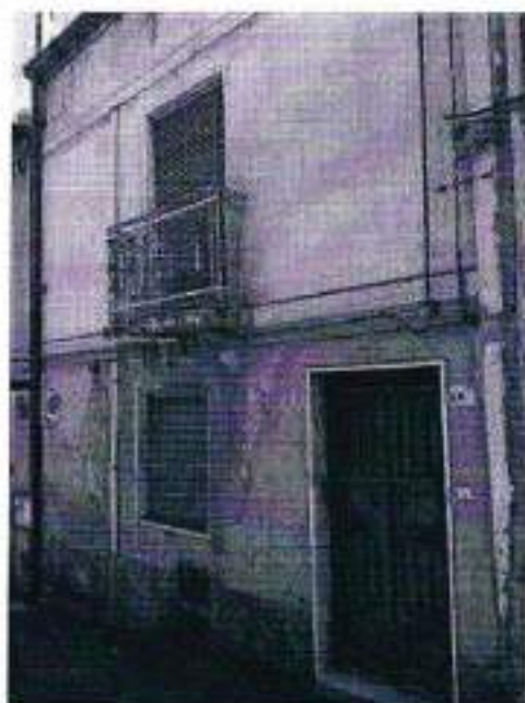
Prospetto del fabbricato da via Gebbia
