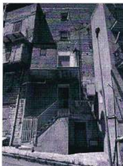
Prospetto del fabbricato da via Cinuca
