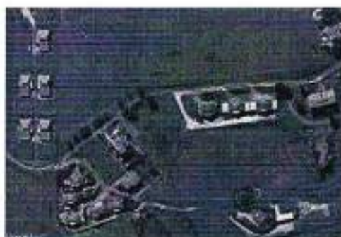
foto aerea della zona in cui ricade il fabbricato di cui al corpo "C"
