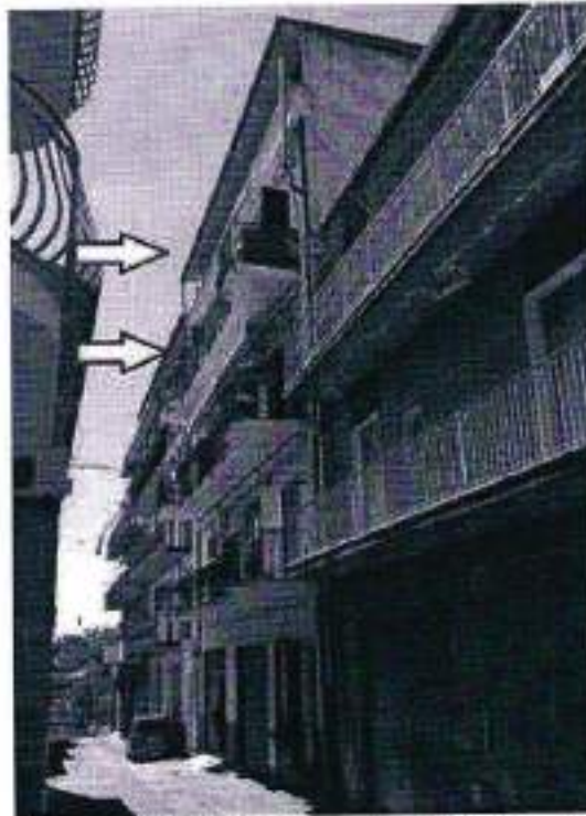
Prospetto principale del fabbricato (con indicazione del corpo H)
