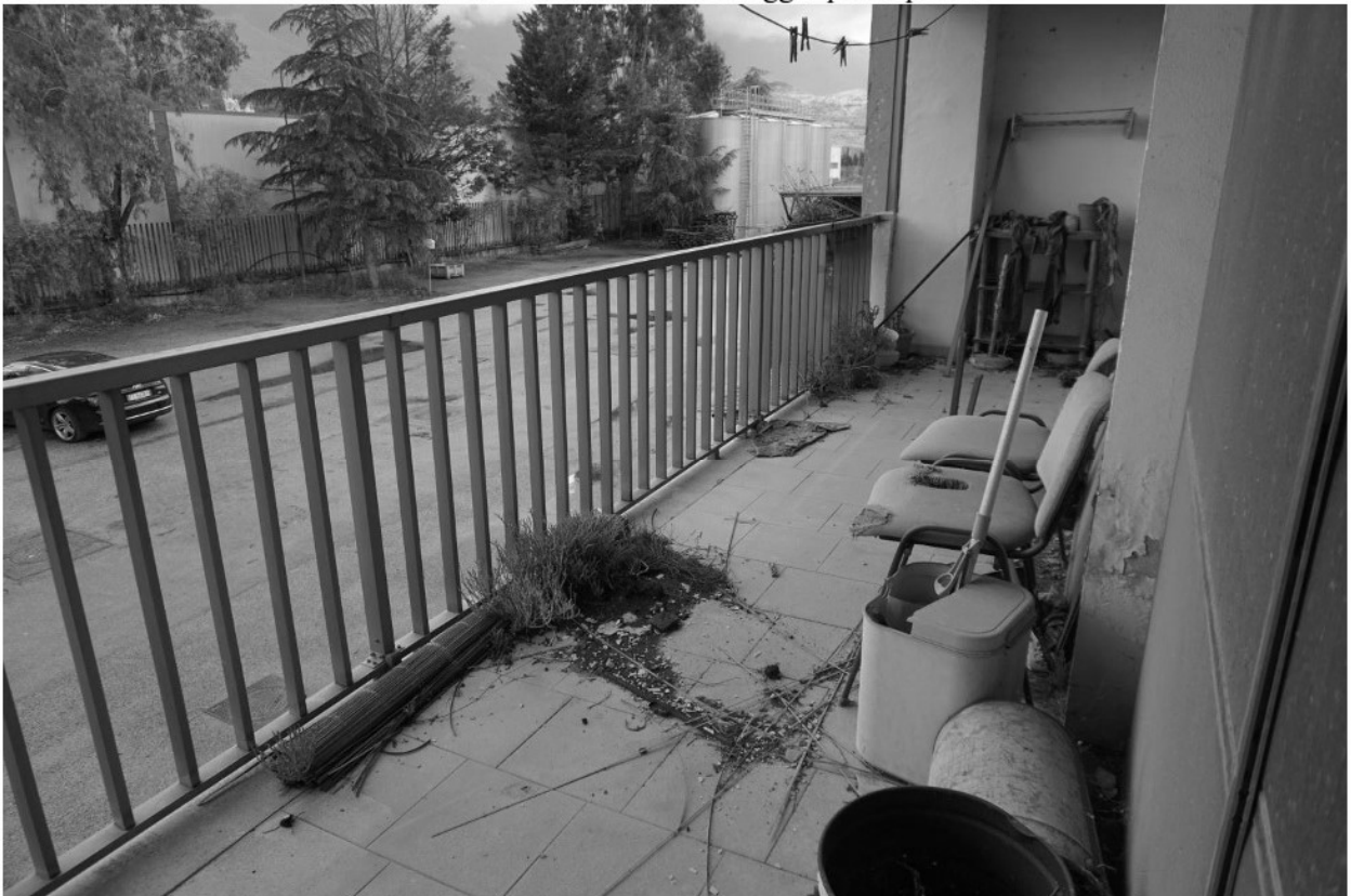
foto n. 48 – locali ufficio e alloggio piano primo
