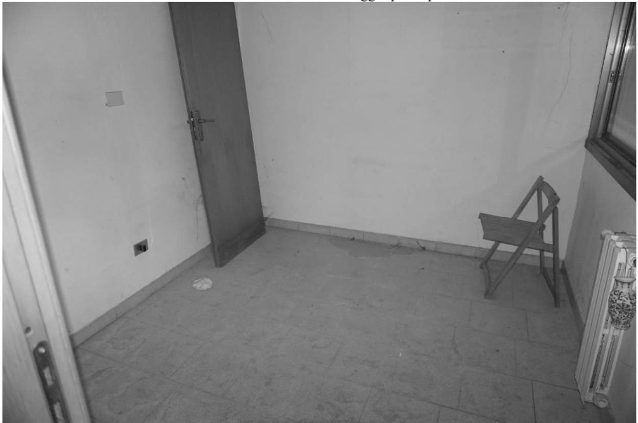
foto n. 44 – locali ufficio e alloggio piano primo
