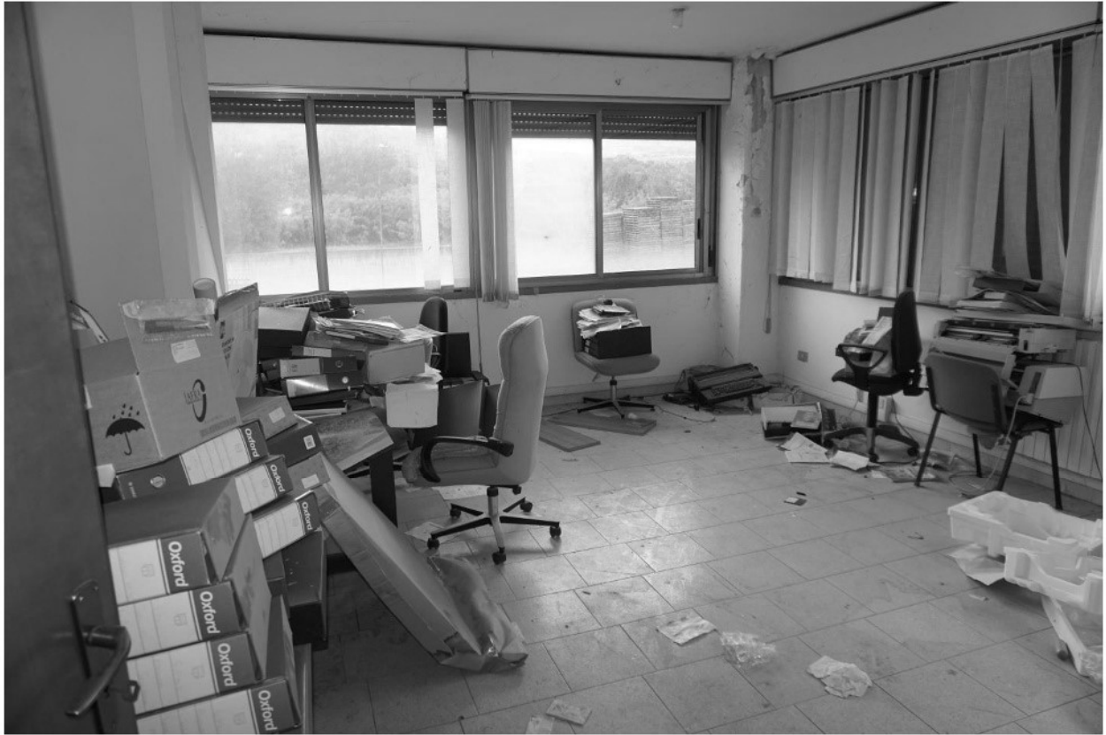
foto n. 41 – locali ufficio e alloggio piano primo
