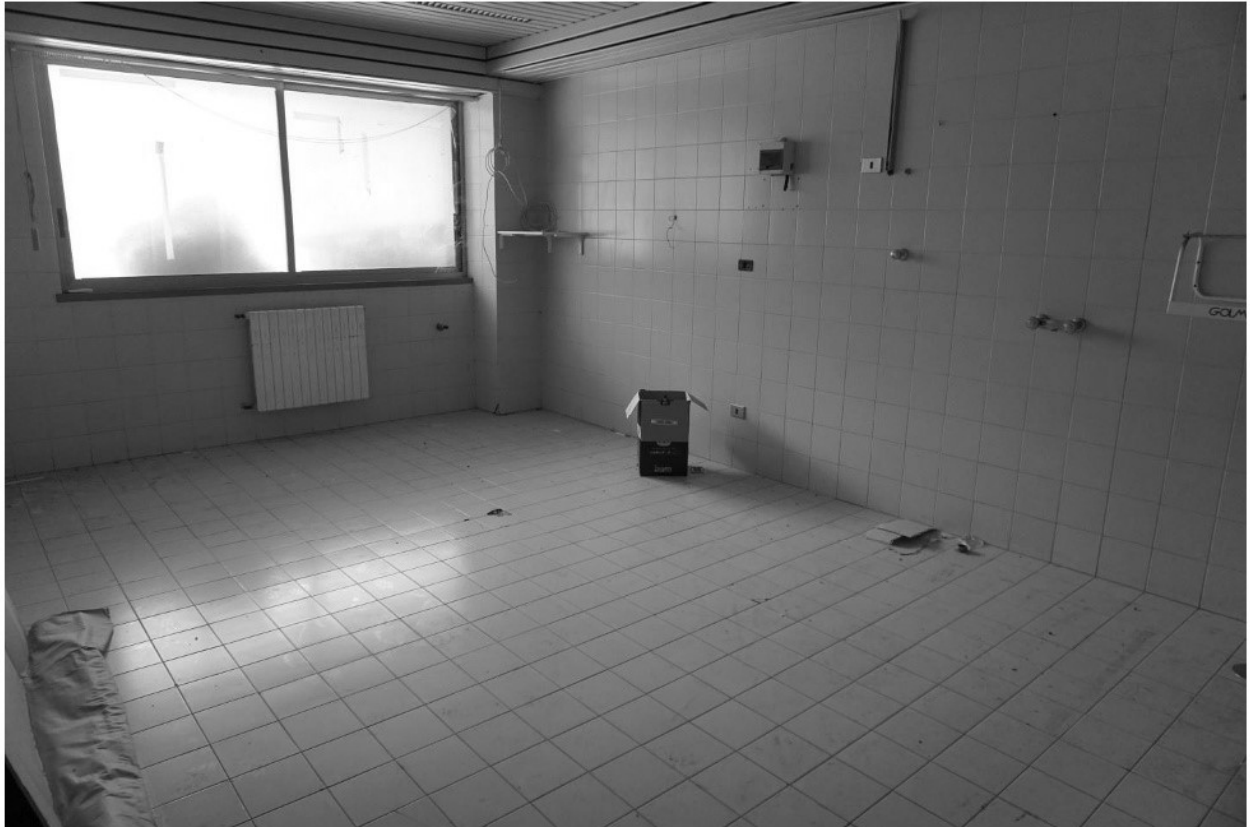
foto n. 31 – locali ufficio piano terra
