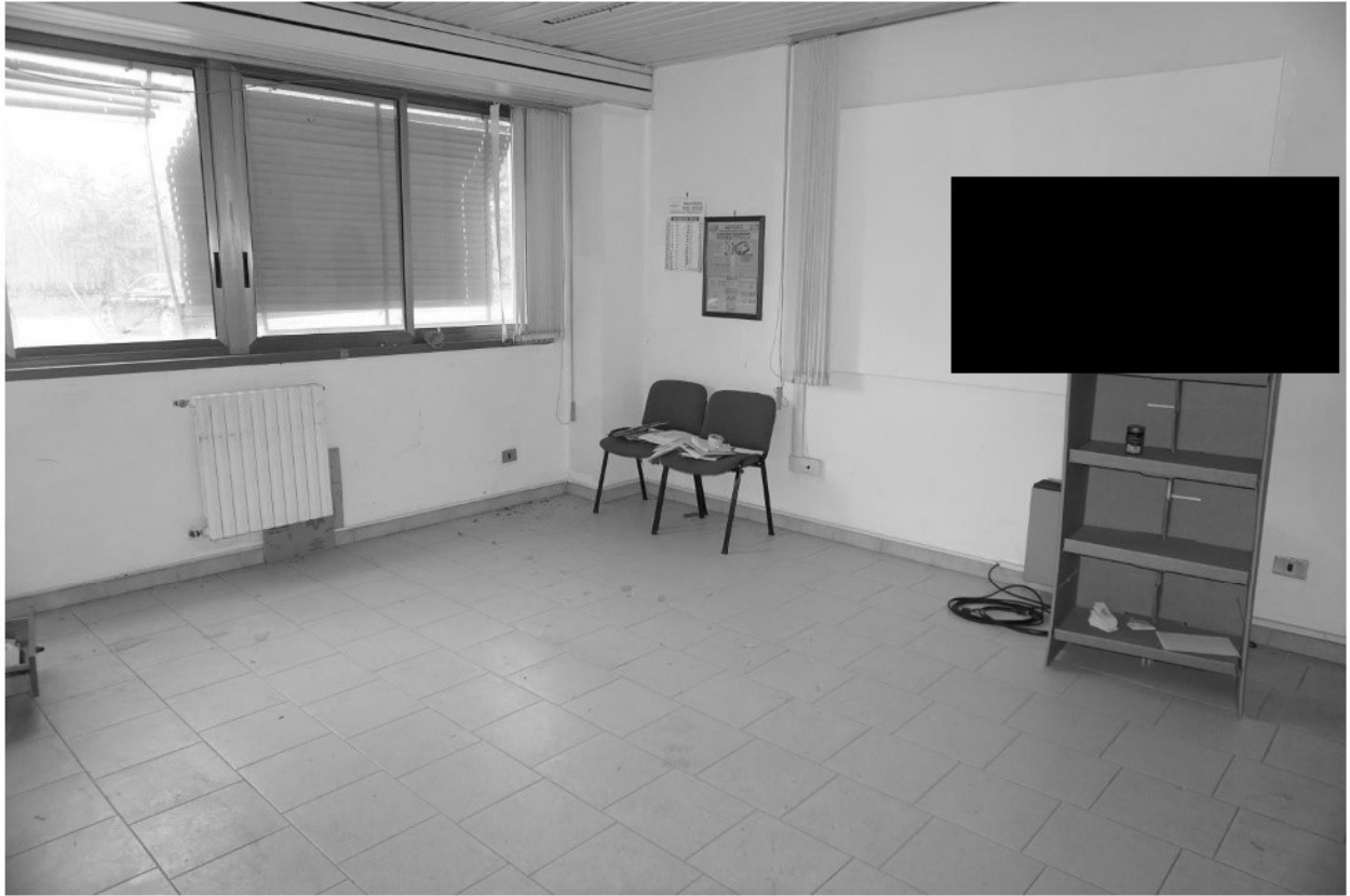
foto n. 33 – locali ufficio piano terra
