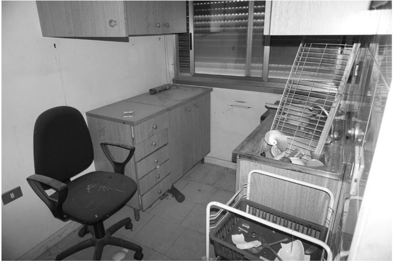
foto n. 43 – locali ufficio e alloggio piano primo
