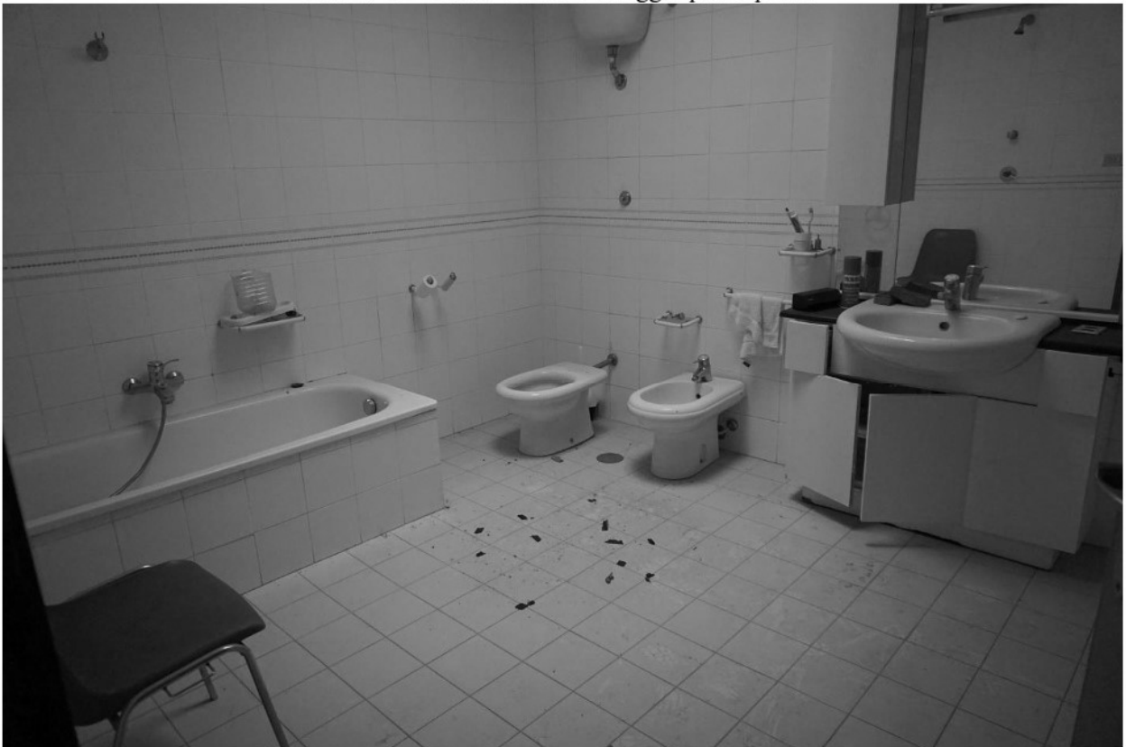
foto n. 46 – locali ufficio e alloggio piano primo
