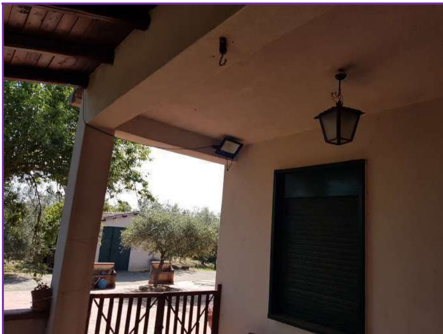
Vista esterna casa unifamiliare di c.da Oliva
