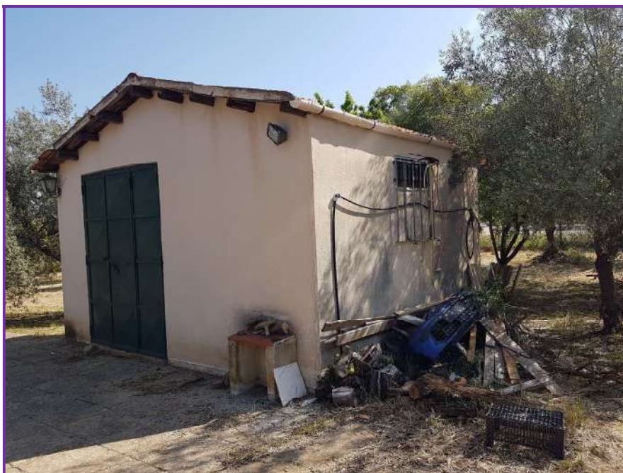
Vista esterna deposito di c.da Oliva (locale abusivo)
