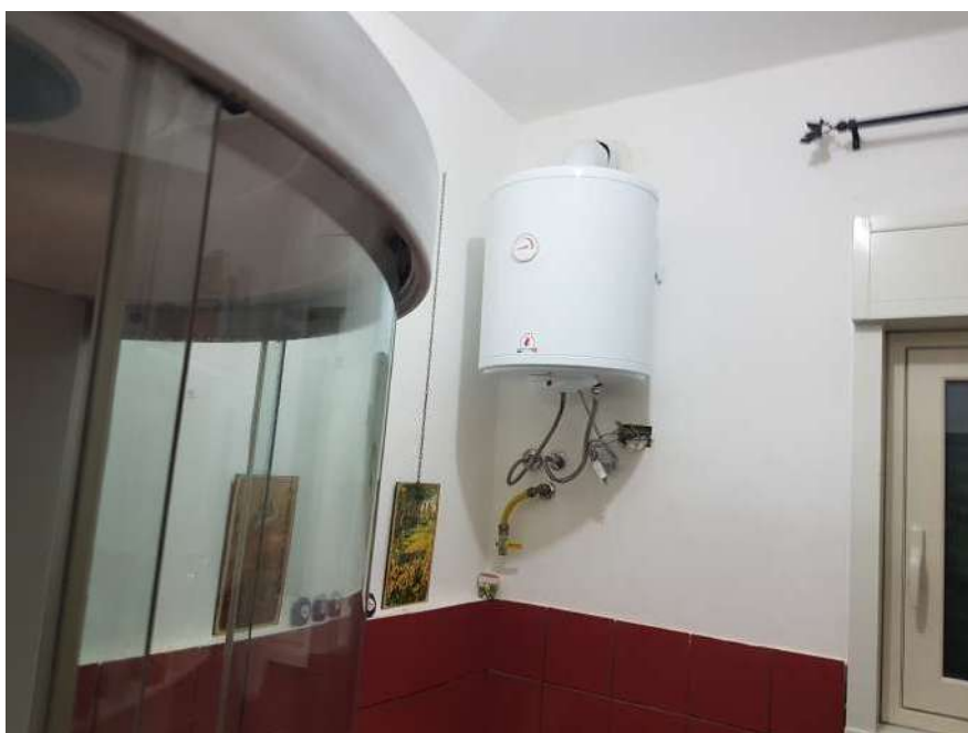
Vista interna immobile di c.da Oliva
