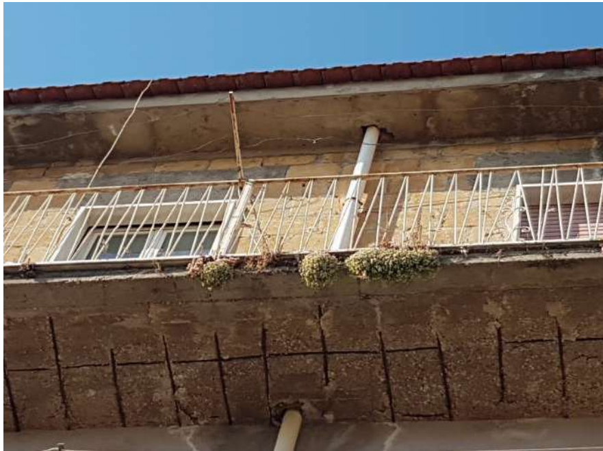
Prospetto immobile da via Marconi
