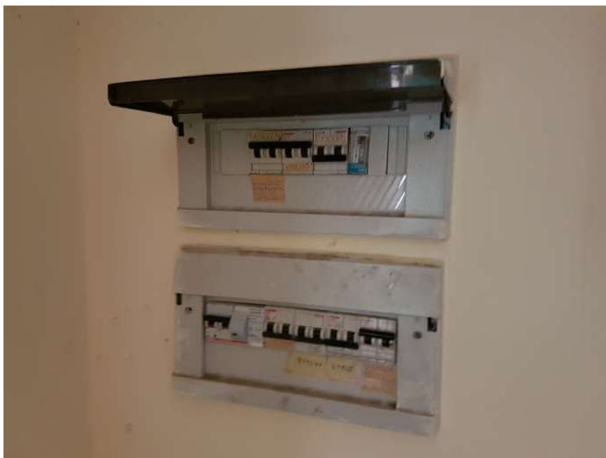
Vista interna immobile di c.da Oliva
