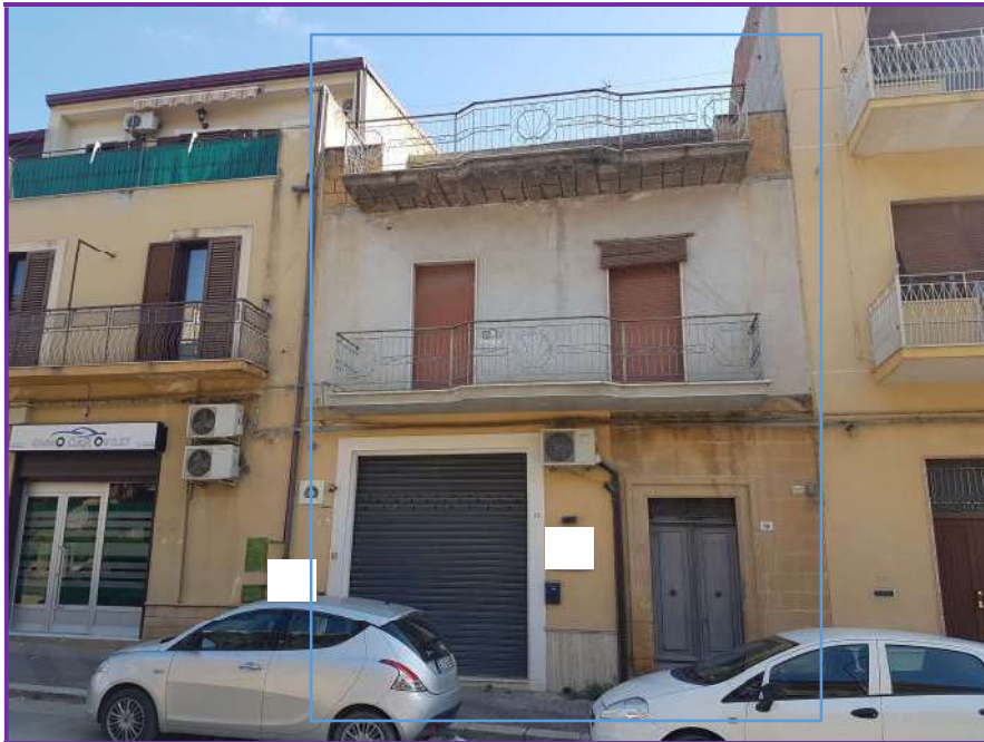
Prospetto immobile da via Marconi
