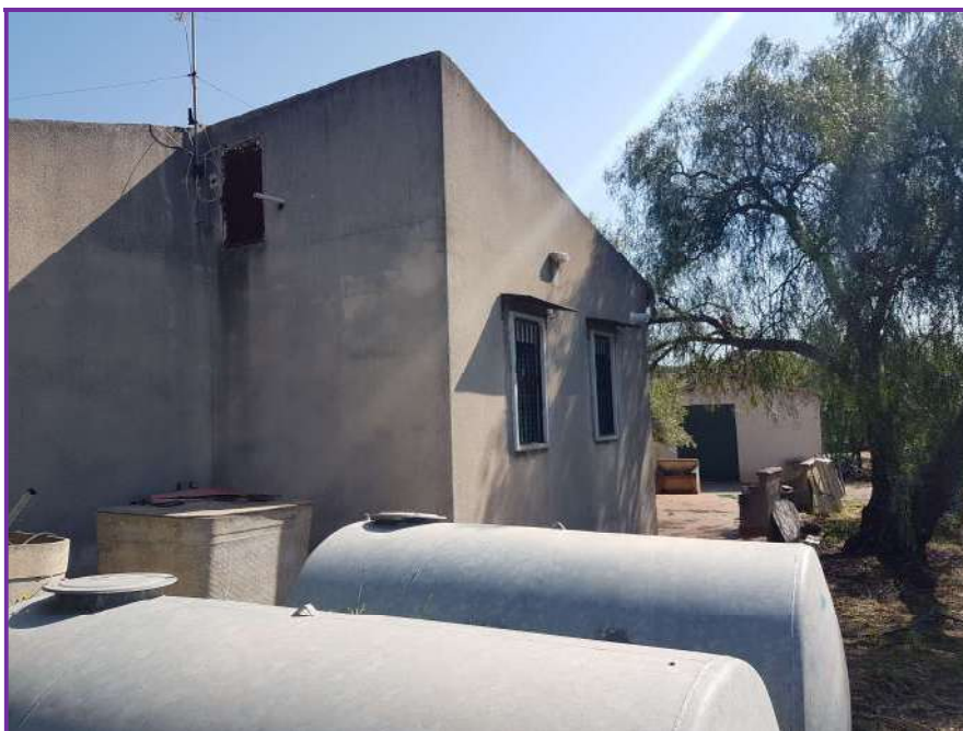
Vista esterna casa unifamiliare di c.da Oliva
