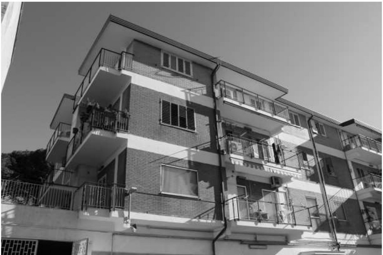
foto n. 2 – inquadramento dell'intero fabbricato
