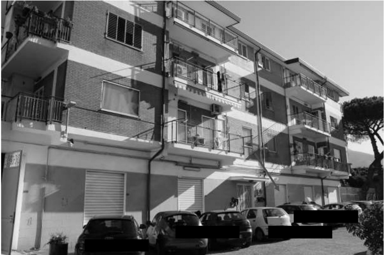
foto n. 1 – inquadramento dell'intero fabbricato
