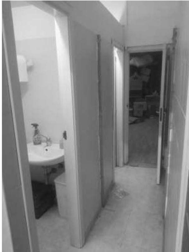
foto n. 7 –interno locale (corridoio bagni)
