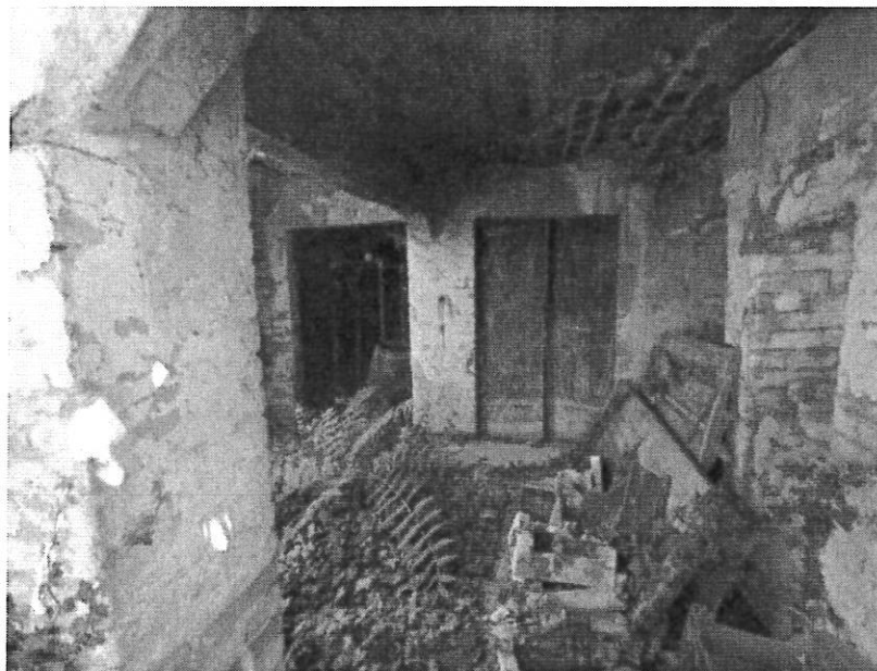
Locale rimessa al piano sottostrada
