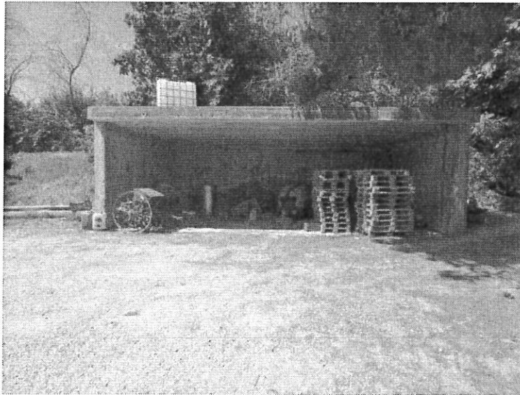
Manufatto esterno al piano terra
