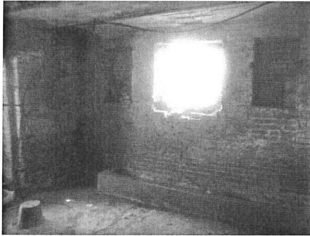
Locale stalla al piano sottostrada
