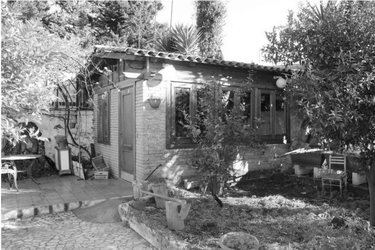
foto n. 33 – area esterna al locale (costruzione abusiva)
