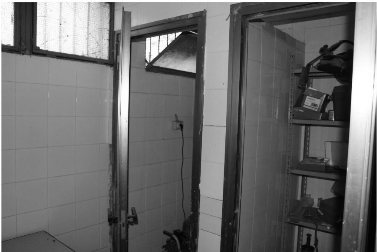
foto n. 24 – interno locale (parte abusiva)
