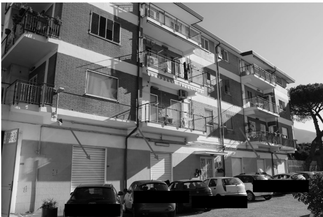
foto n. 2 – inquadramento dell'intero fabbricato
