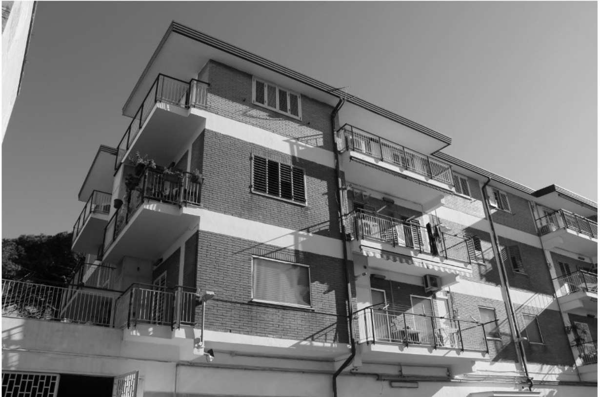
foto n. 3 – inquadramento dell'intero fabbricato
