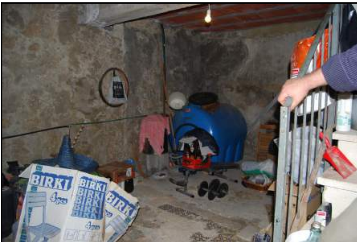
FOTO 7 – Nicosia - Foglio 82/L – Particella 2669 – Piano seminterrato – Cantina e deposito idrico
