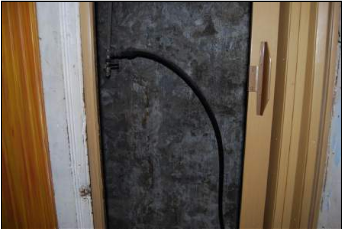
FOTO 74 – Nicosia - Foglio 82 – Particella 2669 – Sub. 2 – Piano terra – Ripostiglio
