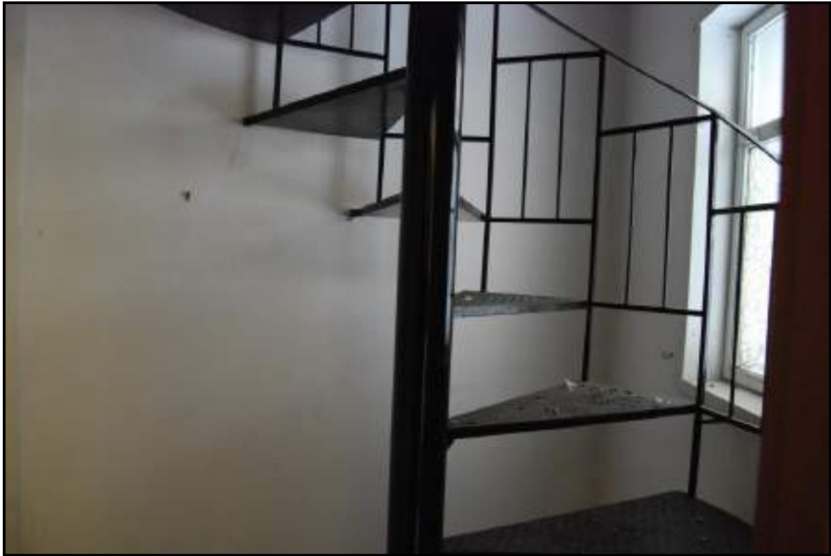
FOTO 31 – Nicosia - Foglio 82/I – Particelle 2467 – Sub. 2 – Piano terra – Vano scala
