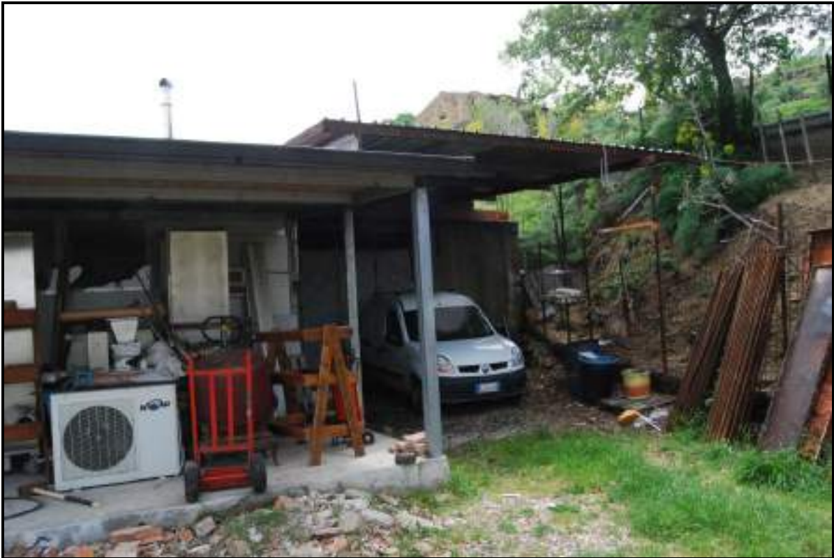
FOTO 41 – Nicosia - Foglio 68 – Particella 360 - Sub 1 e Sub 2 – Veduta Ovest degli immobili di Contrada Scaletta
