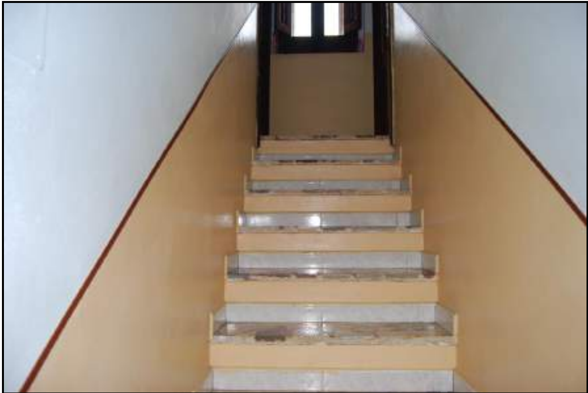
FOTO 47 – Nicosia - Foglio 68 – Particella 360 - Sub 1 – Piano terra – Vano scala
