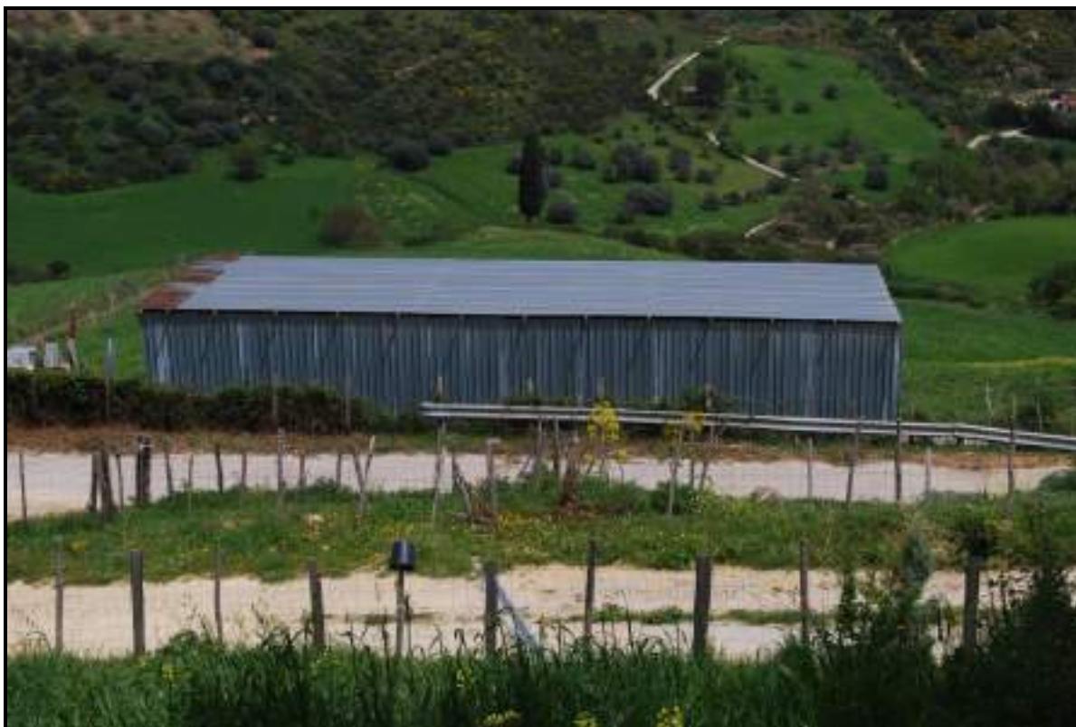
FOTO 63 – Nicosia - Foglio 68 – Particella 396 - Sub 2 – Veduta esterna dell'immobile mai dichiarato insistente sulla part. 270
