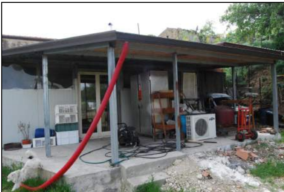
FOTO 40 – Nicosia - Foglio 68 – Particella 360 - Sub 2 – Veduta esterna dell'ampliamento su corte
