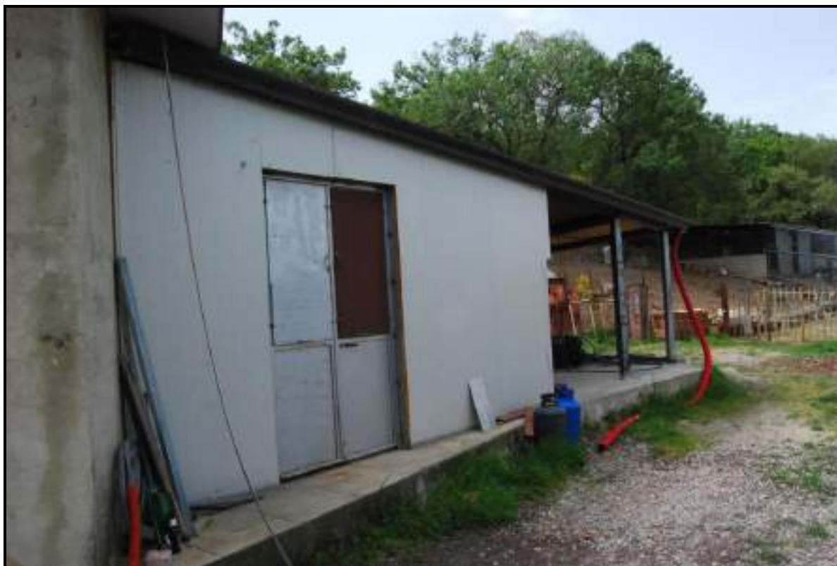
FOTO 39 – Nicosia - Foglio 68 – Particella 360 - Sub 2 – Veduta esterna dell'ampliamento su corte
