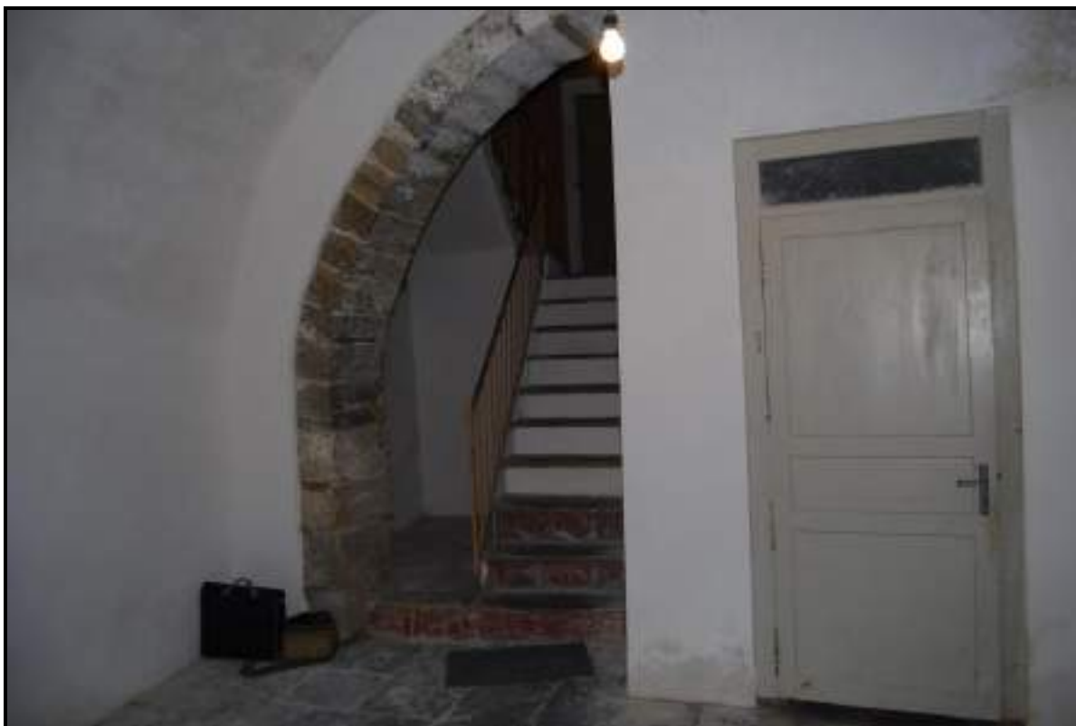
FOTO 70 – Nicosia - Foglio 82 – Particella 2669 – Sub. 1 – Piano terra – Atrio d'ingresso (ex porzione rurale fabbricato promiscuo)
