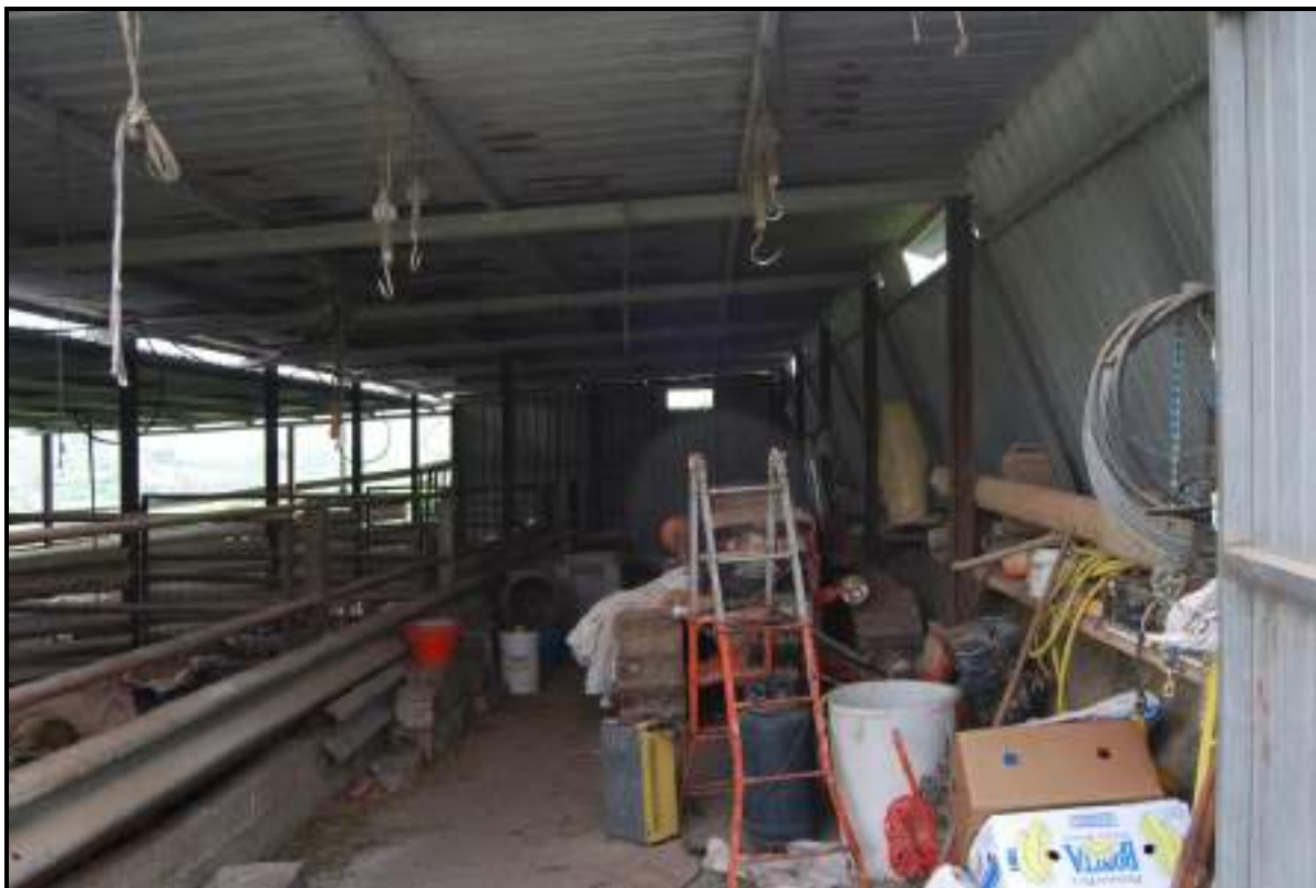
FOTO 62 – Nicosia - Foglio 68 – Particella 396 - Sub 1 – Veduta interna dell'immobile mai dichiarato insistente sulla part. 270
