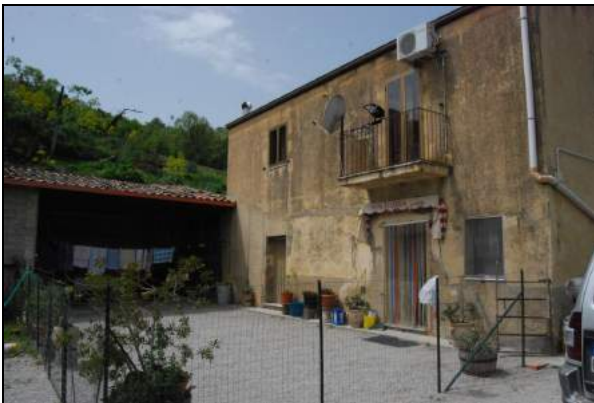
FOTO 36 – Nicosia - Foglio 68 – Particella 360 - Sub 1 – Veduta Est degli immobili di Contrada Scaletta
