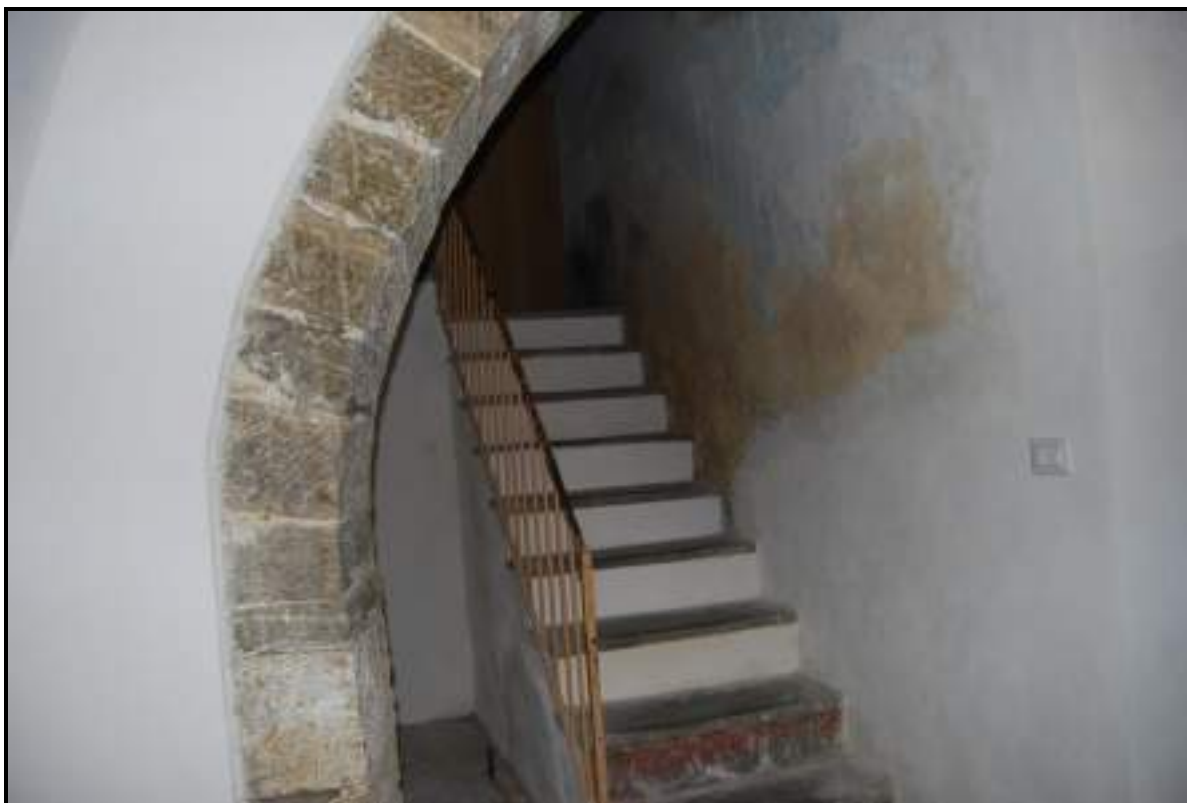
FOTO 72 – Nicosia - Foglio 82 – Particella 2669 – Sub. 1 – Piano terra – Vano scala
