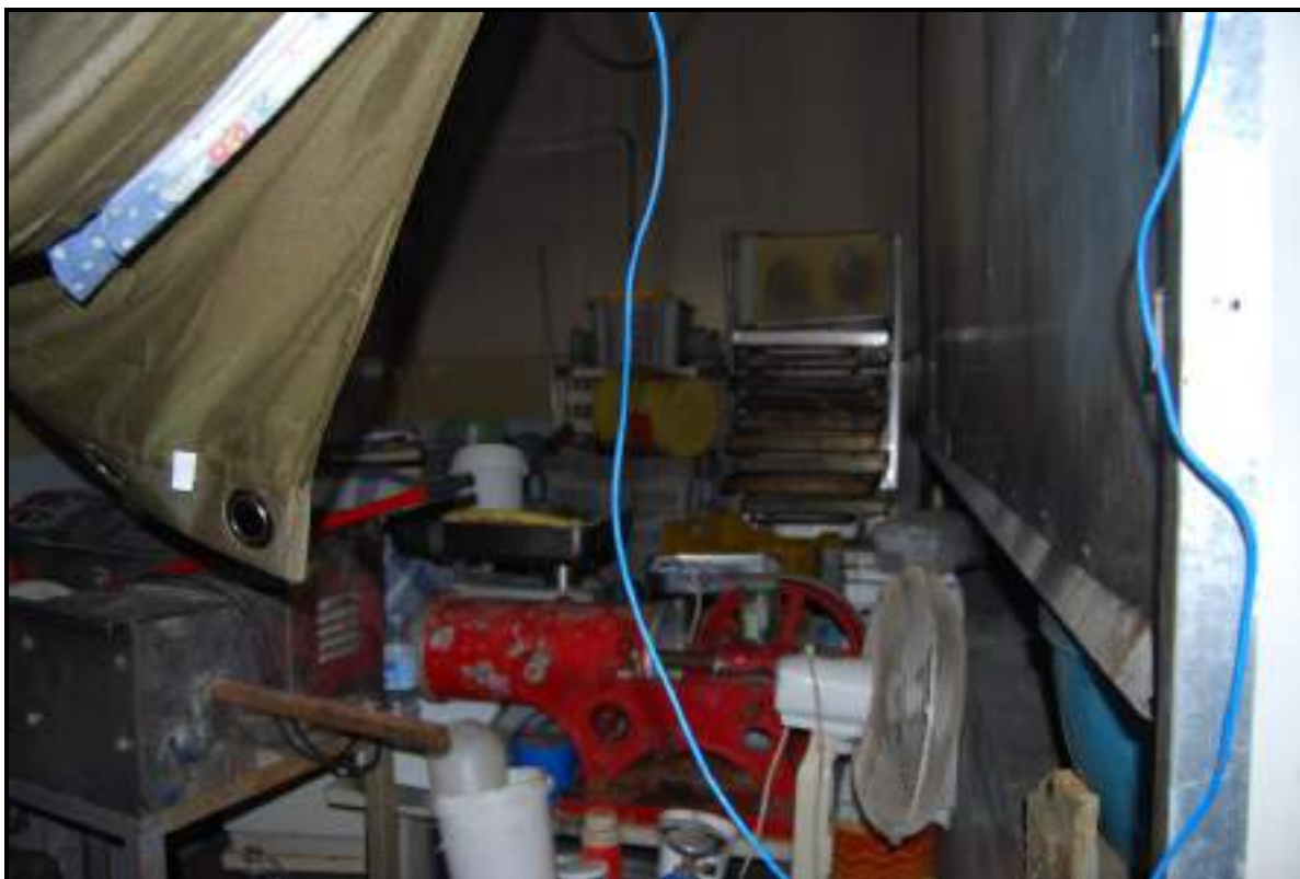
FOTO 55 – Nicosia - Foglio 68 – Particella 360 - Sub 2 – Piano terra – Locale forno
