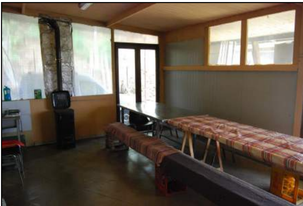
FOTO 56 – Nicosia - Foglio 68 – Particella 360 - Sub 2 – Veduta interna della porzione di portico coperto chiuso
