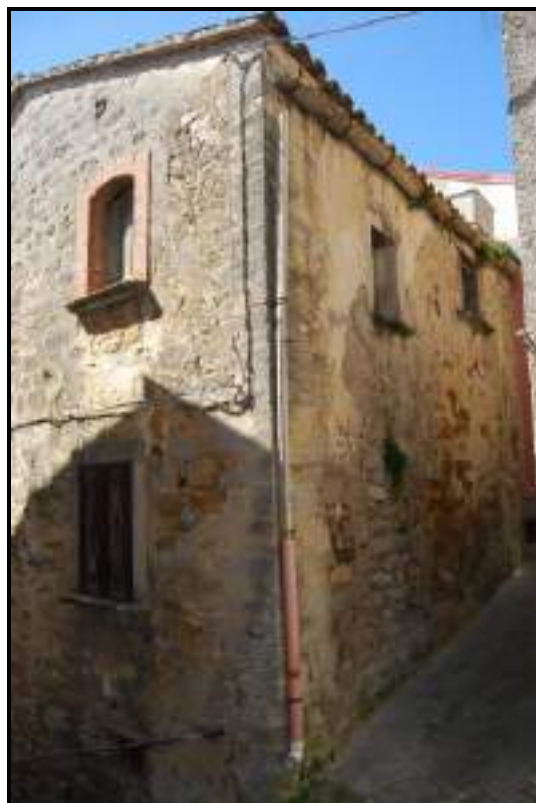
FOTO 69 – Nicosia - Foglio 82 – Particella 2669 – Veduta esterna del fabbricato su Via Cortile La Greca
