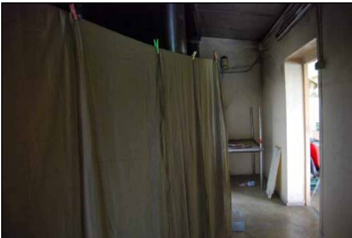
FOTO 54 – Nicosia - Foglio 68 – Particella 360 - Sub 2 – Piano terra – Locale forno
