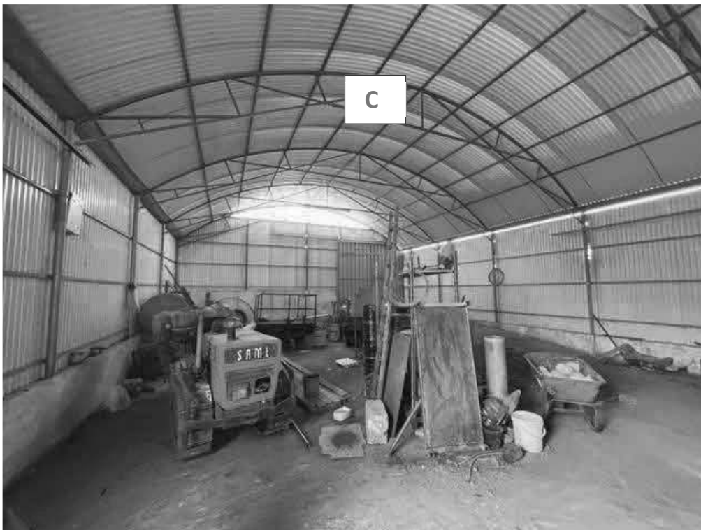
27 – Magazzino Avanserra C
