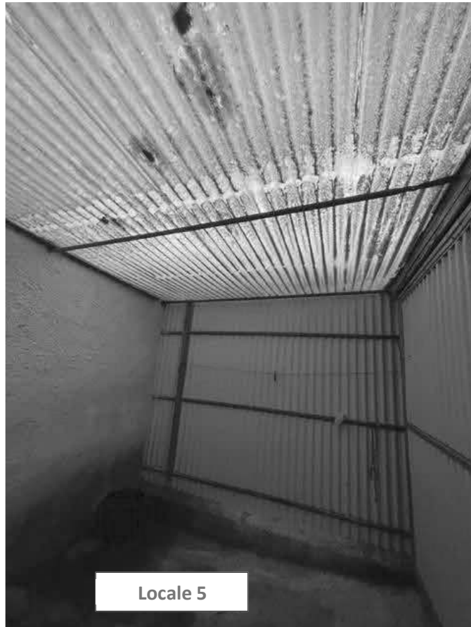
18 – Magazzino Avanserra B locale 5
