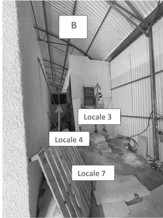
25 – Magazzino Avanserra B locale 7 -3 - 4
