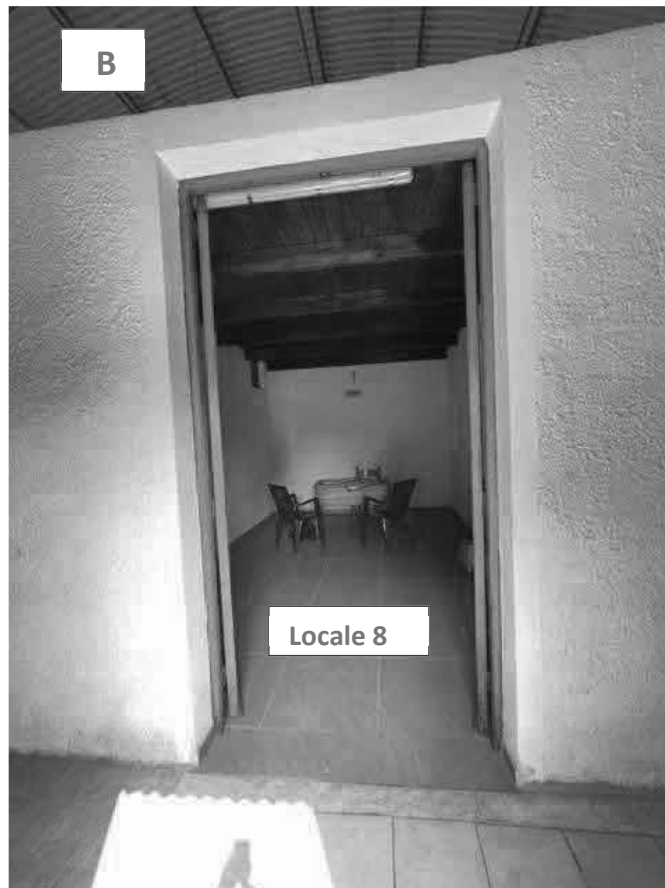
20 – Magazzino Avanserra B locale 8
