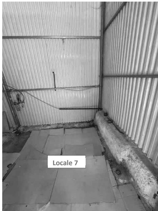
24 – Magazzino Avanserra B locale 7
