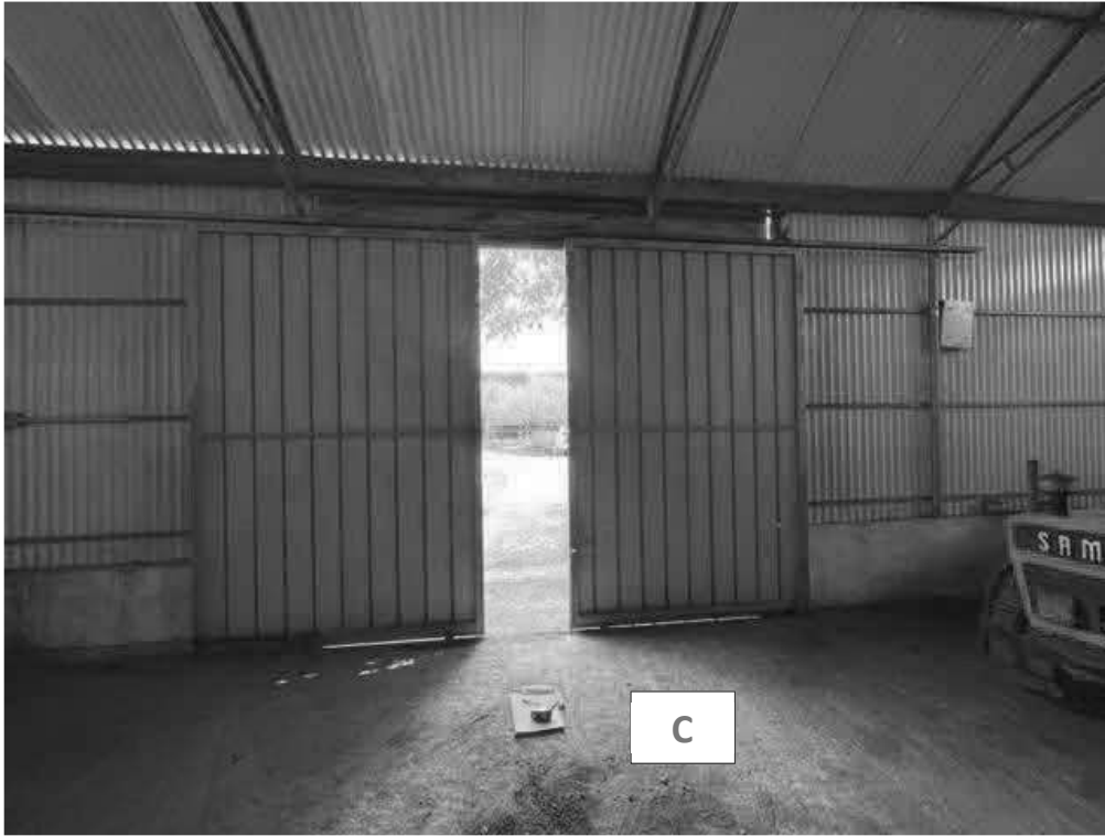
28 – Magazzino Avanserra C
