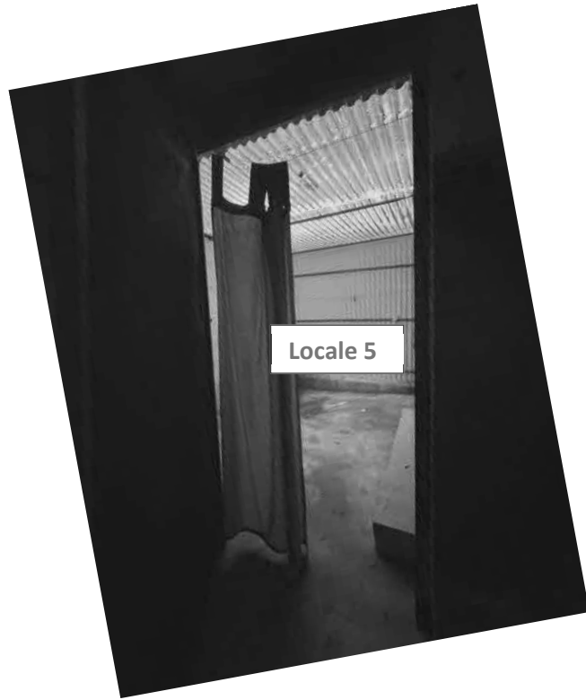
17 – Magazzino Avanserra B locale 5
