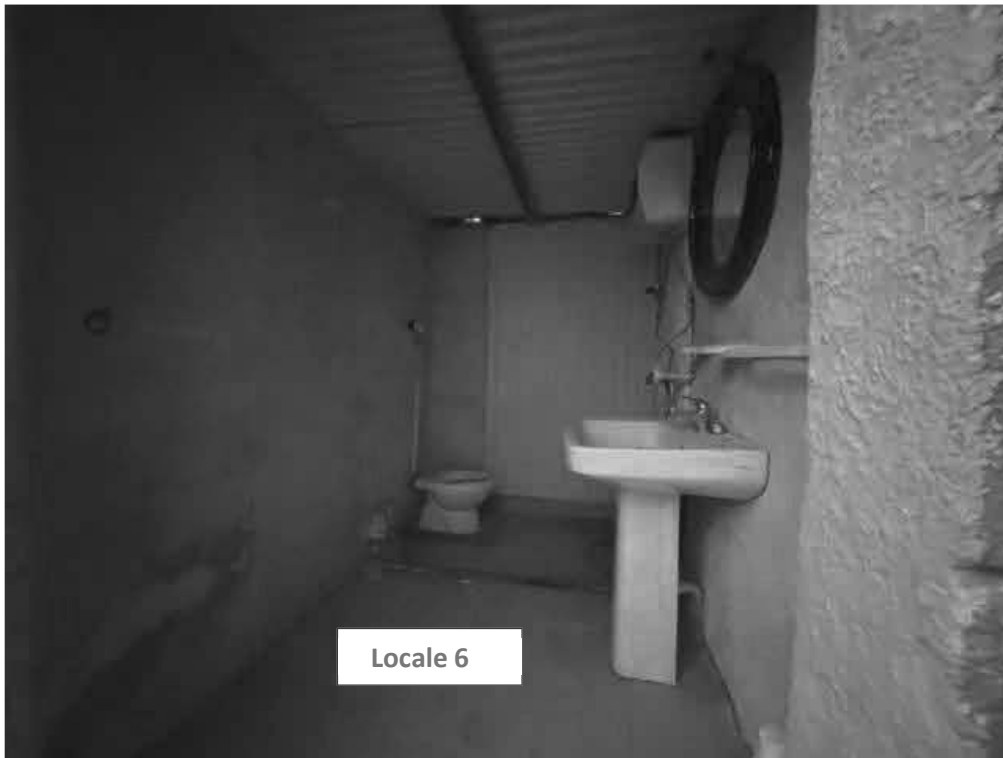
19 – Magazzino Avanserra B locale 6
