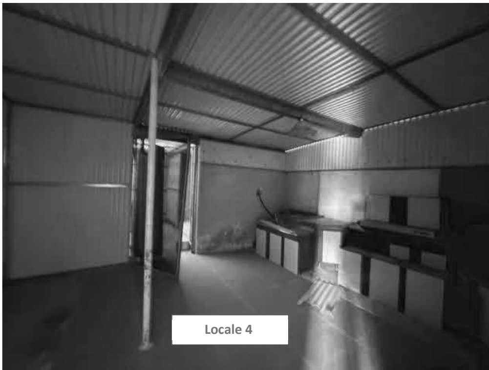
16 – Magazzino Avanserra B locale 4
