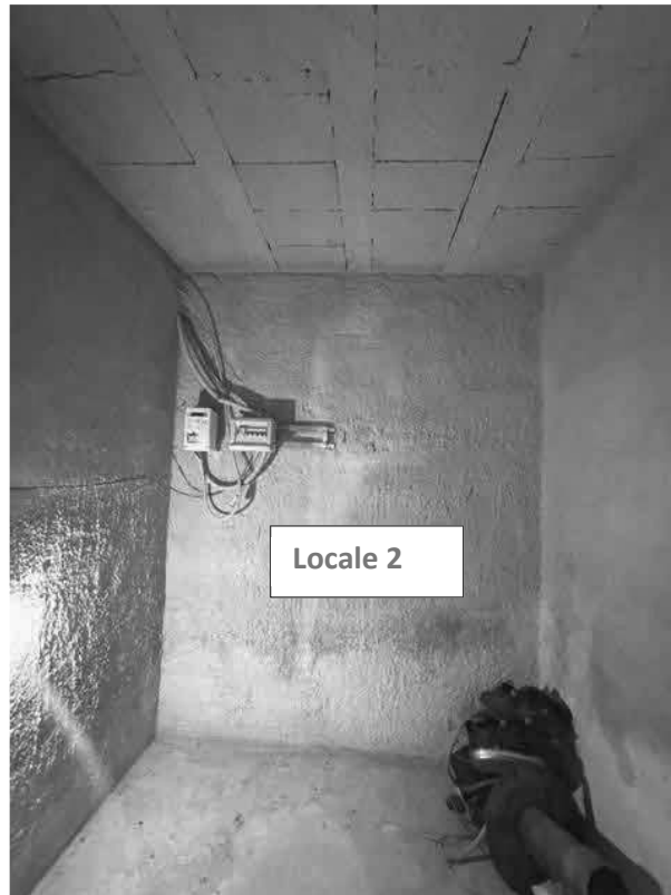
14 – Magazzino Avanserra A locale 2
