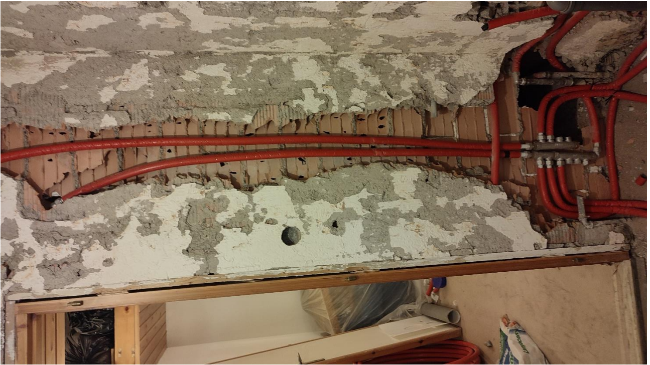
7) Particolare lavori in corso
