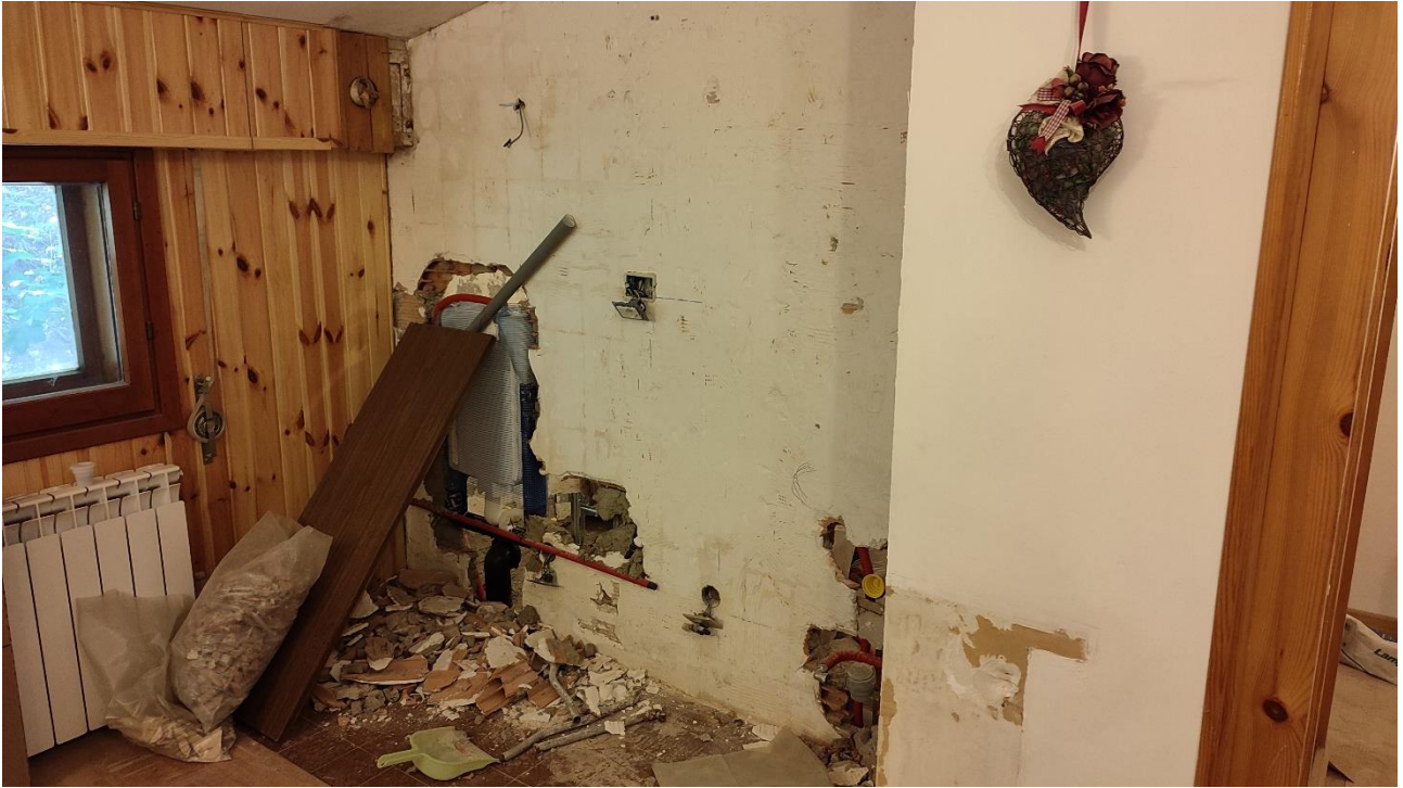
3) Angolo cucina (sono in corso lavori impiantistica)
