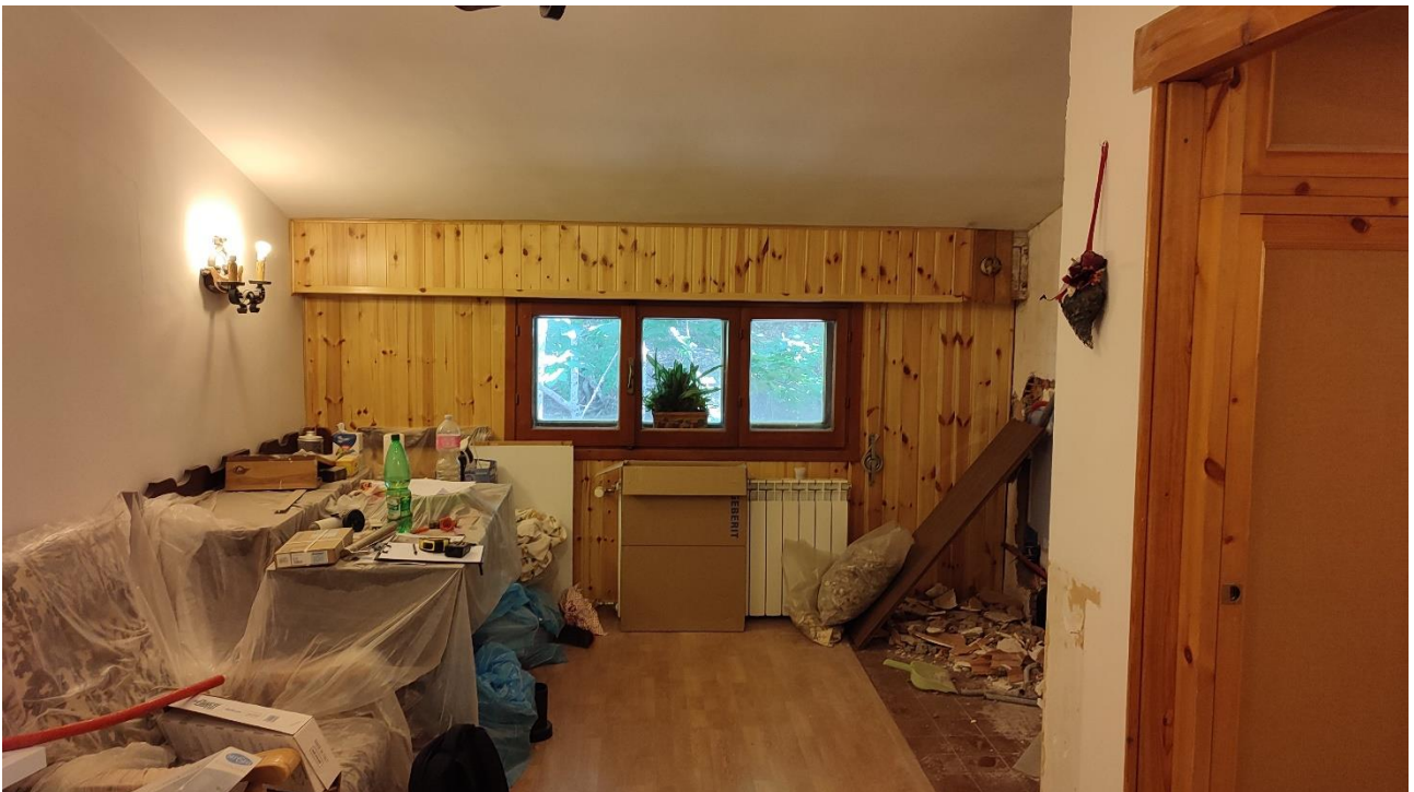
2) Soggiorno con angolo cucina a destra visto da ingresso
