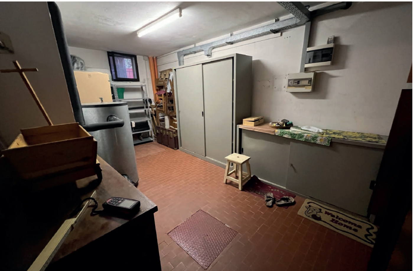
23_Centrale di condizionamento
