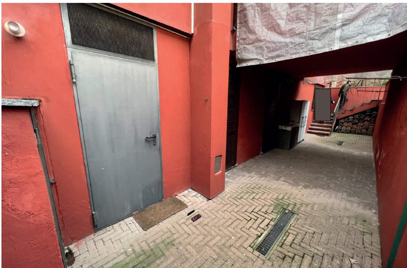
21_Disimpegno seminterrato aperto
