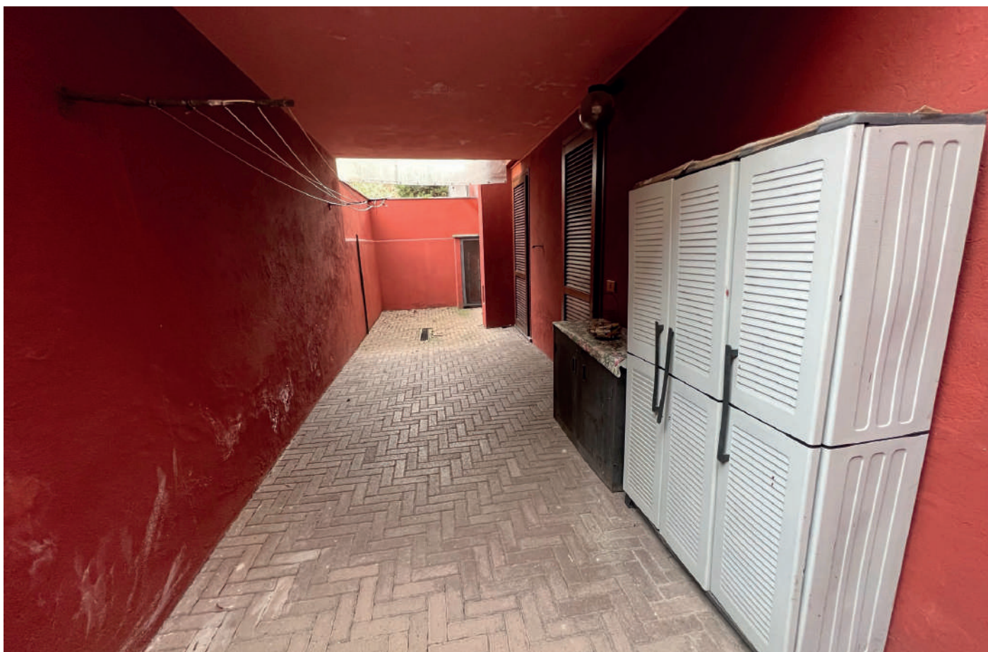
20_Disimpegno seminterrato aperto
