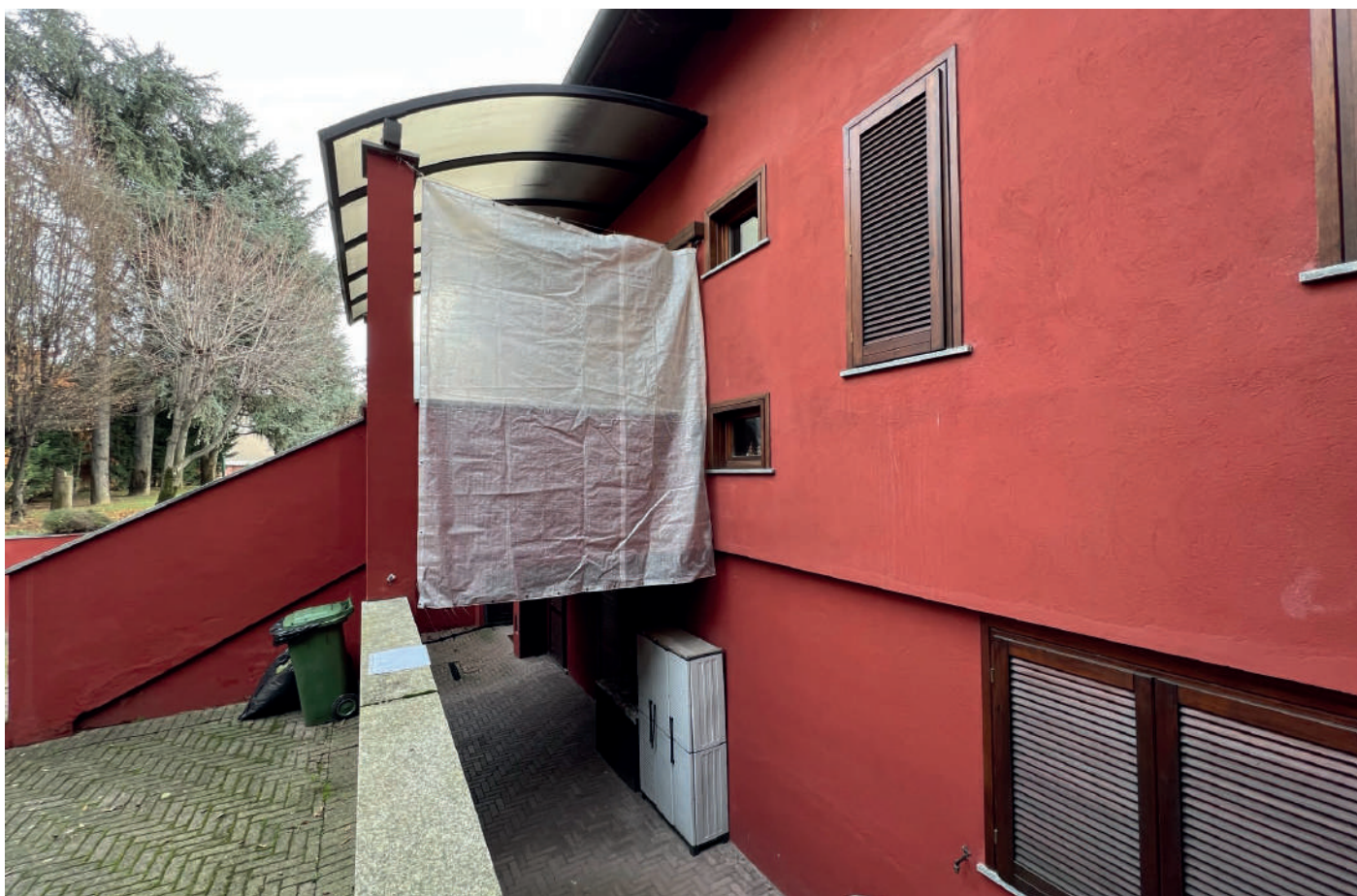
16_Disimpegno seminterrato aperto
