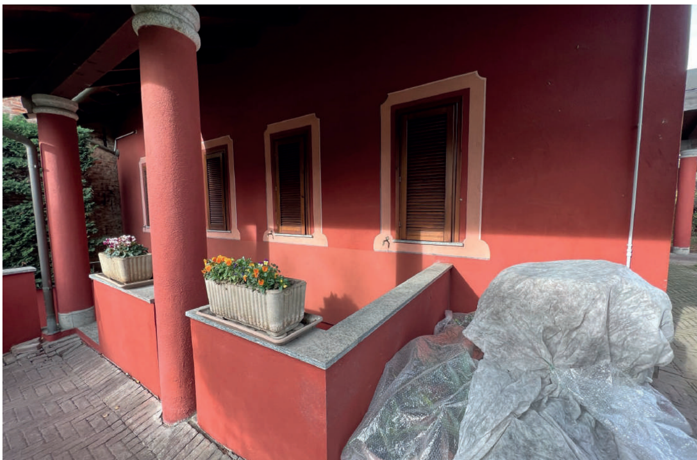
5_Portico sud sopra le scale di salita dal garage
