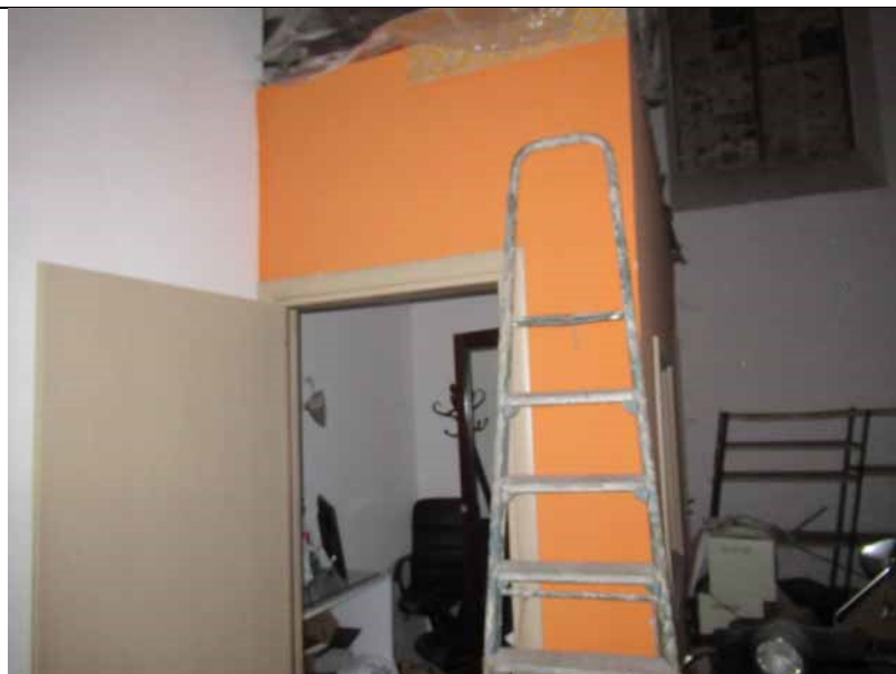
foto n° 8: Vista laterale del box realizzato all'interno del magazzino
