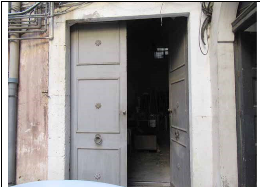
foto n° 4: Vista dell'ingresso del magazzino
