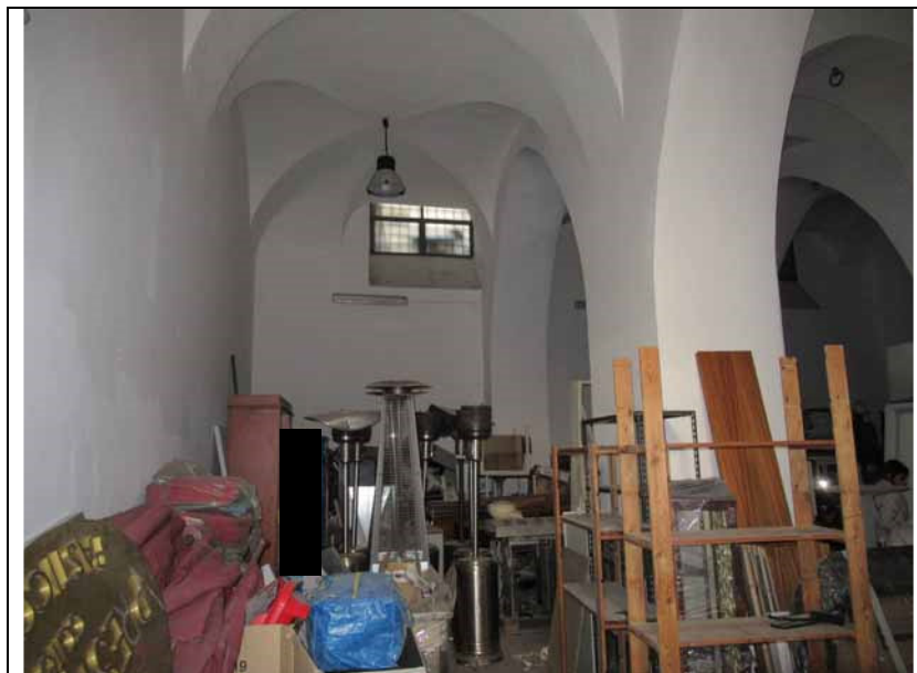
foto n° 6: Vista interna del magazzino
