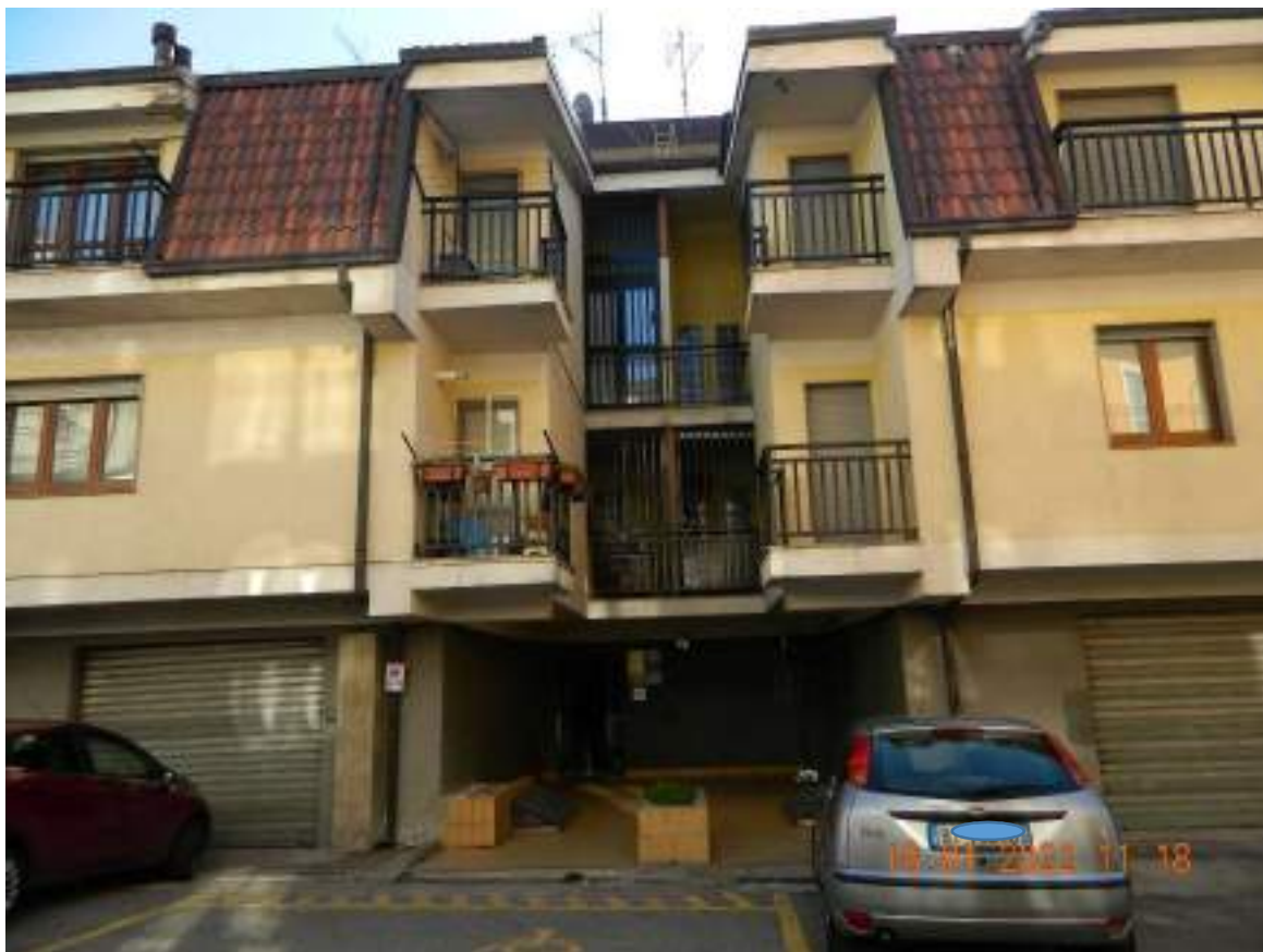
Ingresso al vano scala condominiale
