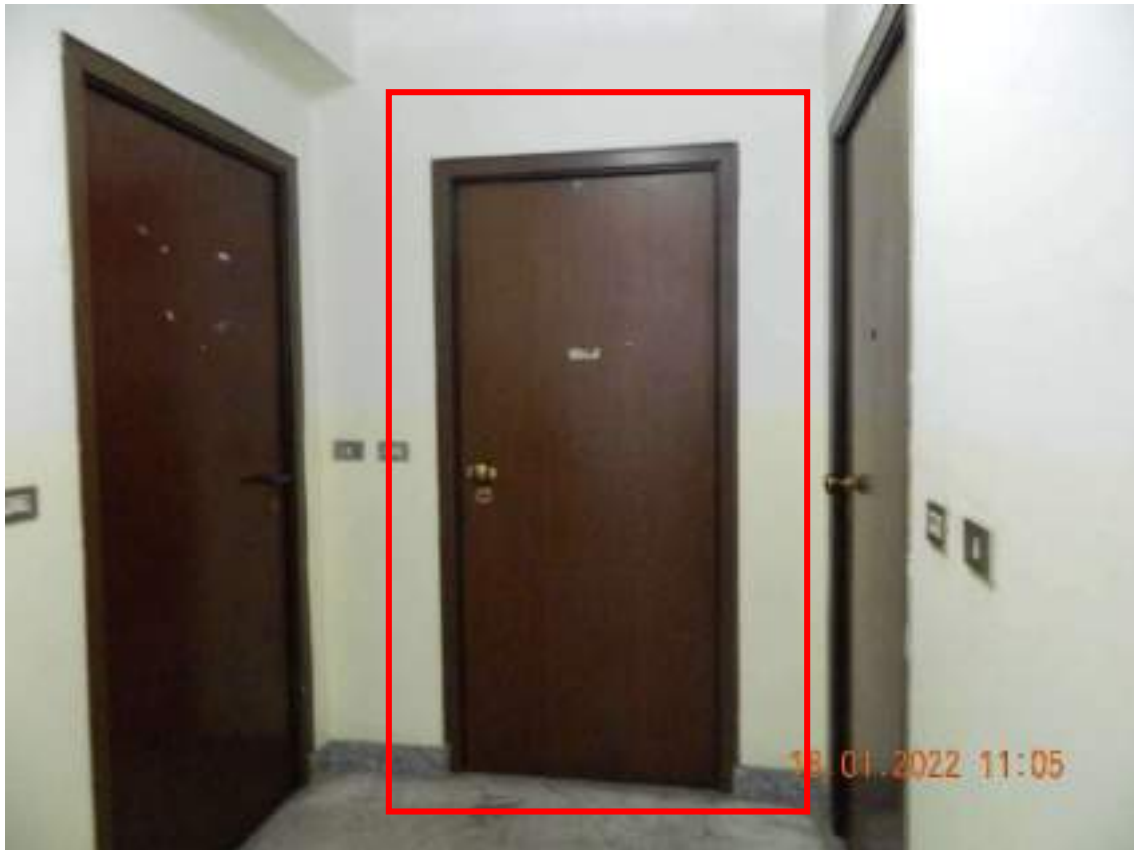
Porta di ingresso Unità immobiliare oggetto di esecuzione
