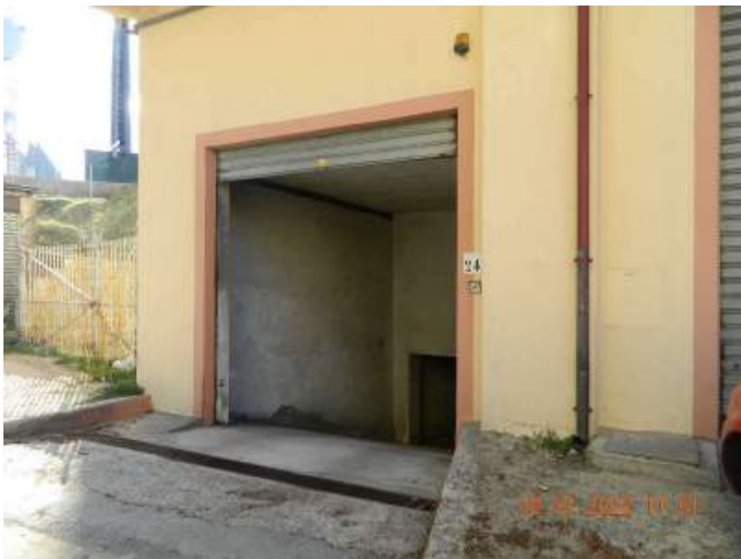
Ingresso condominiale ai box auto
