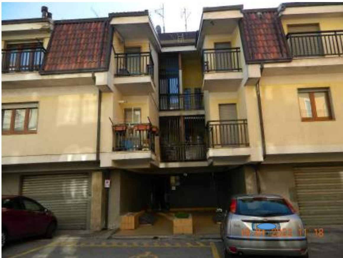
Ingresso al vano scala condominiale
