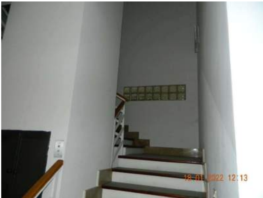
Piano terra – scala di accesso al piano primo
